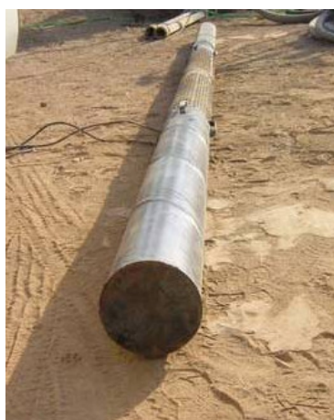
Figura 3.16: Tapa circular metálica soldada al final de la tubería de revestimiento. Fuente: Sondeos Puebla.
