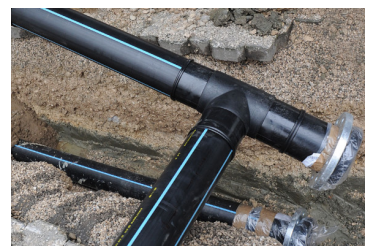
Figura 5.3: Elementos de una tubería de PE termosoldados a tope. Fuente: Grupo Hidráulica.
