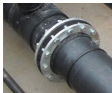
Figura 5.6: Unión de tuberías mediante aro de cuello y brida loca. Fuente: Grupo Hidráulica.
