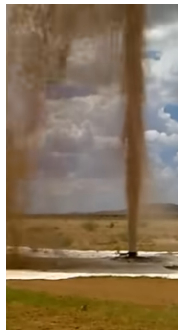
Figura 4.2: Fotograma de columna de agua vaciando un sondeo profundo por la adición de hielo seco. El revestimiento es de unos 60 cm de diámetro y se han añadido 500 kg de hielo seco en bloques. Fuente: @MicanaldeyoutubeNETO.
