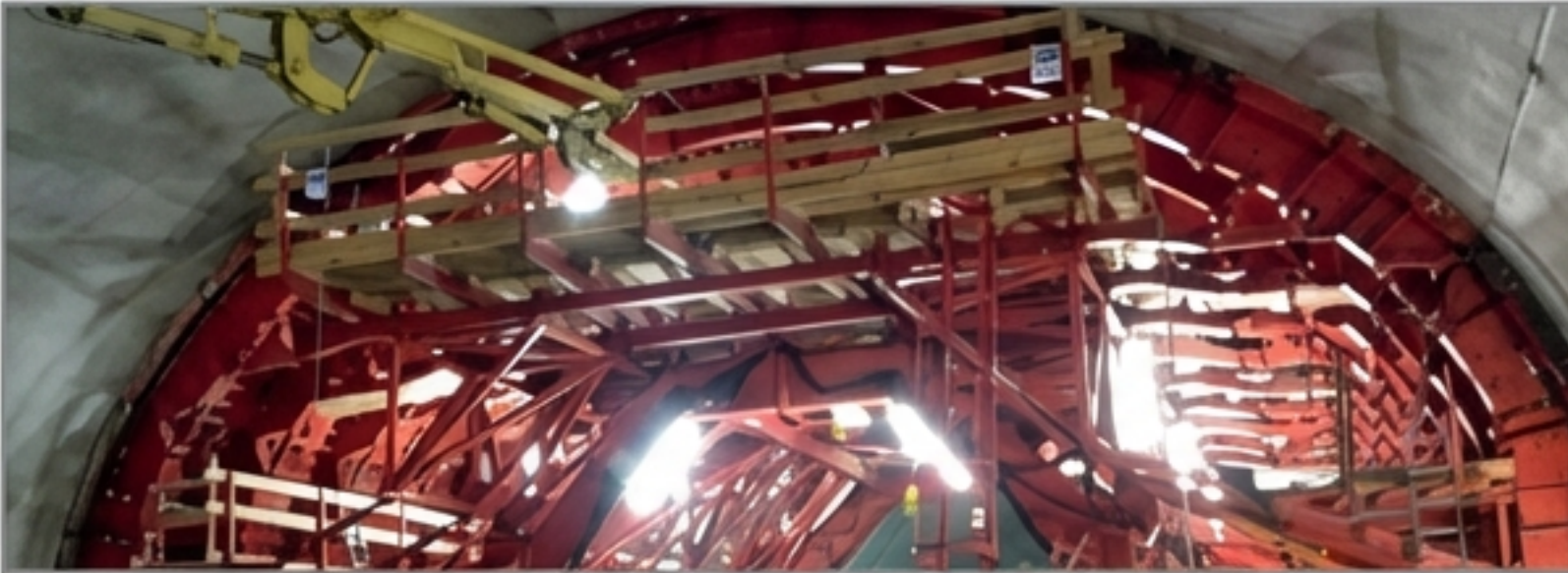
Revestimiento de Túneles
