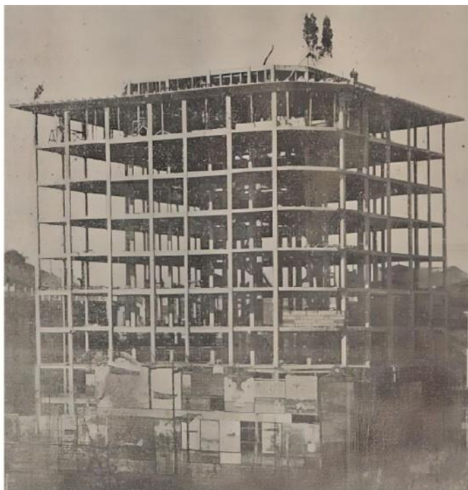
Figura 7. Construcción de forjados del edificio del Banco Pastor (30)
