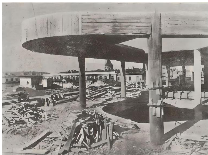
Figura 11. Detalle de la estructura del Hotel Nacional Voladizos en terraza
