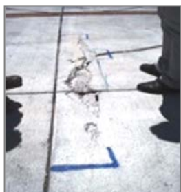
FISURAS EN LOSAS DE HORMIGÓN
