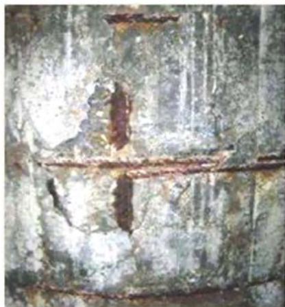
LIMPIEZA Y RETIRADA DEL ÓXIDO DE LA ARMADURA
