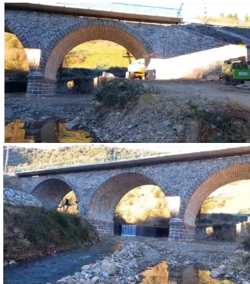
ESTADO FINAL TRAS REHABILITACIÓN Y TRATAMIENTO CON TOPSEAL ® :
