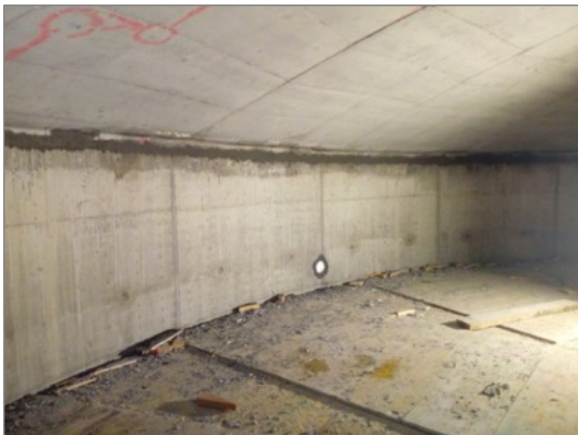
SANEADO Y SELLADO JUNTA ALZADO-CÚPULA
