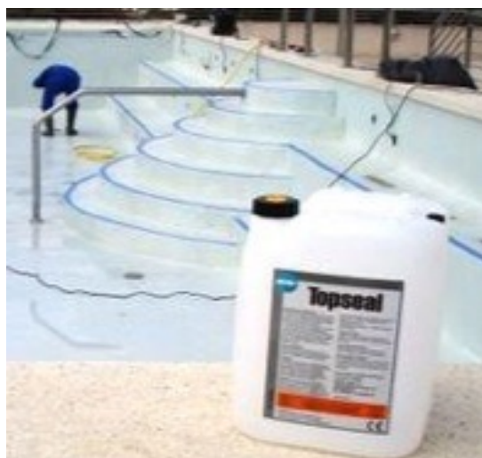
Repaso de fisuras
