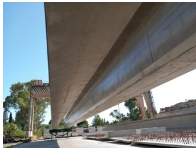
APLICACIÓN DE INNERSEAL ® EN VIGAS - ALTA DOSIFICACIÓN: 0,6 L/M2
