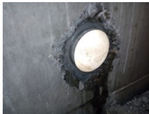
REPARACIÓN Y SELLADO INTERIOR DE PASAMUROS
