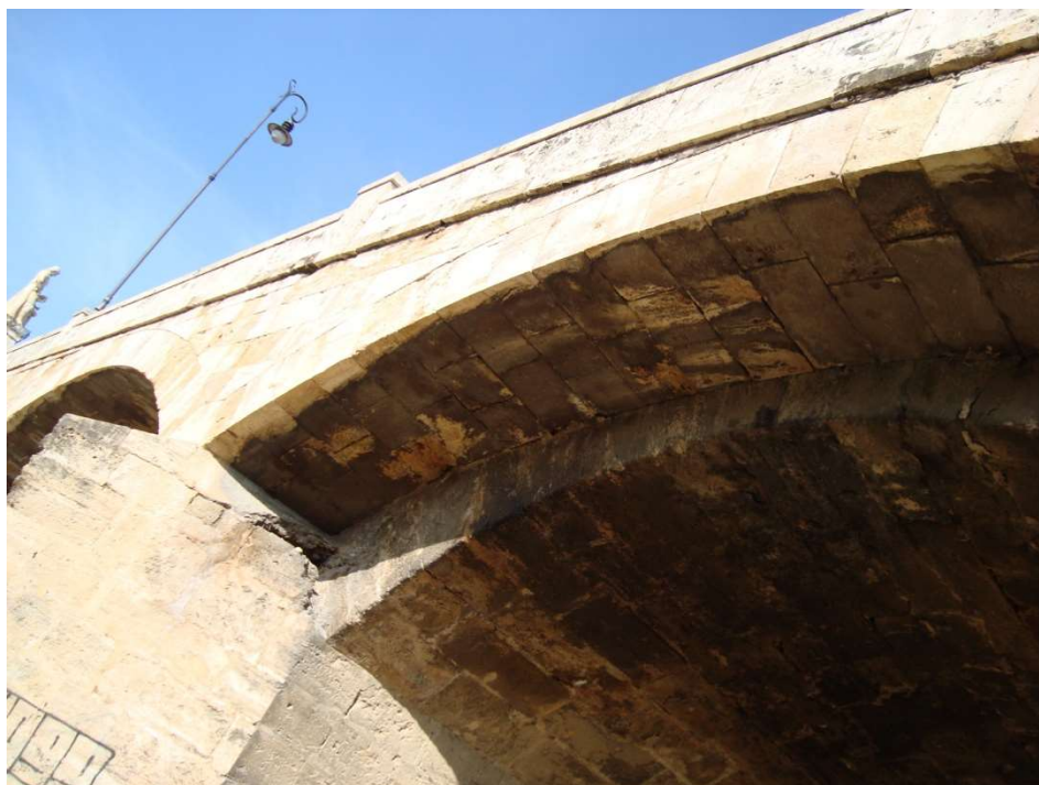
Figura 8. Puente de San José. Fotografía de V. Yepes.
