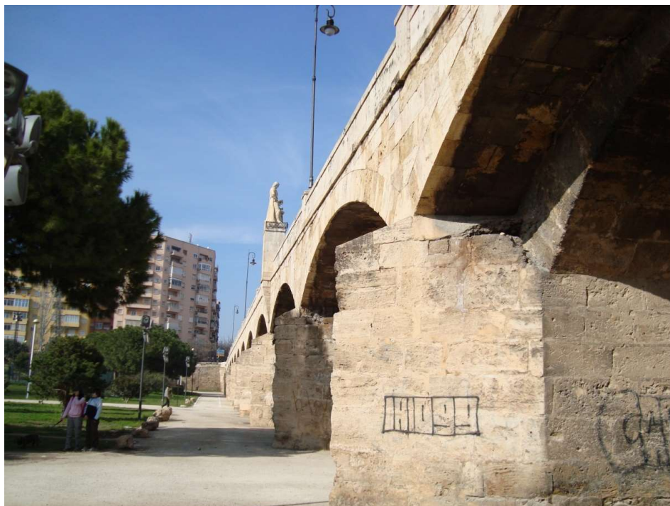
Figura 7. Puente de San José. Fotografía V. Yepes.
