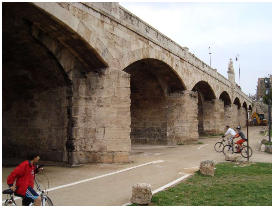
Figura 10. Puente de San José. Fotografía V. Yepes.
