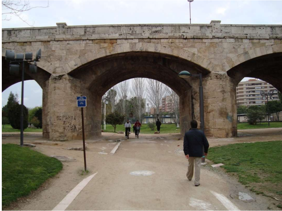
Figura 4. Puente de San José. Fotografía V. Yepes.
