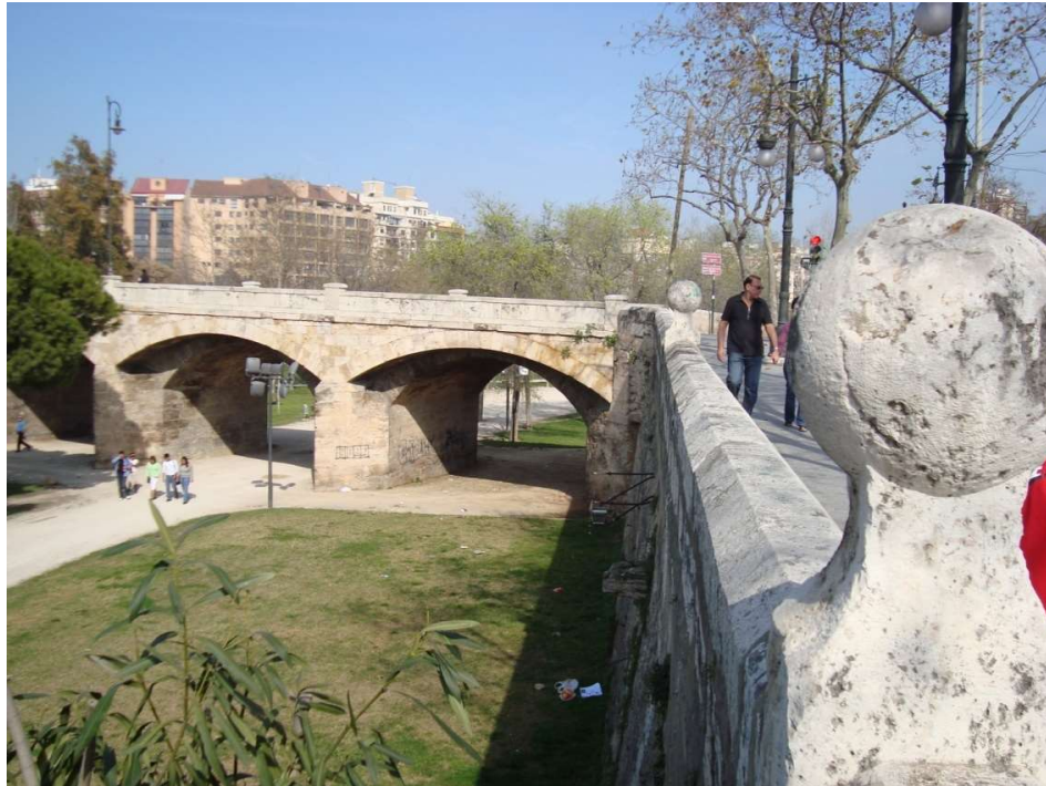
Figura 6. Puente de San José. Fotografía V. Yepes.
