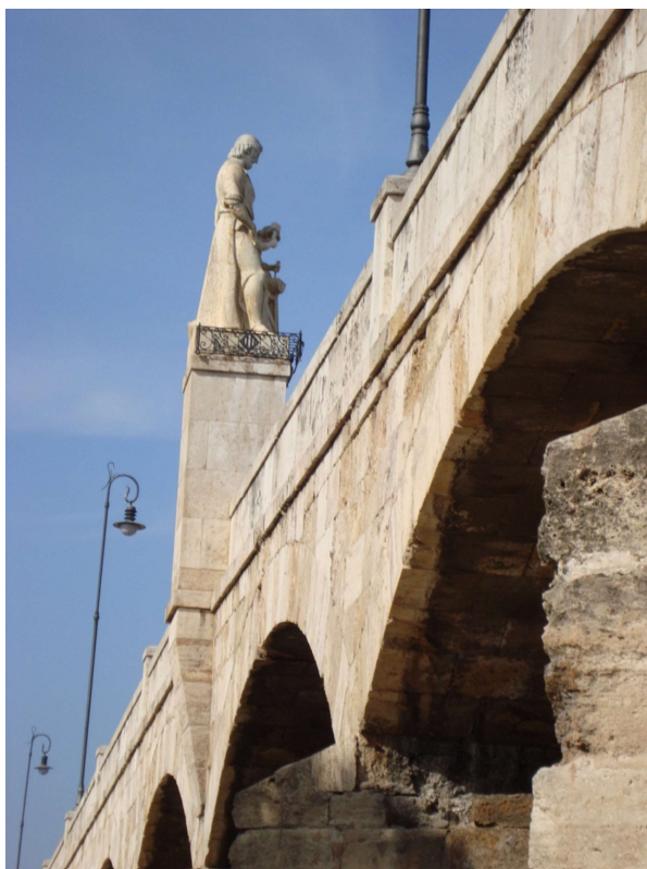
Figura 9. Puente de San José. Fotografía de V. Yepes.
