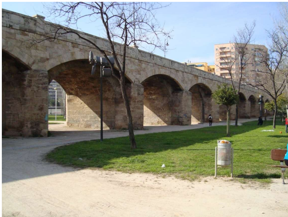
Figura 1. Puente de San José. Fotografía V. Yepes.
