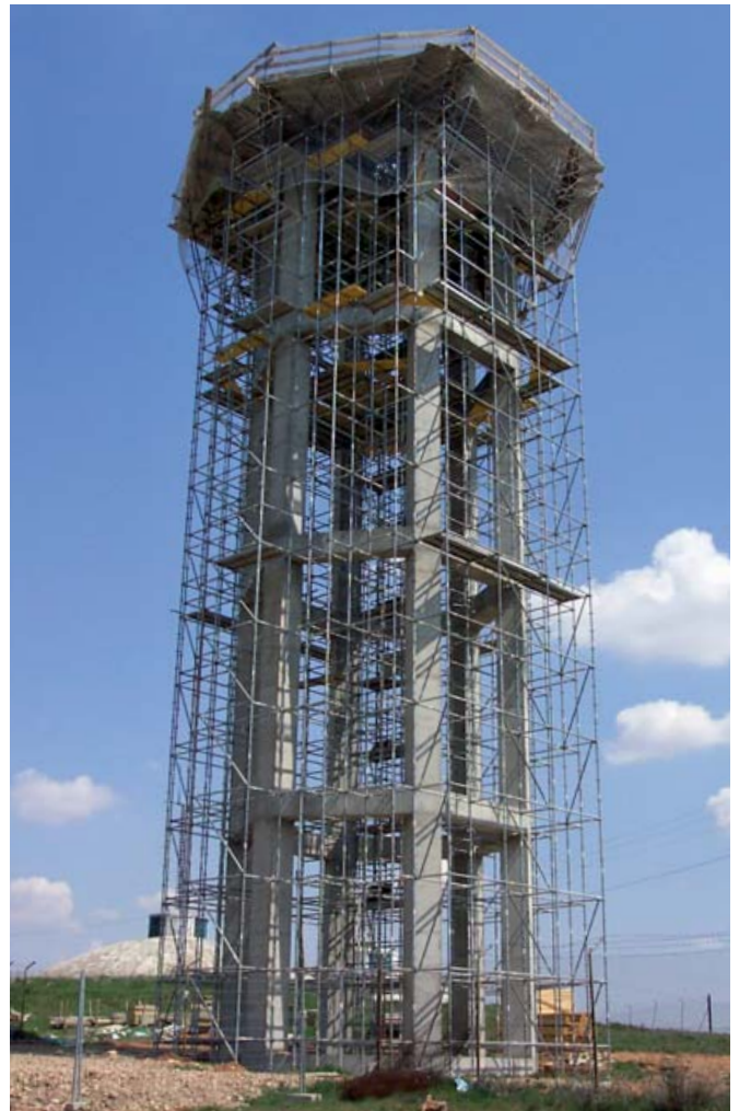
▲ Apeo de depósito a 24 m de altura
