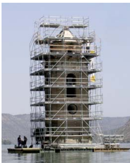
▲ Montaje de andamio en torre
