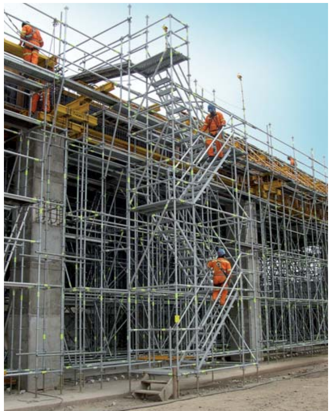
▲ Escalera de acceso al encofrado en la ampliación del Aeropuerto Jorge Chávez, Lima, Perú
