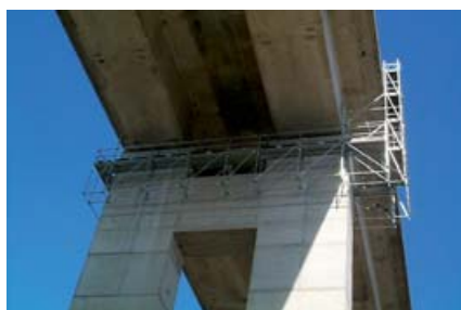
▲ Andamio en vuelo para trabajos de mantenimiento en viaducto
