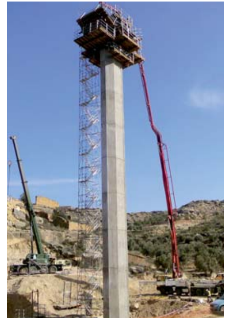
▲ Escalera de acceso al encofrado de la cabeza de la pila
