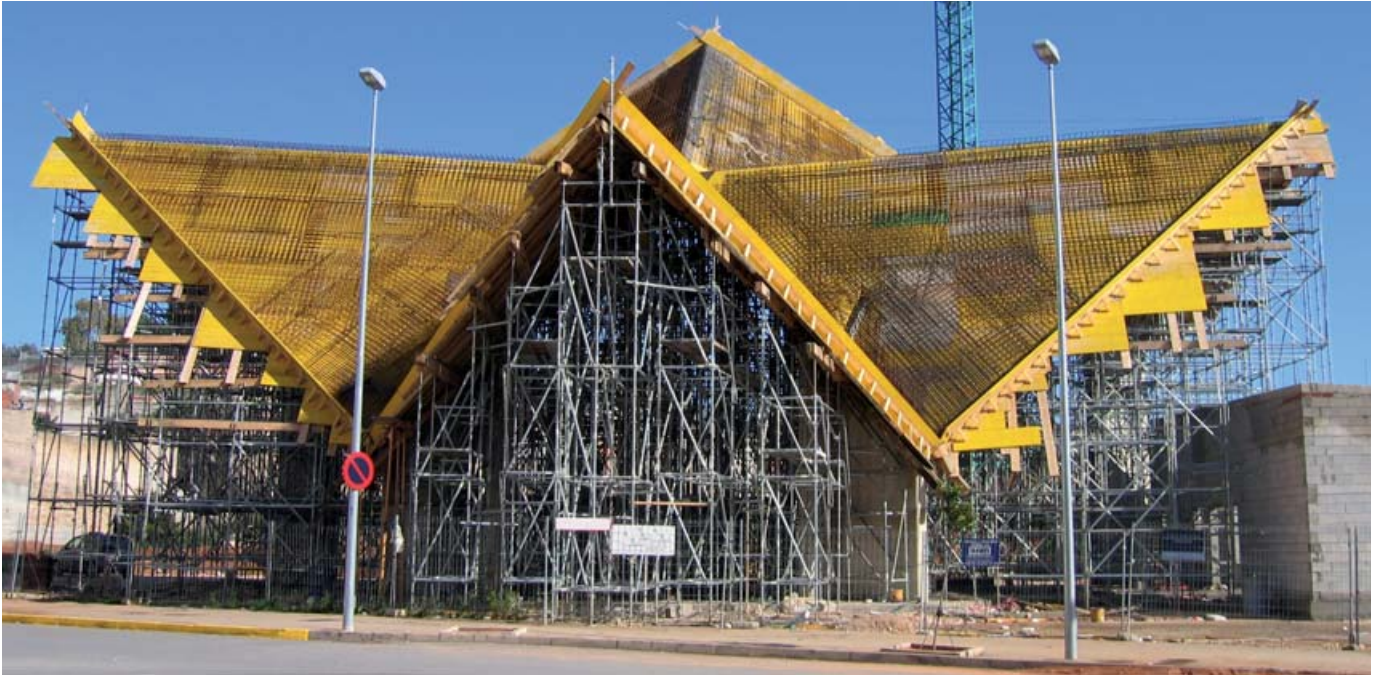
▲ Cimbra BRIO, en el apeo de losa de cubierta de la Iglesia de la Sagrada Familia en Alzira, Valencia, España
