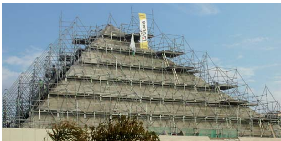
▲ Andamio Multidireccional BRIO en fachada inclinada
