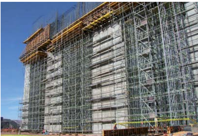
▲ Ejecución de losas a gran altura
