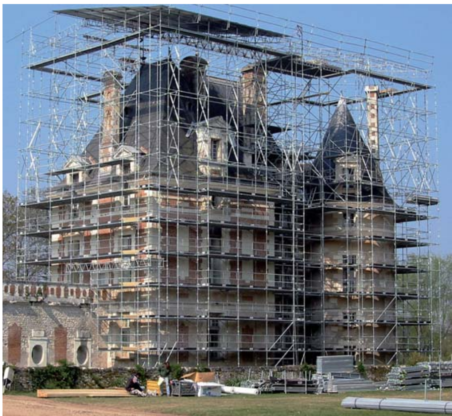
▲ Cubierta a gran altura sin posibilidad de amarres en el Château de Selles sur Cher, Francia
