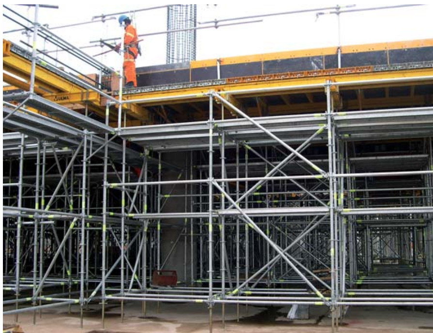
▲ Generación de espacios de trabajo seguros en la zona de montaje del encofrado y en las zonas perimetrales ▲
