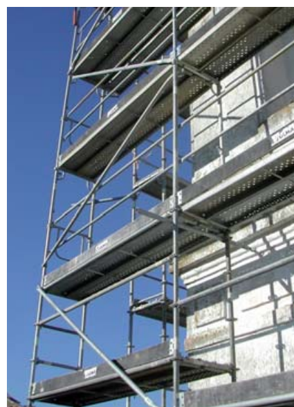
▲ Andamio Multidireccional BRIO en la parte irregular de apoyo y Andamio de Marco DORPA en la parte superior ▲
