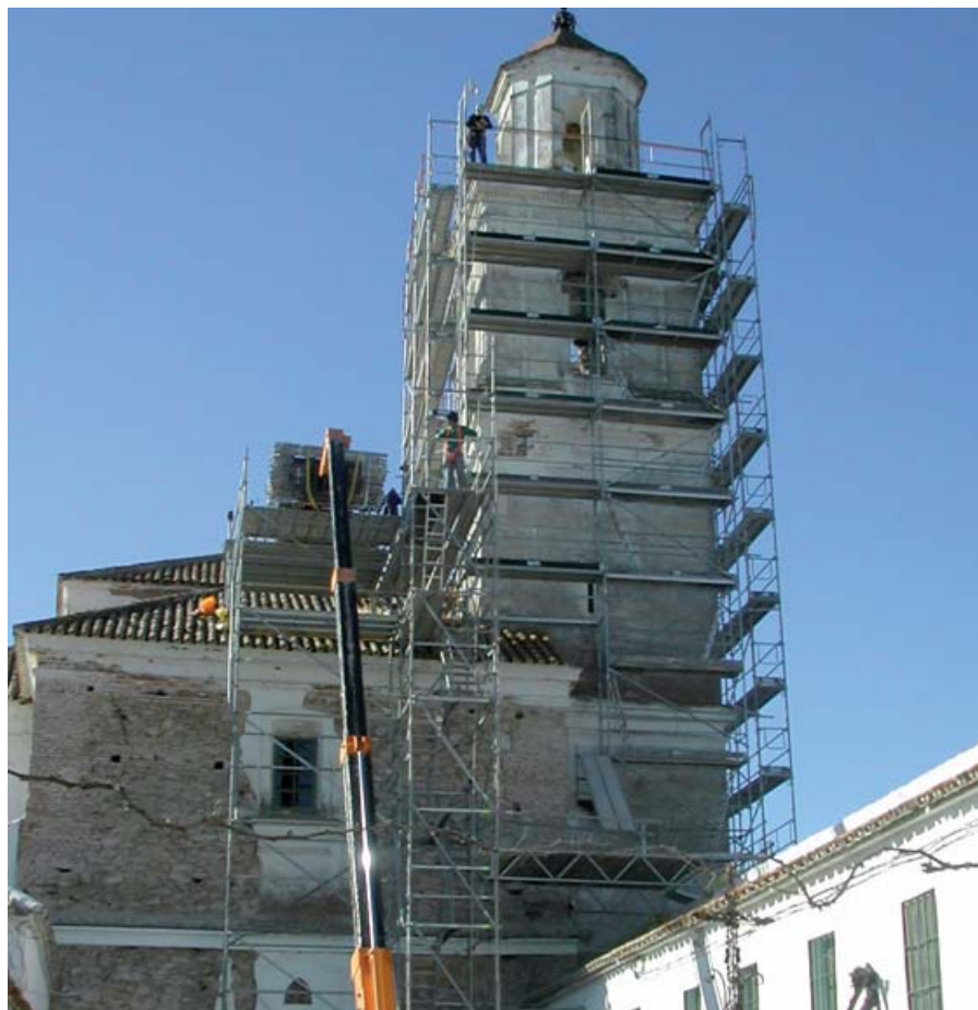
▲ Andamio Multidireccional BRIO en la parte irregular de apoyo y Andamio de Marco DORPA en la parte superior ▲
