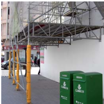
▲ Pies verticales del andamio resguardados por tubos protectores en paso de peatones
