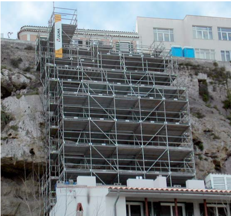
▲ Montaje de andamio sobre acantilado
