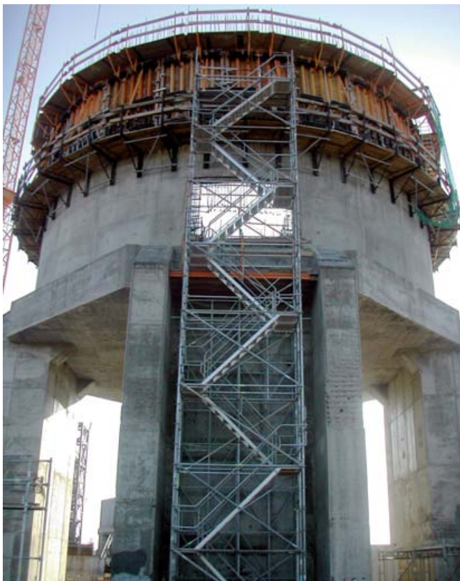
▲ Acceso al encofrado en ejecución de silo
