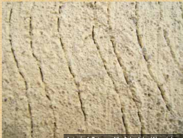
Autovía A-7, tramo Albuñol - Adra (Almería)
