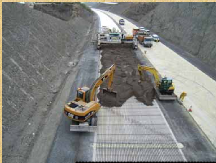
Autovía A-7, tramo Albuñol - Adra (Almería)
