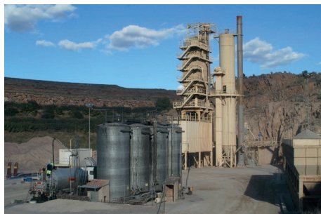
Figura 1.6. Planta de aglomerado asfáltico en caliente.
