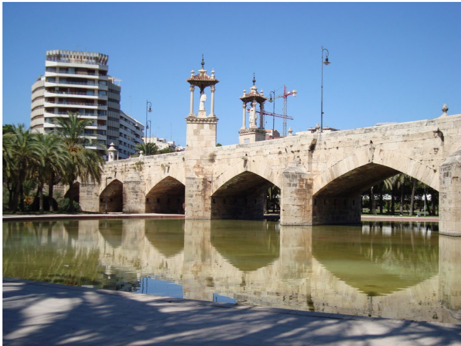
Figura 8. Puente del Mar. Fotografía de V.Yepes.
