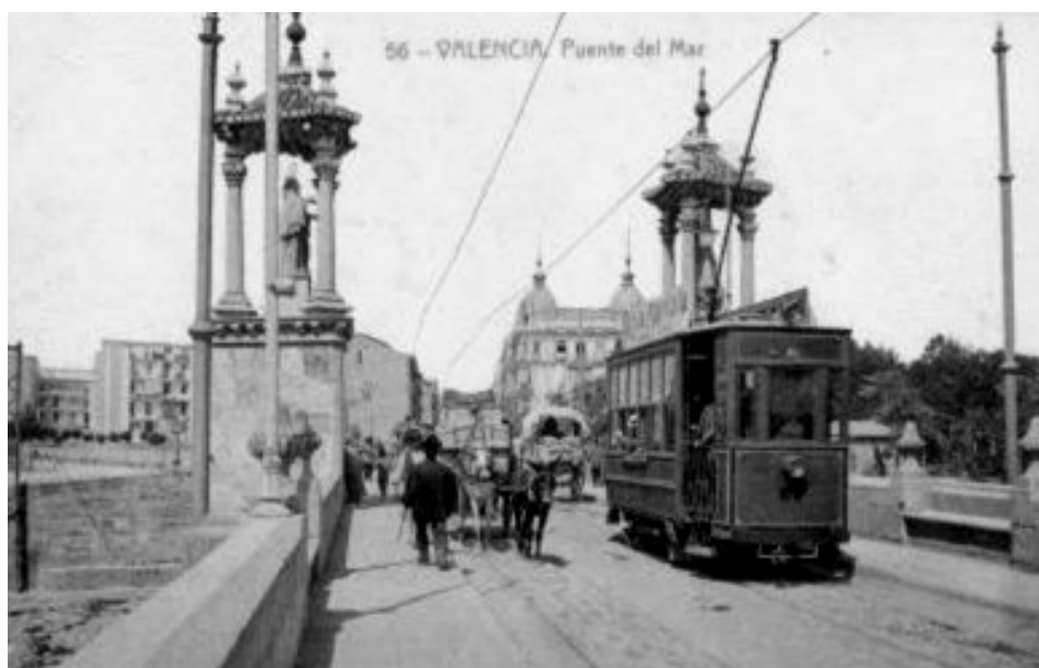
Figura 7. Puente del Mar.
