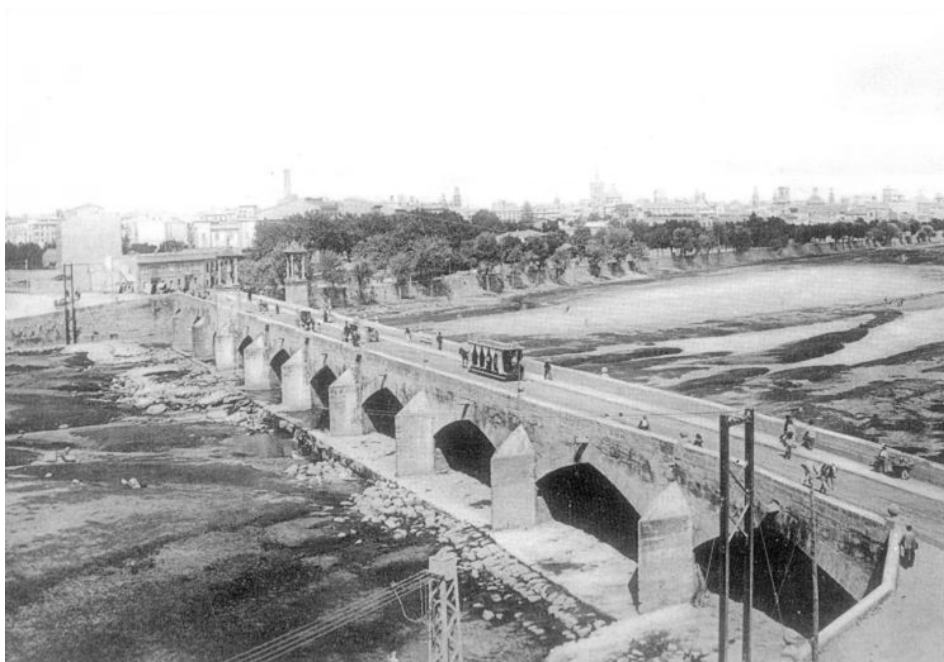
Figura 6. Puente del Mar, 1915.
