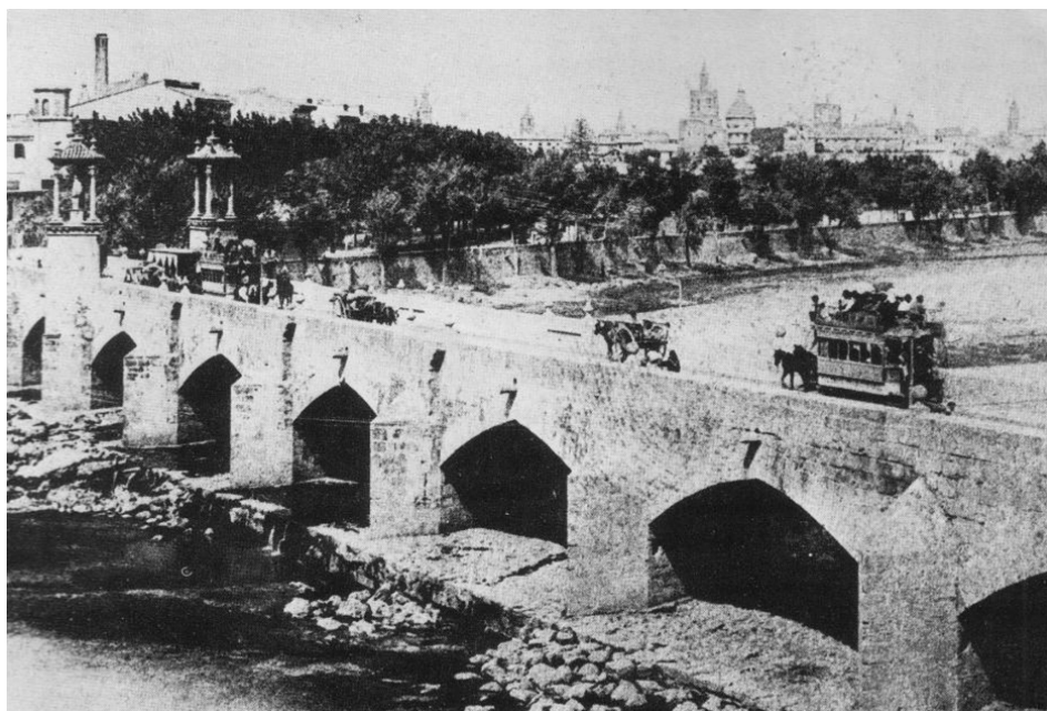
Figura 4. Puente del Mar, 1895.
