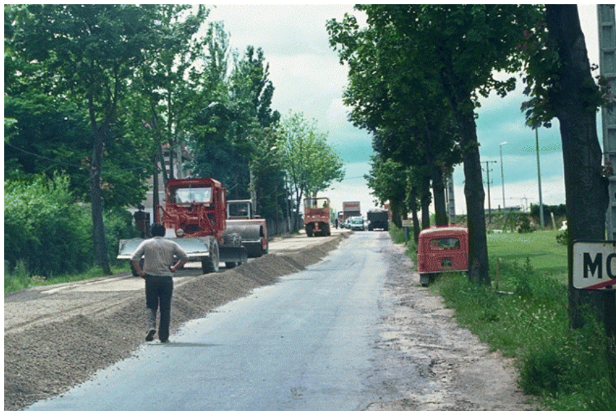
Foto 8.- Extensión de grava-emulsión con motoniveladora. Cordón inicial.
