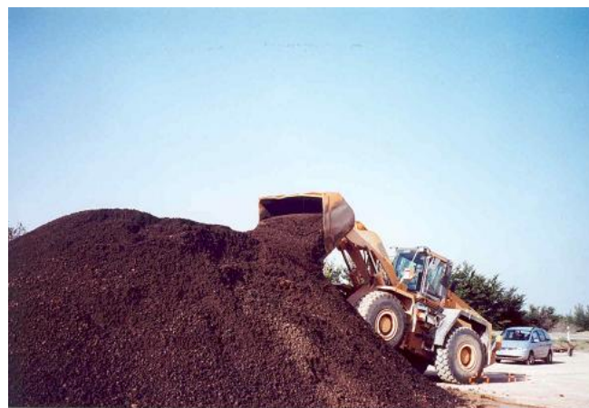
Foto 6.- Acopio de grava-emulsión
