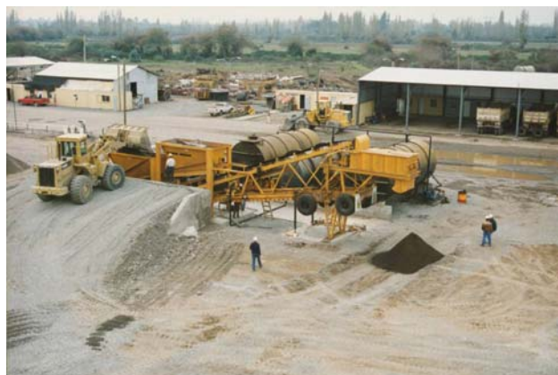
Foto 5.- Planta sencilla de fabricación de grava-emulsión
