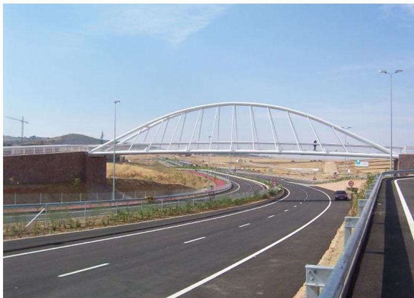
Foto 14.- Aspecto final de la Ronda Norte
