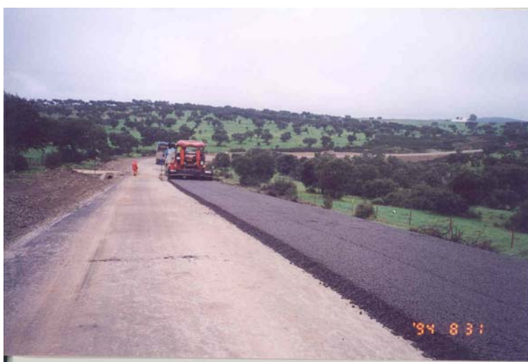
Foto 7.- Proceso de extensión de grava-emulsión con extendedora
