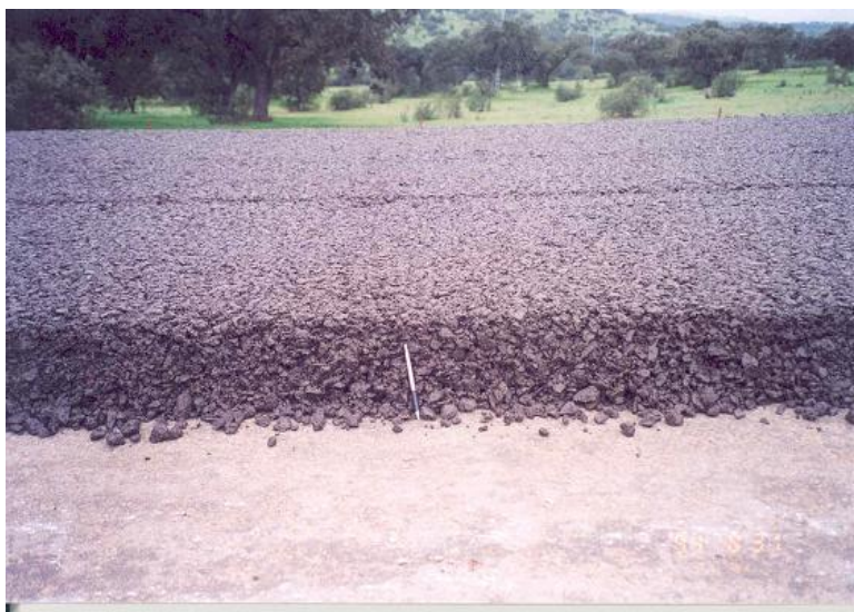
Foto 12.- Espesor de la grava-emulsión en la obra Malcocinado
