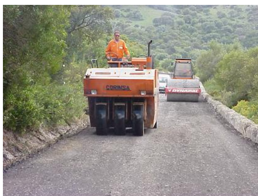
Foto 9.- Equipos de compactación de grava-emulsión
