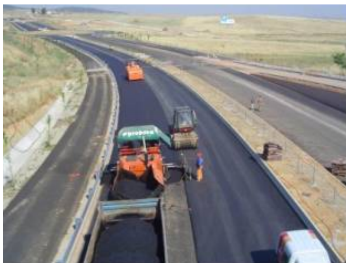
Foto 13.- Extensión y compactación de la grava-emulsión en la Ronda Norte
