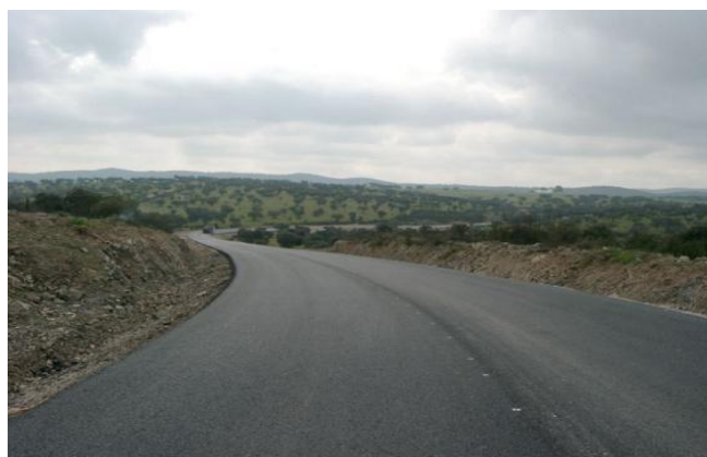
Foto 10.- Aspecto final de la obra Malcocinado
