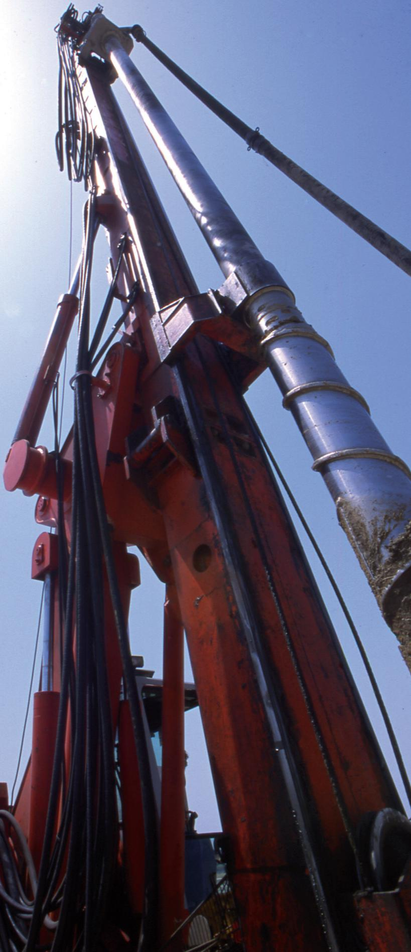
La técnica de las Columnas de Módulo Controlado (CMC) consiste en mejorar el suelo de manera global mediante la ejecución de una red de inclusiones verticales semi-rígidas. A diferencia de los pilotes que deben sustentar la totalidad de las cargas de la obra, este tipo de refuerzo pretende reducir el asiento total y diferencial liberando al suelo de una parte de las cargas.
