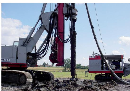
La herramienta se atornilla en el suelo hasta alcanzar la profundidad deseada y luego se remonta lentamente sin escombros. Entonces se incorpora una lechada o mortero en el suelo a baja presión (generalmente inferior a 0.5 MPa) a través del taladro hueco para constituir una columna de material cementado.
