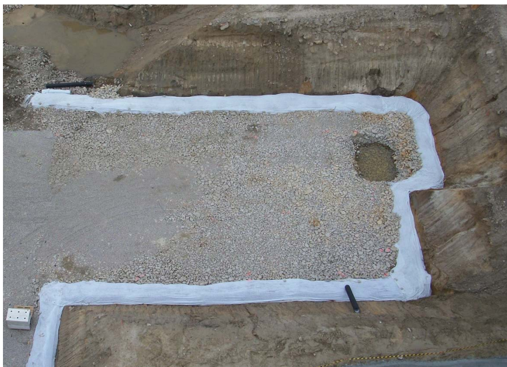
Figura 4. Material homogéneo en formación de encepado de columnas de grava
