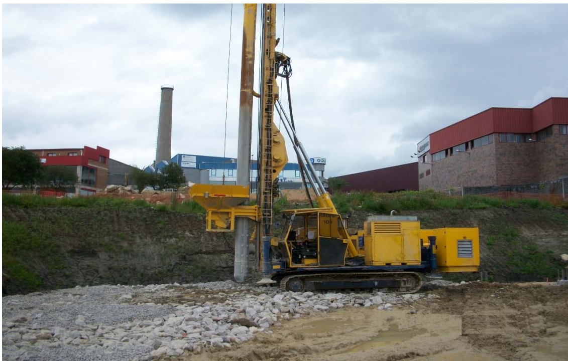
Figura 1. Máquina de columnas de grava preparada para comenzar la perforación
