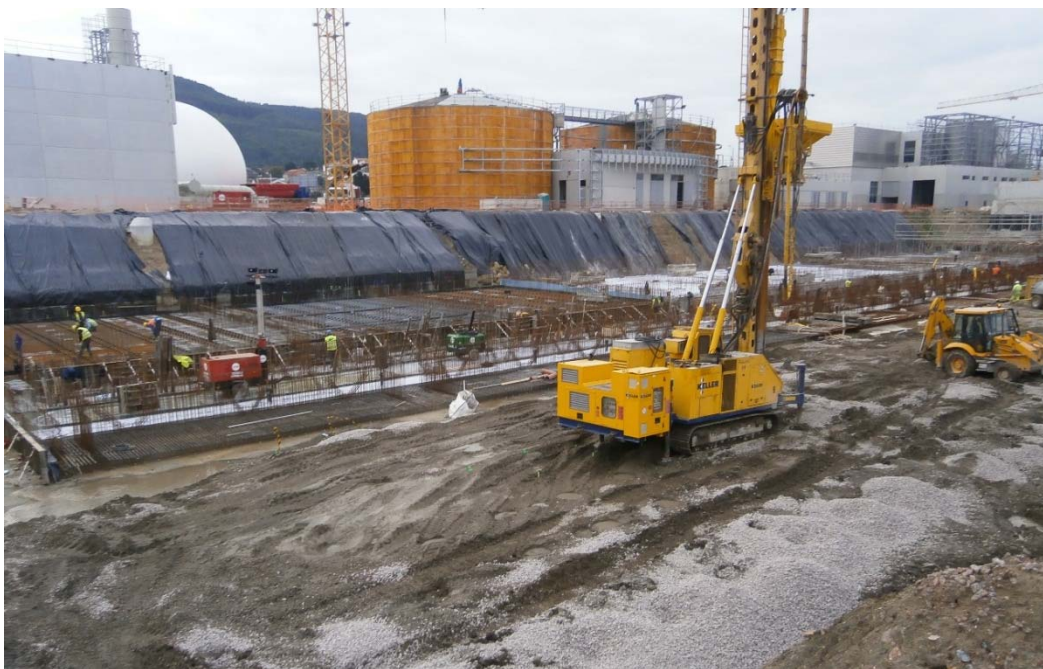
Figura 7. Plataforma de ejecución de columnas de grava
