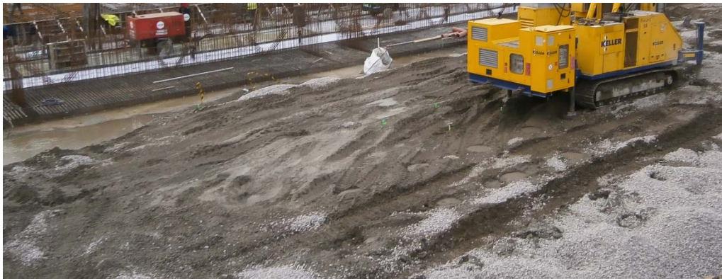
Figura 9. Plataforma de trabajo una vez ejecutadas las columnas de grava
