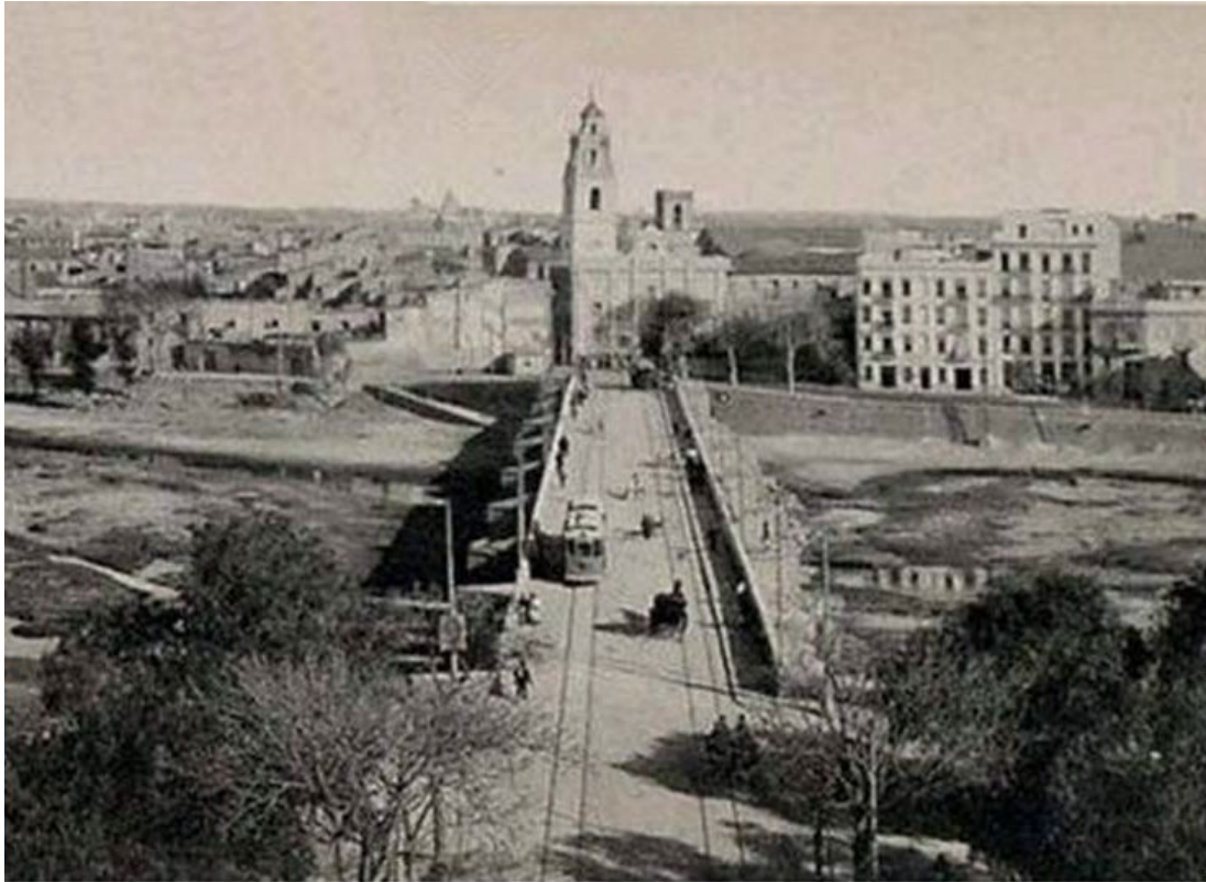
Figura 12. Puente de Serranos.
