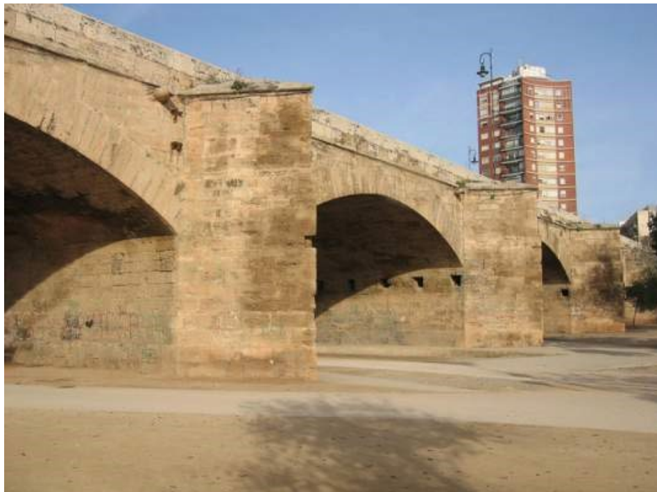
Figura 13. Puente de Serranos, antes de la recuperación de los arrimaderos.
