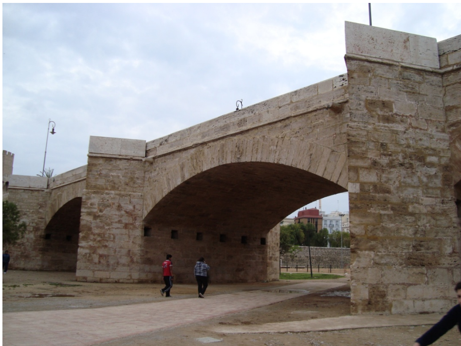
Figura 19. Puente de Serranos. Fotografía V. Yepes.
