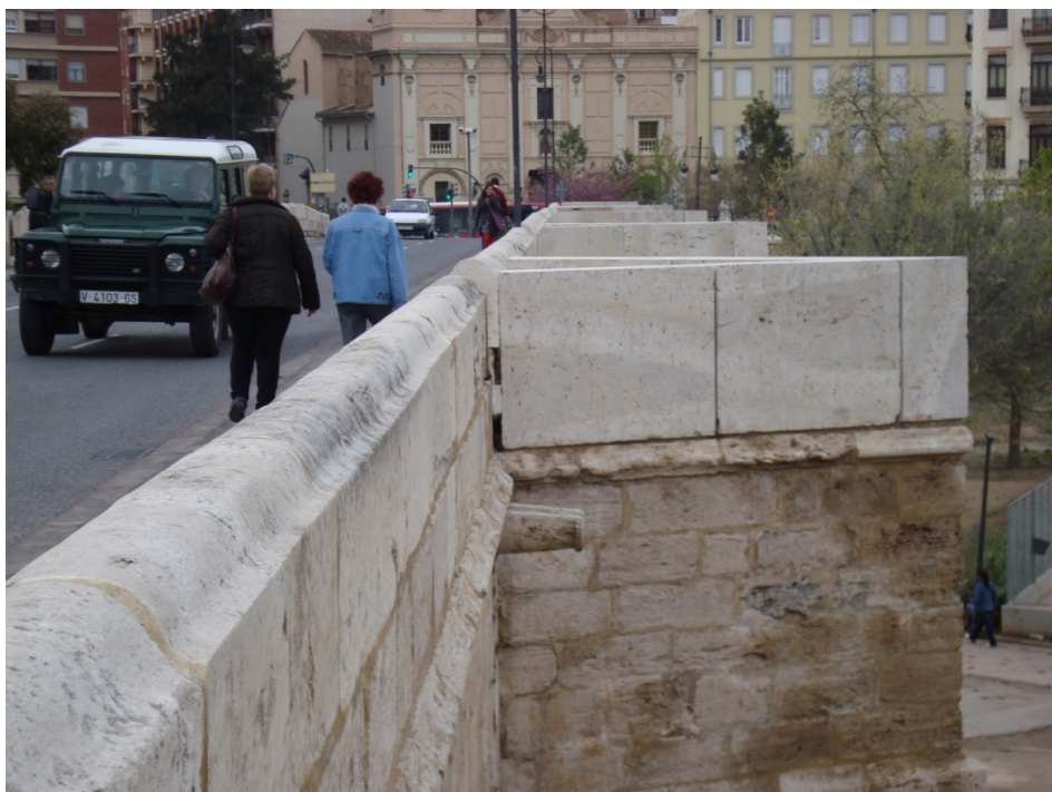
Figura 20. Puente de Serranos. Fotografía V. Yepes.
