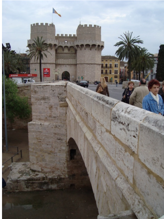
Figura 18. Puente de Serranos. Fotografía V. Yepes.
