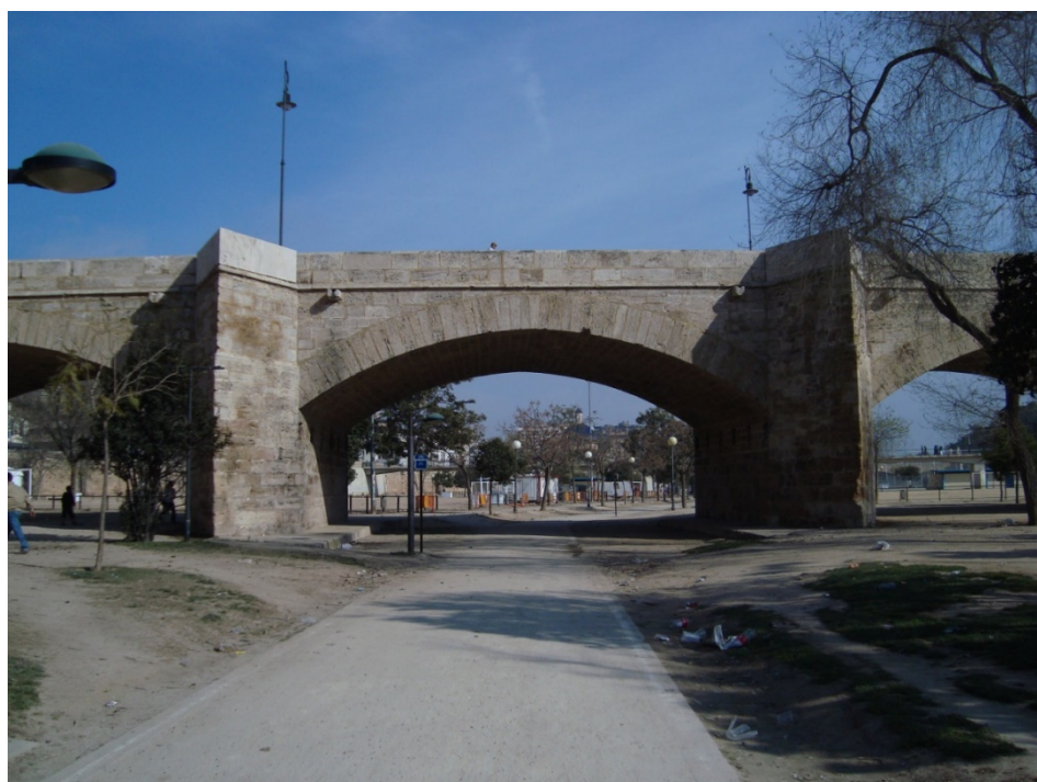
Figura 15. Puente de Serranos. Fotografía V. Yepes.
