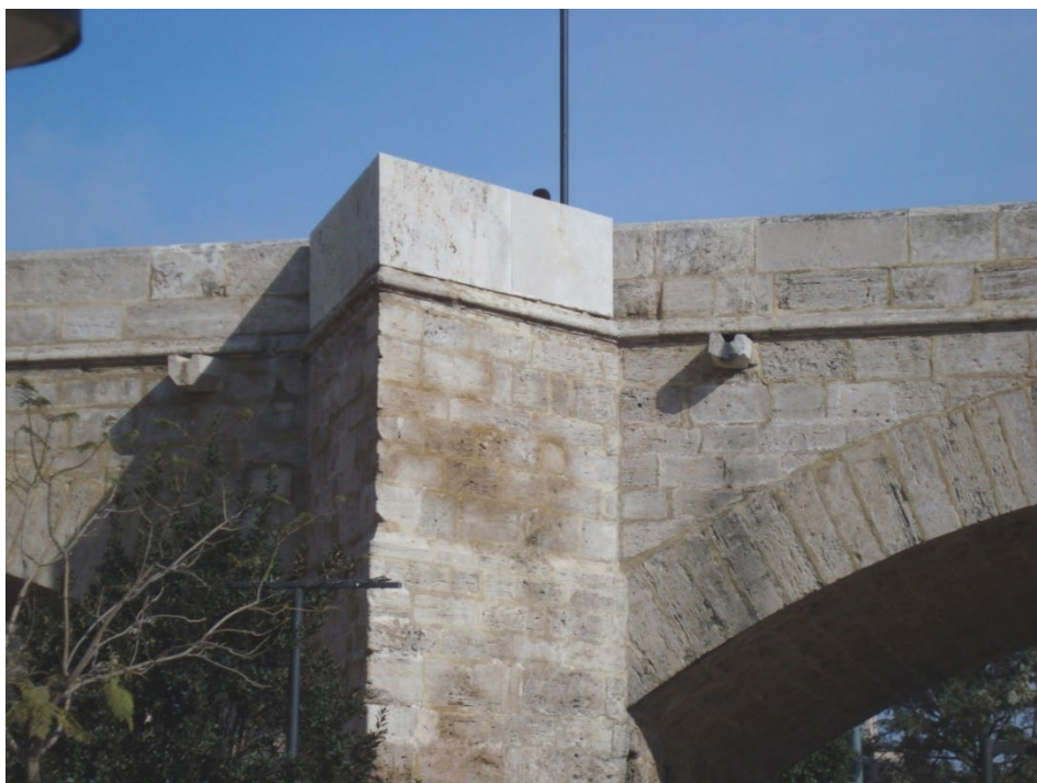
Figura 16. Puente de Serranos. Fotografía V. Yepes.
