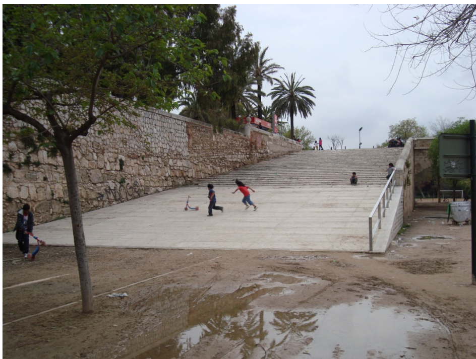
Figura 22. Rampa de acceso del Puente de Serranos. Fotografía V. Yepes.
