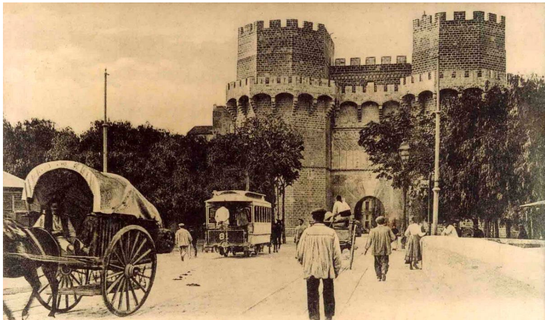
Figura 9. Puerta de Serranos, vista 1904.
