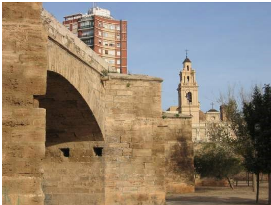
Figura 14. Puente de Serranos, antes de la recuperación de los arrimaderos.
