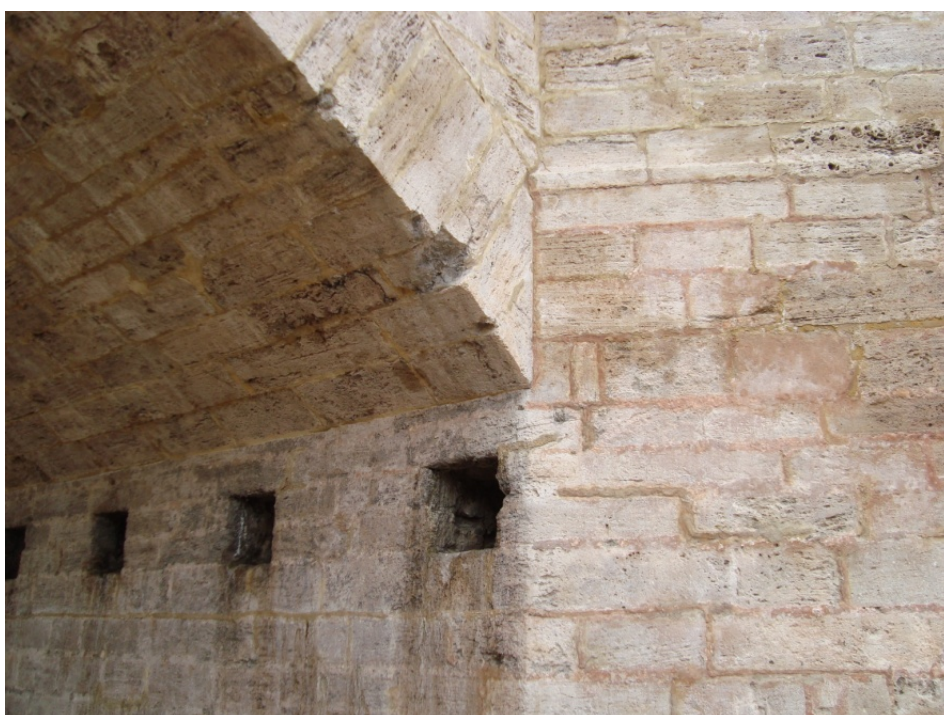
Figura 17. Puente de Serranos. Fotografía V. Yepes.
