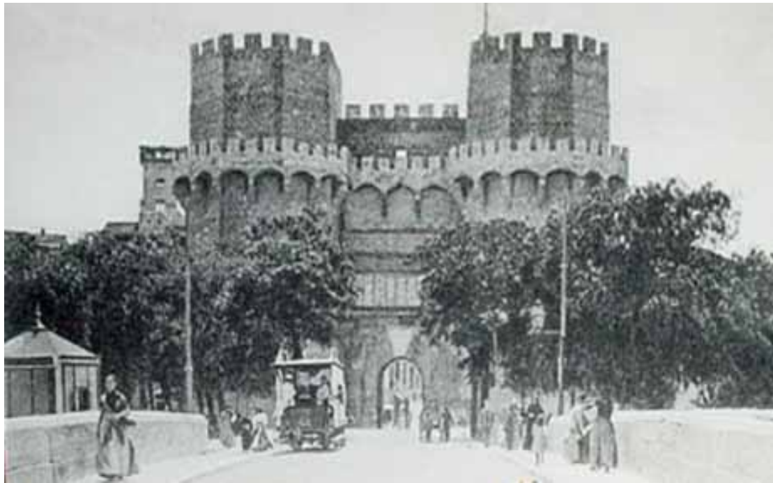
Figura 10. Puente de Serranos.
