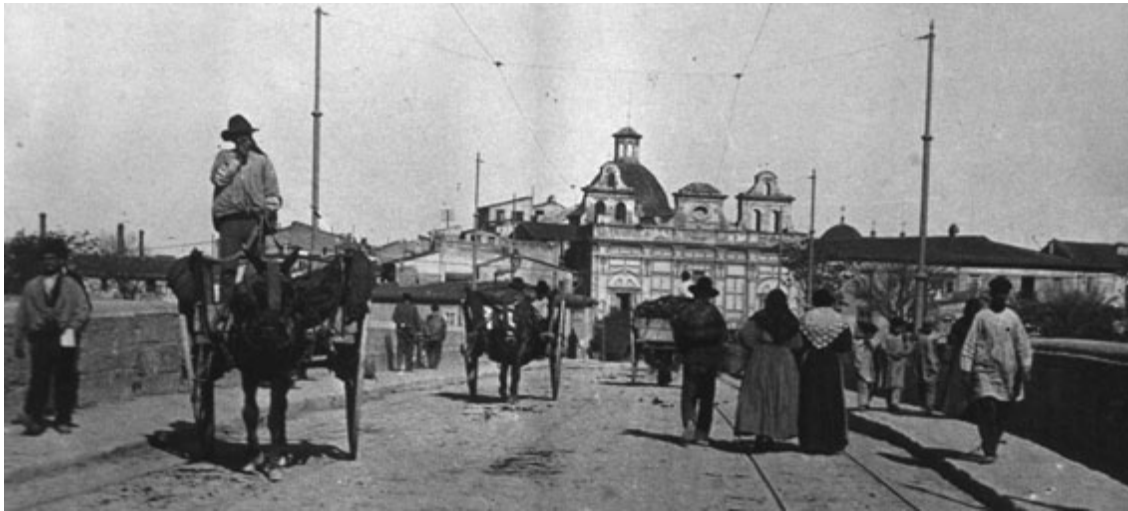
Figura 8. Puente de Serranos. Vista hacia la Iglesia de Santa Mónica.
