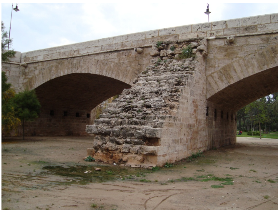
Figura 21. Puente de Serranos. Fotografía V. Yepes.
