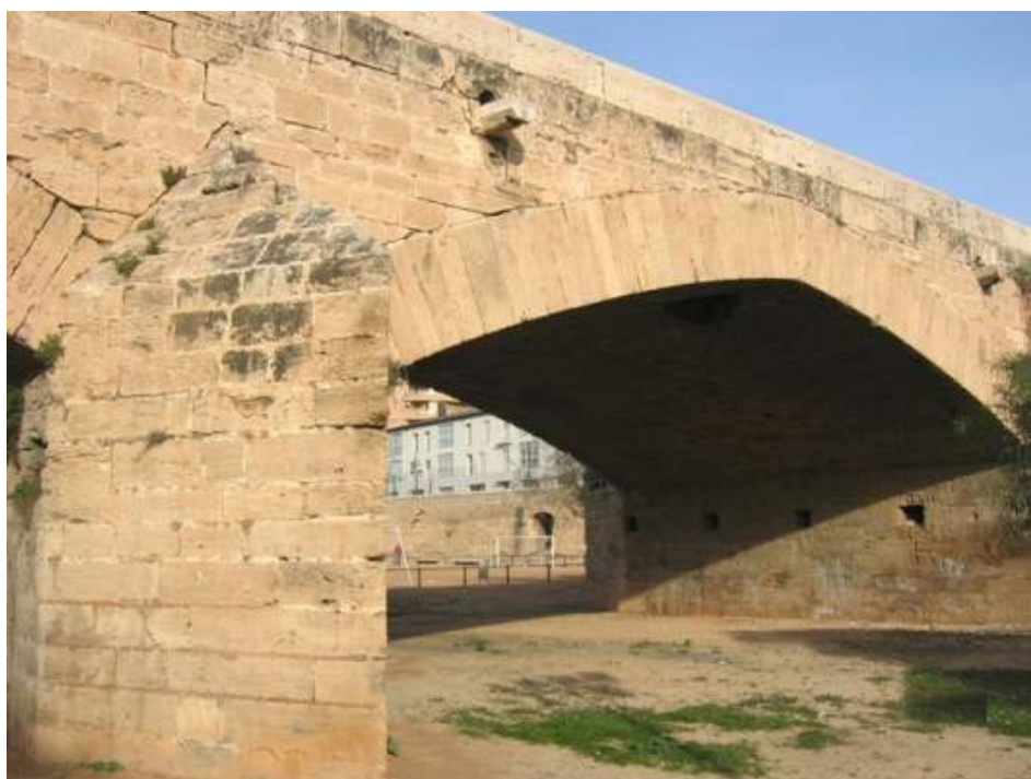
Figura 9. Puente de la Trinidad. Fotografía V. Yepes.
