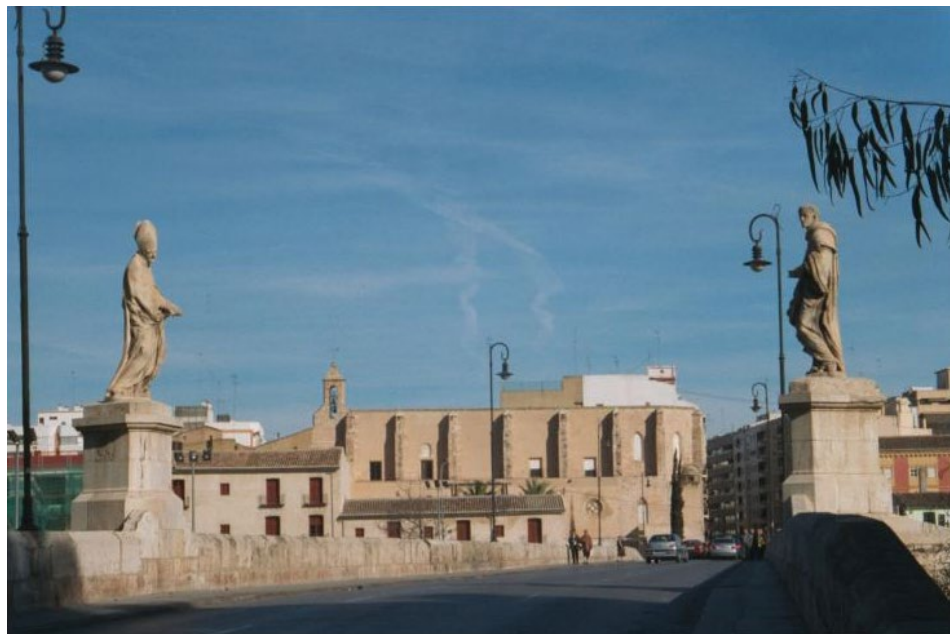
Figura 7. Puente de la Trinidad. Fotografía V. Yepes.
