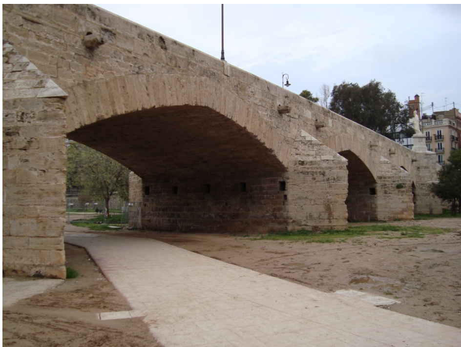
Figura 10. Puente de la Trinidad. Fotografía V. Yepes.
