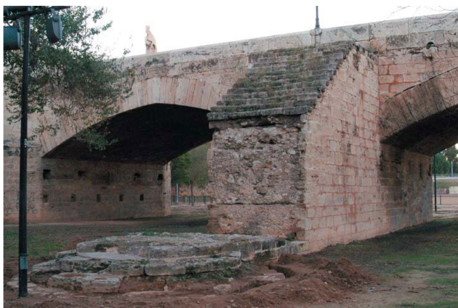
Figura 11. Puente de la Trinidad. Escaleras aguas abajo.
