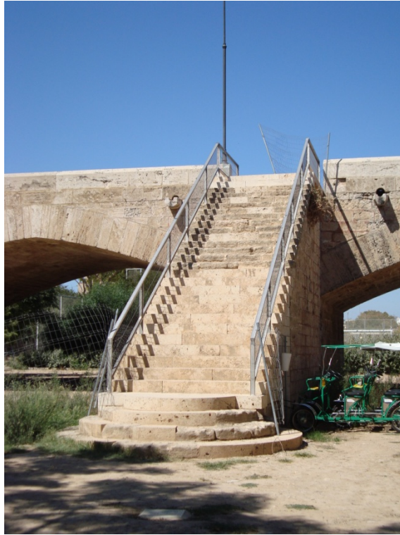
Figura 12. Puente de la Trinidad. Escaleras aguas abajo reparada. Fotografía V. Yepes.
