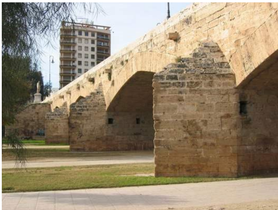
Figura 8. Puente de la Trinidad. Fotografía V. Yepes.
