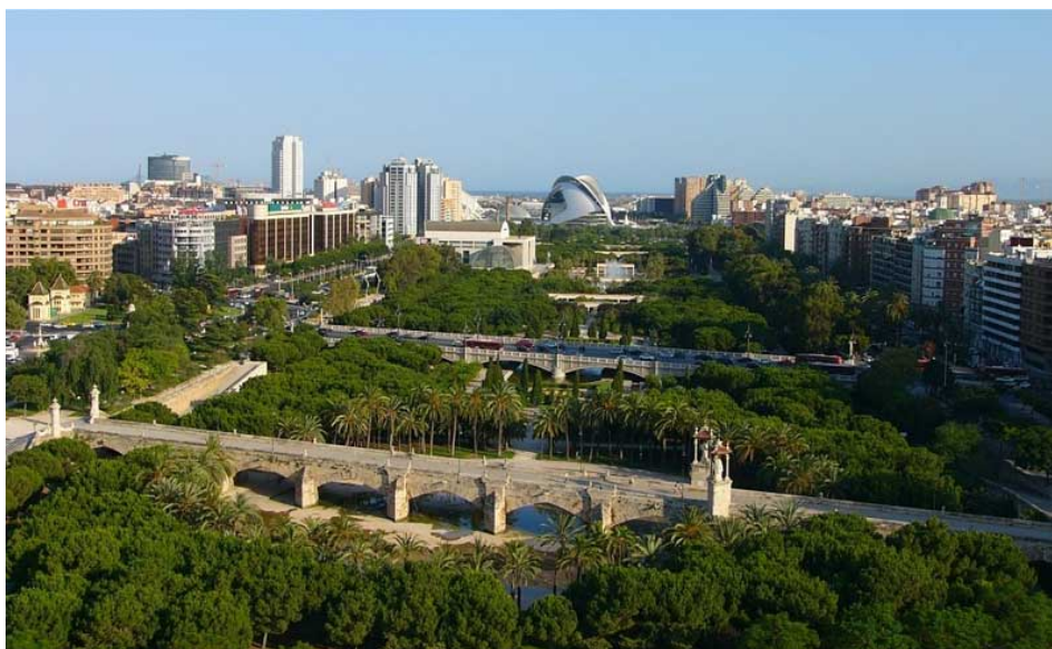
Figura 1. Vista aérea del Puente de la Trinidad. http://www.fdmvalencia.es/es/exercici-i-diversio-al-riu-turia/
