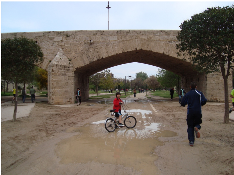
Figura 15. Puente de la Trinidad. Fotografía V. Yepes.
