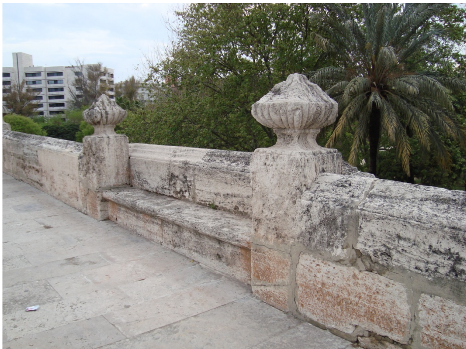
Figura 15. Detalle del pretil del Puente del Real. Fotografía V. Yepes (2010).
