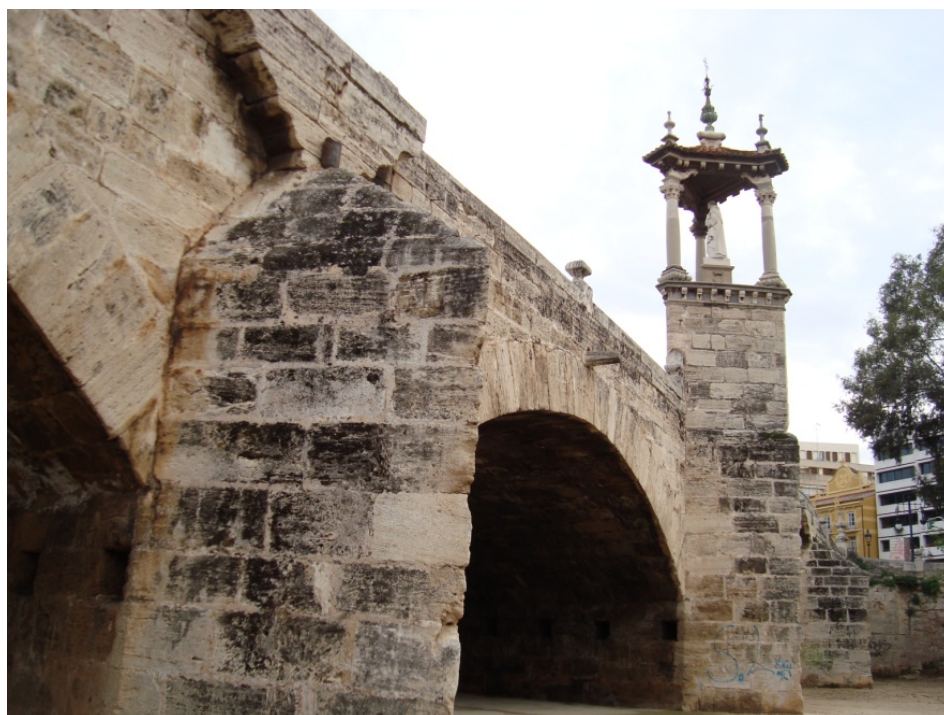
Figura 13. Puente del Real. Fotografía V.Yepes (2010).
