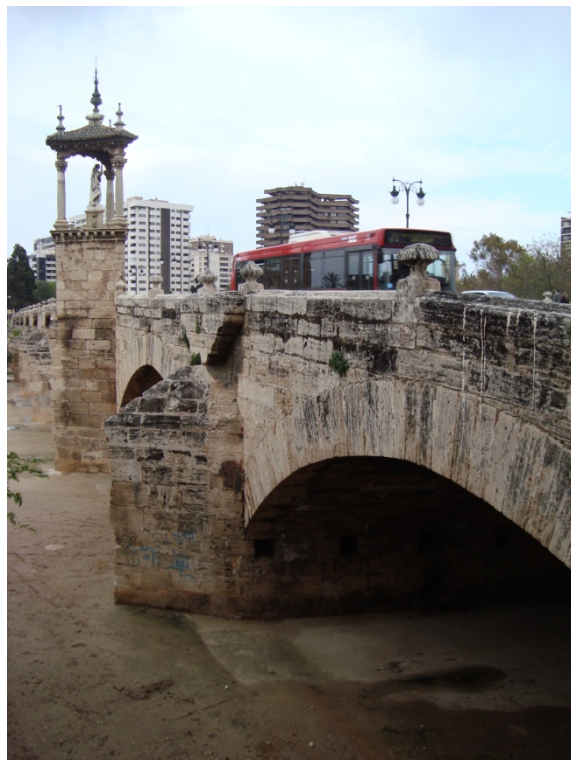
Figura 17. Puente del Real. Fotografía V. Yepes (2010).
