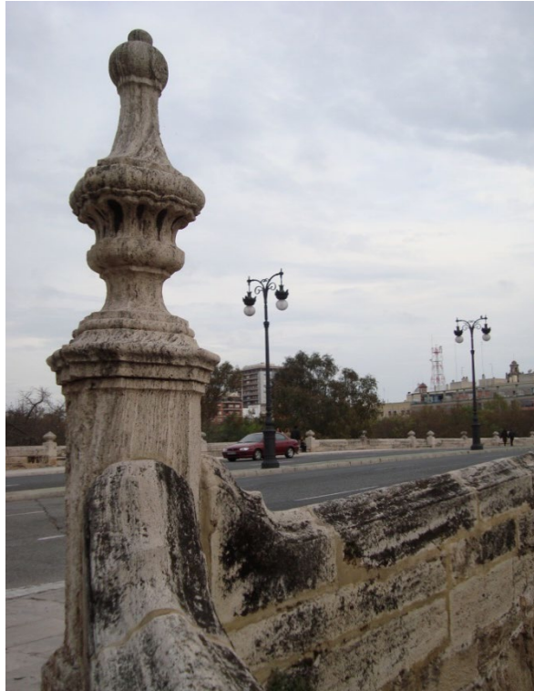
Figura 14. Puente del Real. Fotografía V. Yepes (2010).
