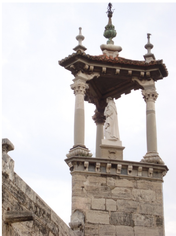
Figura 9. Casalicio de San Vicent Ferrer, en el Puente del Real. Fotografía V.Yepes (2010).
