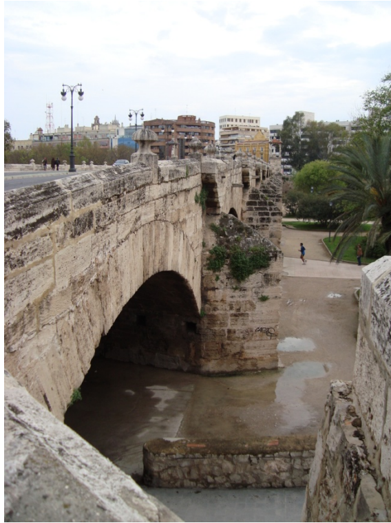
Figura 16. Puente del Real. Fotografía V. Yepes (2010).
