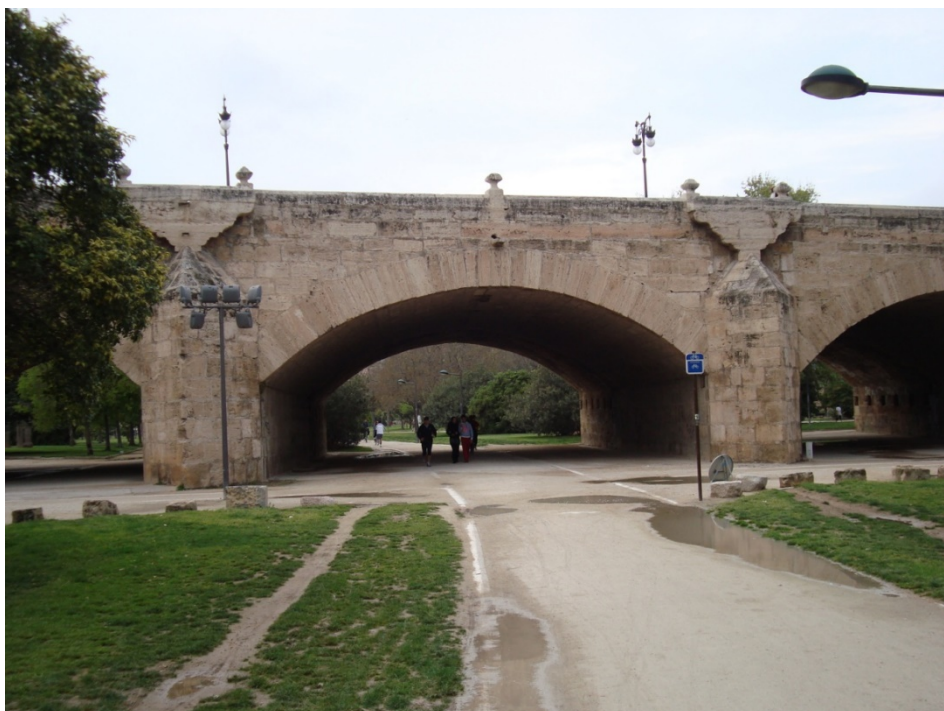
Figura 12. Puente del Real. Fotografía V. Yepes (2010).
