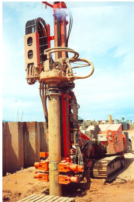
Figura 12. Maquina perforadora con sistema OD
