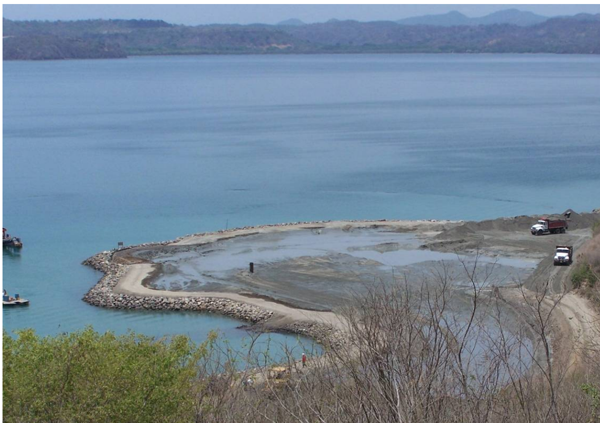
Figura 12. Etapa final de la construcción del relleno aproximándose ya al nivel requerido (tomada por el autor).
