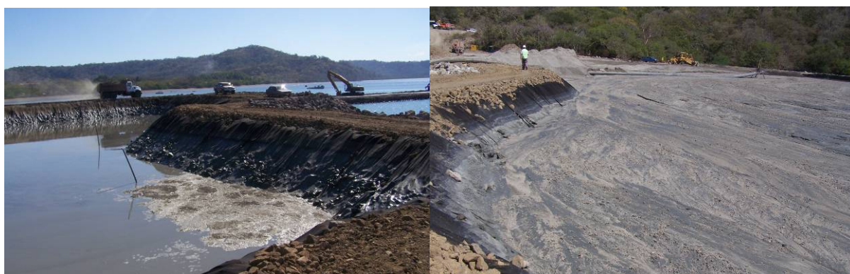
Figura 11. Proceso del depósito de material en distintas etapas de la obra (tomada por el autor).
