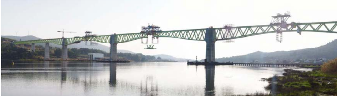
Figura 44. Izado de dovela de cierre del vano 7.
