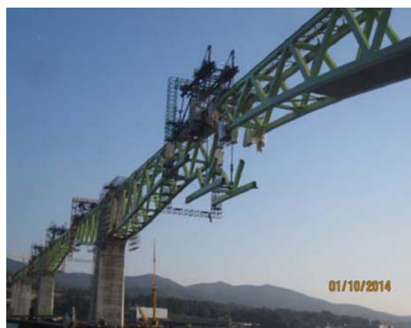
Figura 43. Izado de dovela de cierre del vano 8.
