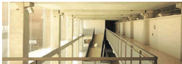
Figura 1: Edificio de oficinas realizado con forjados de placas alveolares y vigas Twin.
