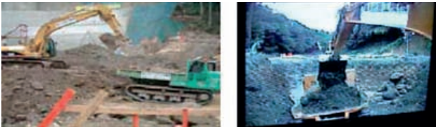
Figura 7. Excavadora teleoperada (izquierda) y visión remota del operario (derecha) en Japón [32].
