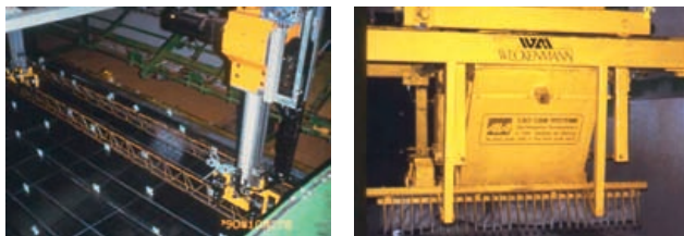
Figura 8: Colocación de las armaduras y vertido regulado del hormigón.
