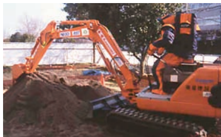
Figura 6: Robot humanoide conduciendo una pala excavadora.
