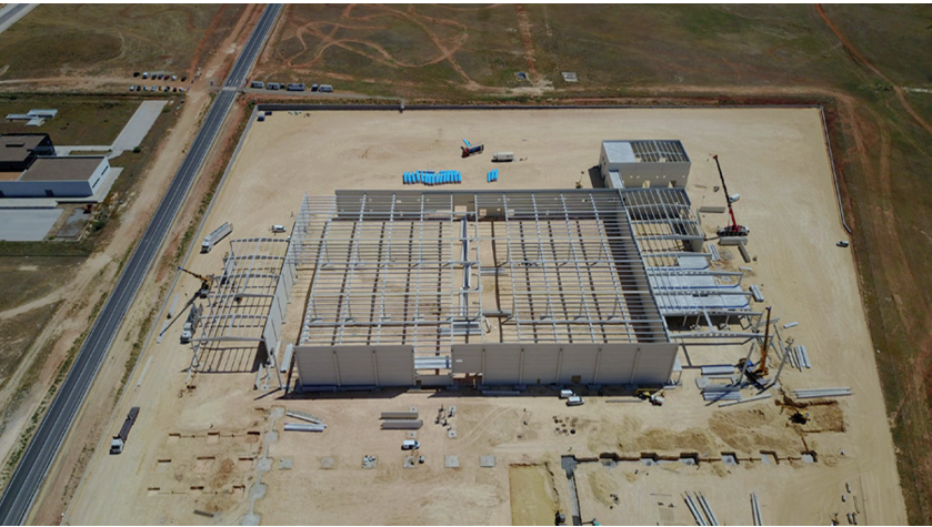
Figura 1.(a la izquierda). Vista aérea de la construcción de la nueva fábrica del GRUPO YBARRA en Dos Hermanas (Sevilla). Estructura y cerramientos íntegramente realizados mediante elementos prefabricados de hormigón, una de las aplicaciones más consolidadas por su grado máximo de industrialización y sus ventajas asociadas (velocidad de ejecución, control, seguridad, nulos residuos, etc.) Foto cortesía de PRETERSA PRENAVISA.
