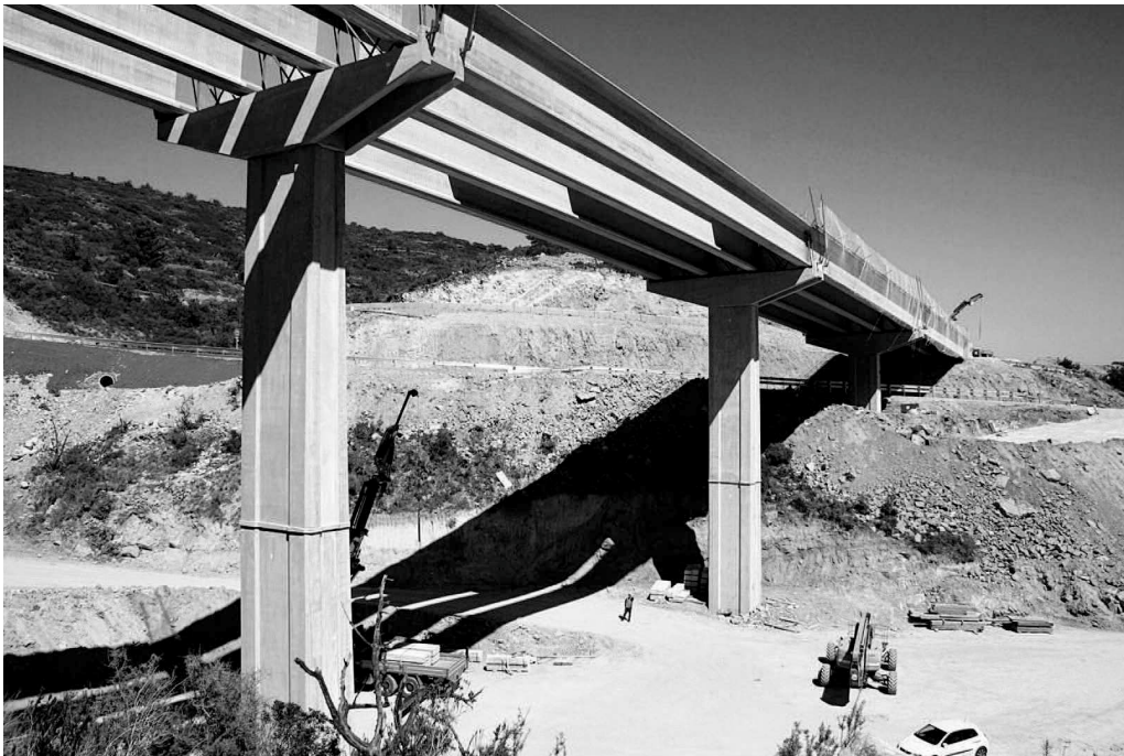
◀ Puente prácticamente en prefabricado de concreto: pilas, cabeceros, vigas tablero y prelasas.
