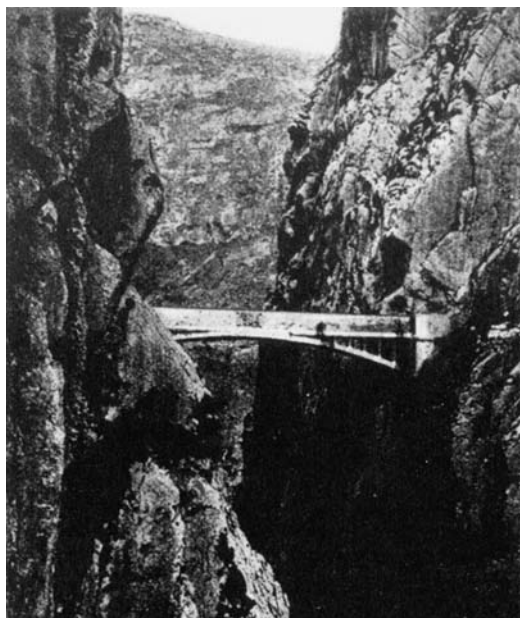
Figura 12 Acueducto del Chorro, Málaga (Ribera 1932, 266)
