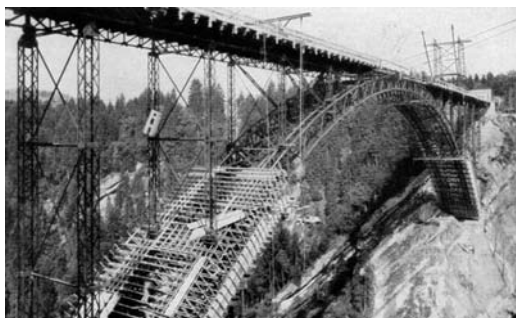
Figura 9 Puente de Echelsbach, la estructura de acero con una parte del encofrado. (Duell y Gerhart 1929, 57)
