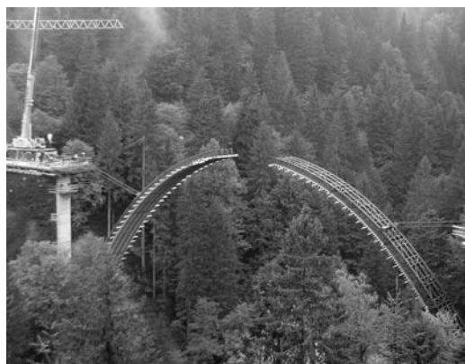
Figura 1 Puente sobre el Lesach, antes de cerrar el arco (Peter Schallaschek)
