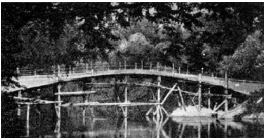
Figura 5 Puente en Stockbridge, Mass. 1894, con andamio ligero (Spitzer y Nowak 1908, 73)
