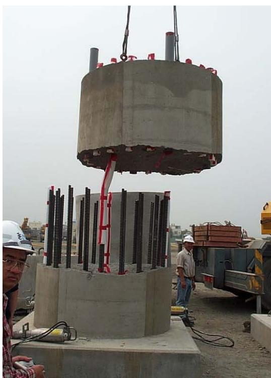
La utilización de los quebrantadores Darda no produce ondas de choque, vibraciones, polvo o ruido. La disposición de una línea de quebrantación mediante la colocación de los cilindros en línea permite un control total y permite trabajar con una precisión que no es posible con métodos convencionales.
