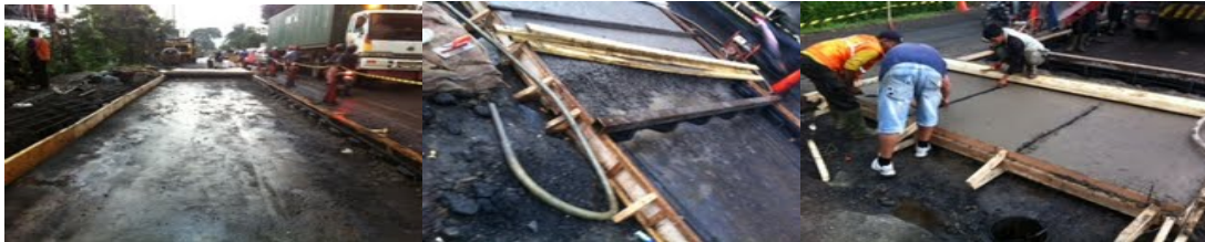
Fig.- 21 Terreno volcánico de escasa capacidad de soporte, regla de sujeción de junta transversal y colocación de juntas longitudinales (goma superior solamente)
