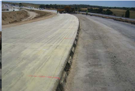
Fig.-15 Ejecución de la 2ª fase del pavimento
