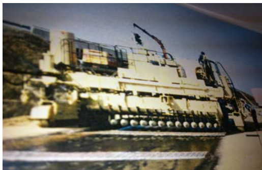
Fig. 1.- Pavimentadora con torpedos de aligeramiento y junta
