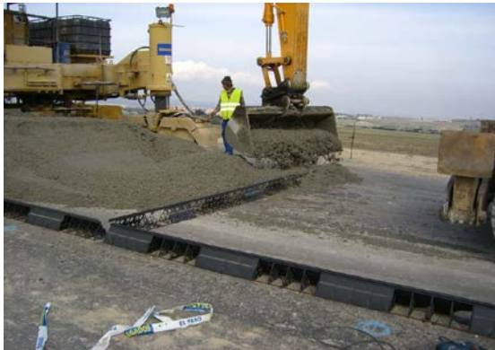
Fig.-14 Ejecución con JRI+3 transversal y longitudinal
