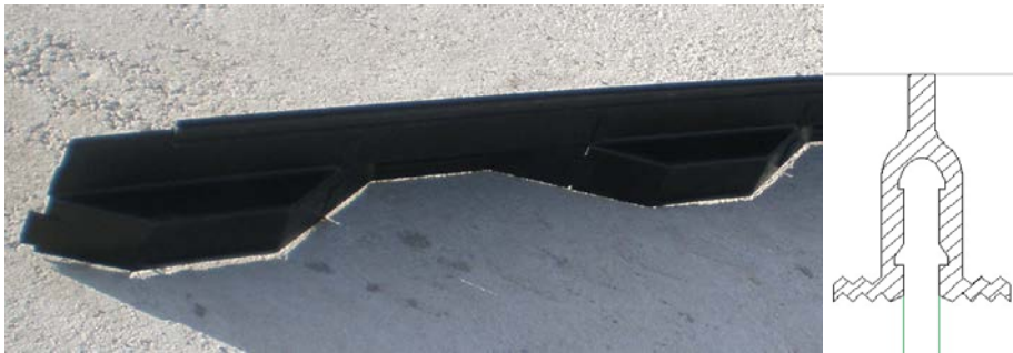
Fig.- 17 Bandejas montadas alternadamente y goma superior impermeable con detalle de esta
