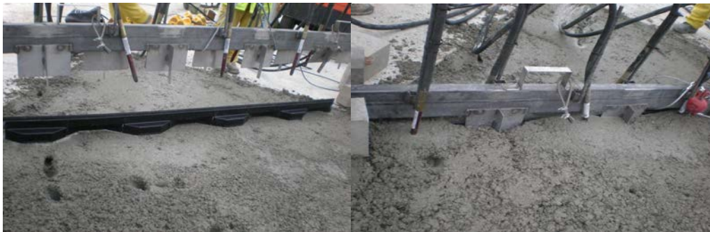
Fig.- 18 Junta JRI+4 y regla con vibradores y empujadores para su inserción en el hormigón fresco
