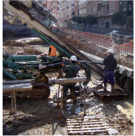
Perforación de anclajes.
