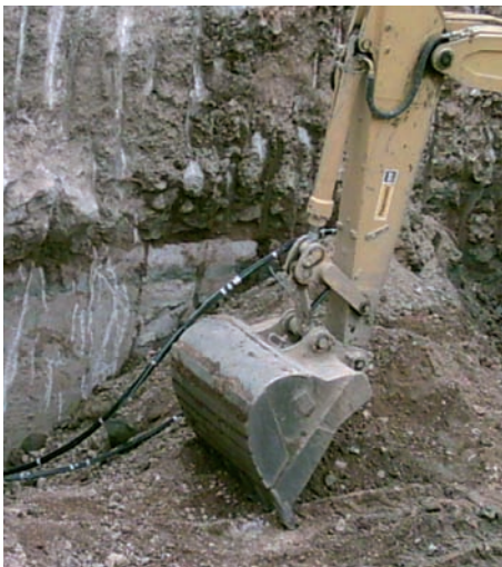
Preparación de la plataforma.
