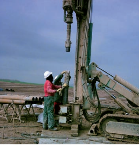
Introducción de la armadura.
