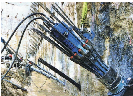
Gato de tesado multifilar.
