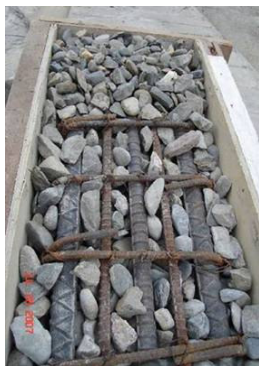
a) Colocación del agregado grueso
