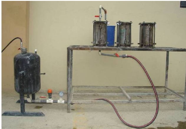
a) equipo utilizado para la inyección del grout
