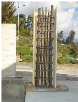
a) Armado de una columna b) Puntos de inyección del grout para la inyección en la columna
