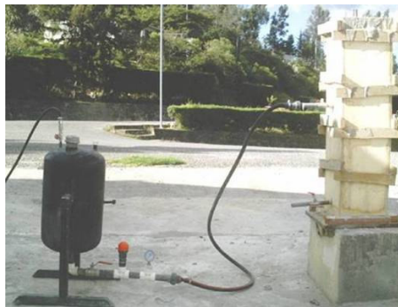
a) Armado de una columna b) Puntos de inyección del grout para la inyección en la columna
