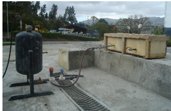
b) Colocaron de los puntos de inyección en la viga
