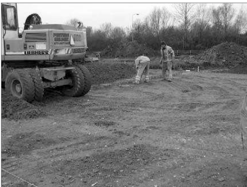
Foto 3. Colocación de los pasadores en el lugar predefinido de una junta transversal de retracción.
