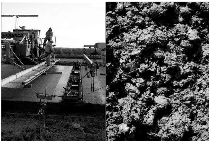
Foto 2. Detalle del pavimento de Roermond durante la construcción.
