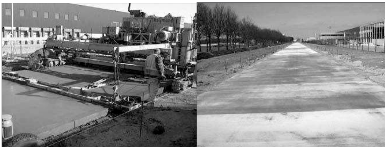
Foto 1. El pavimento de Tilburg durante (izquierda) y tras (derecha) la construcción.
