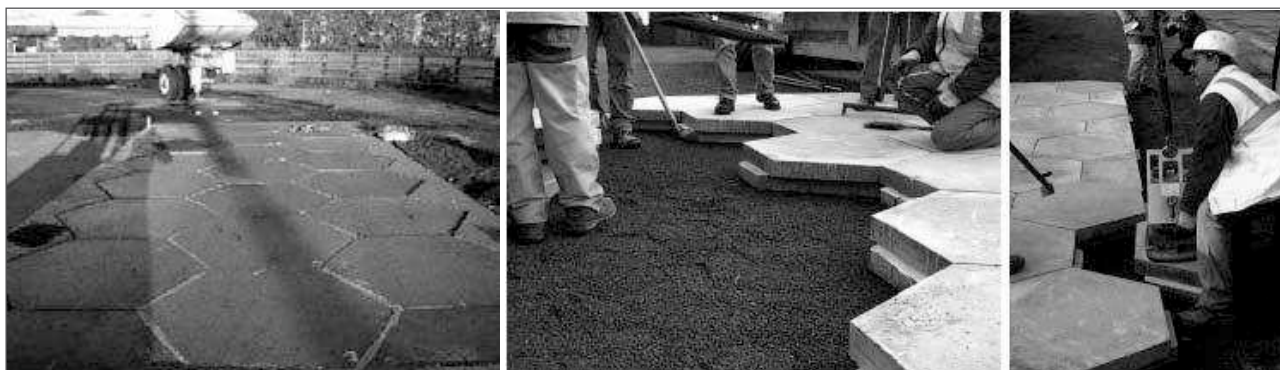
Foto 8. Instalación de losas hexagonales machihembradas en Francia.
