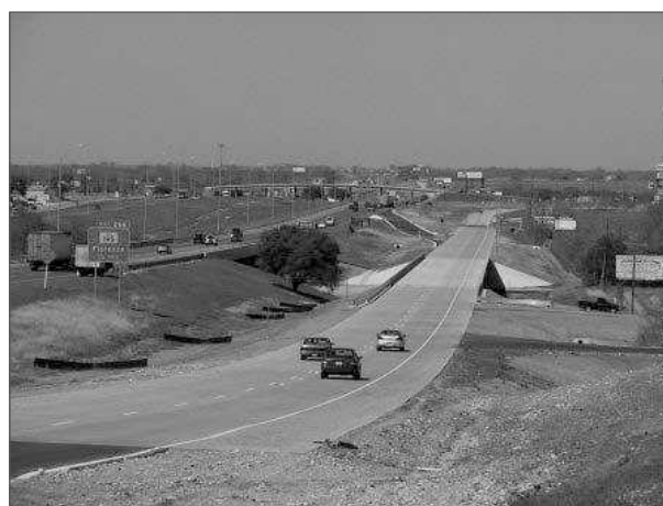
Foto 1. Proyecto ejecutado en la I-35 en Georgetown, Texas.
