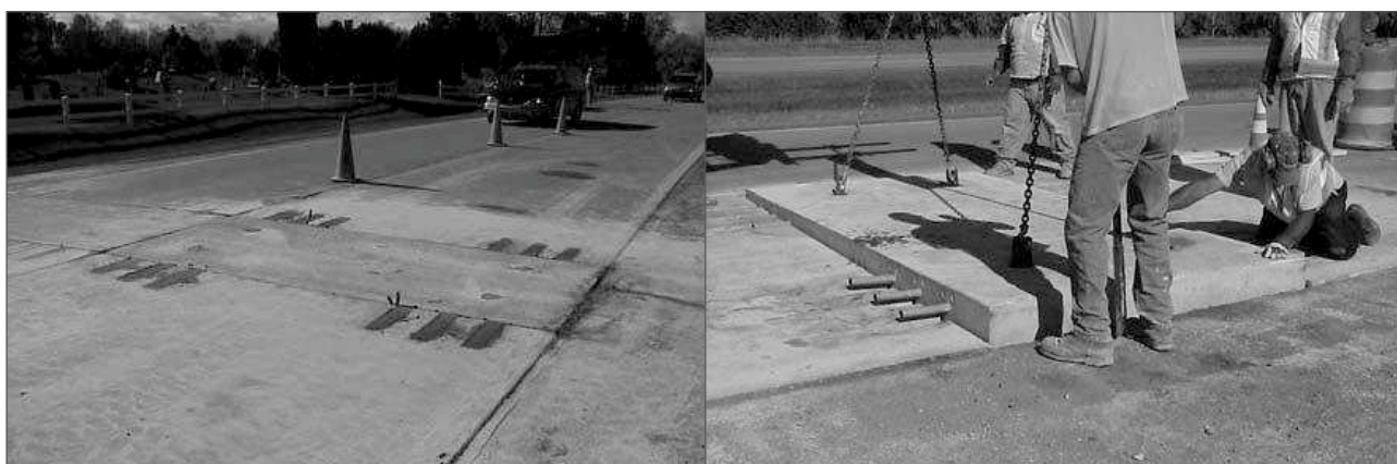
Foto 7. Sistema de reparación en todo profundidades y espesor (M-25, MI).
