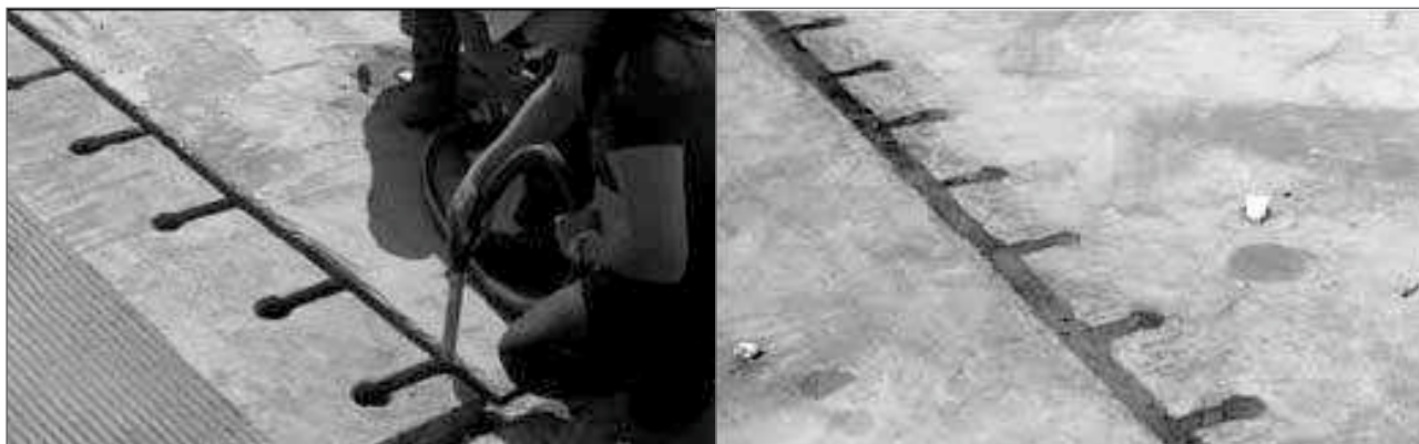
Foto 4. El sistema Kwik Slab.
