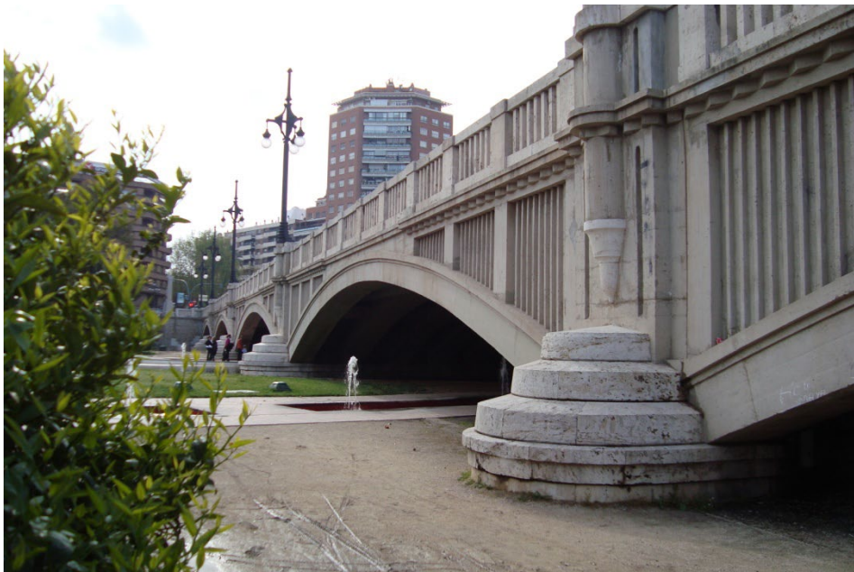
Figura 4. Puente de Aragón. Fotografía V. Yepes.
