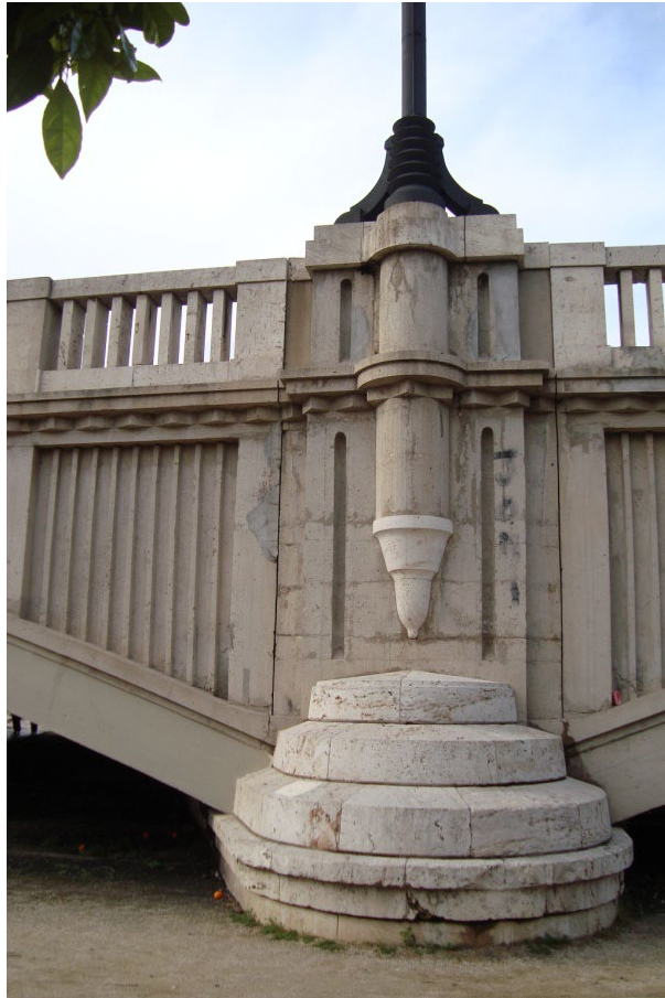
Figura 7. Detalle del tajamar del puente de Aragón. Fotografía de V. Yepes.
