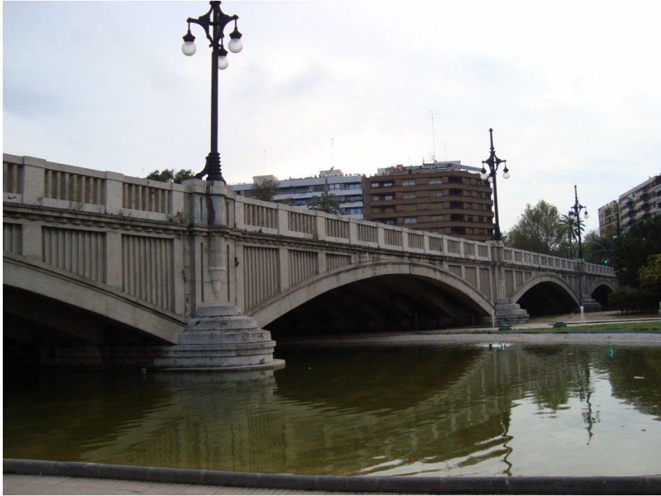
Figura 5. Puente de Aragón. Fotografía V. Yepes.
