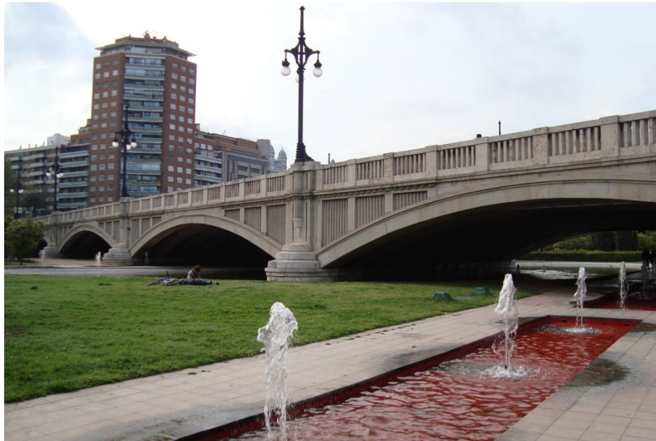
Figura 1. Puente de Aragón. Fotografía V. Yepes.
