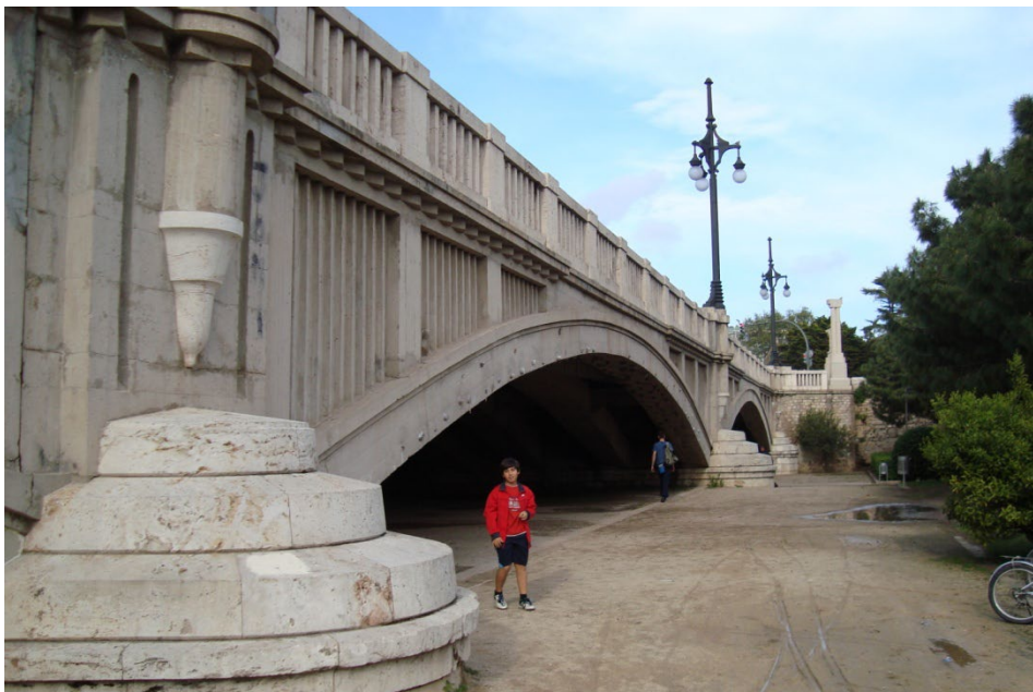
Figura 6. Puente de Aragón. Fotografía de V. Yepes.
