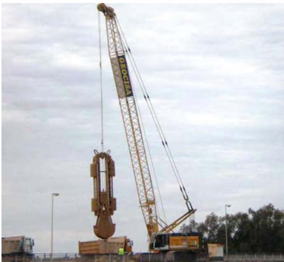
Equipo de excavación en funcionamiento.
