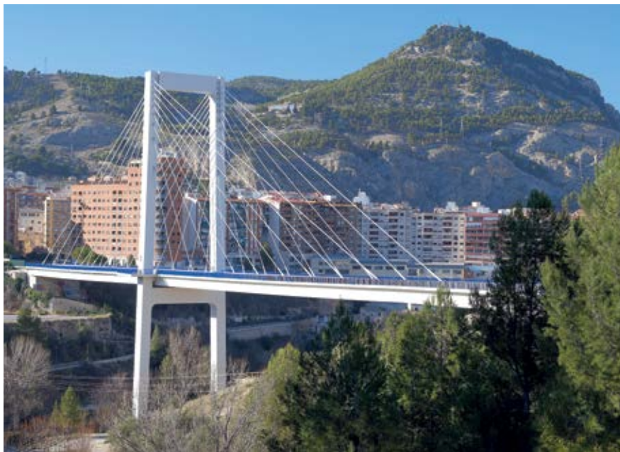
Figura 10. Puente Fernando Reig de Alcoy, tras su remodelación. (VÍCTOR YEPES)
