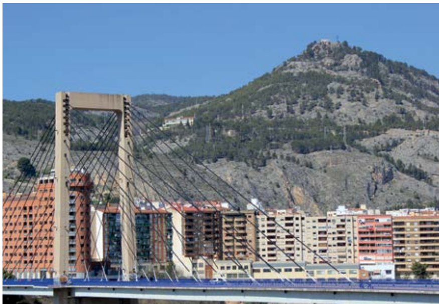
Figura 9. Puente Fernando Reig de Alcoy, antes de la remodelación. (RAFAMIRALLES)
