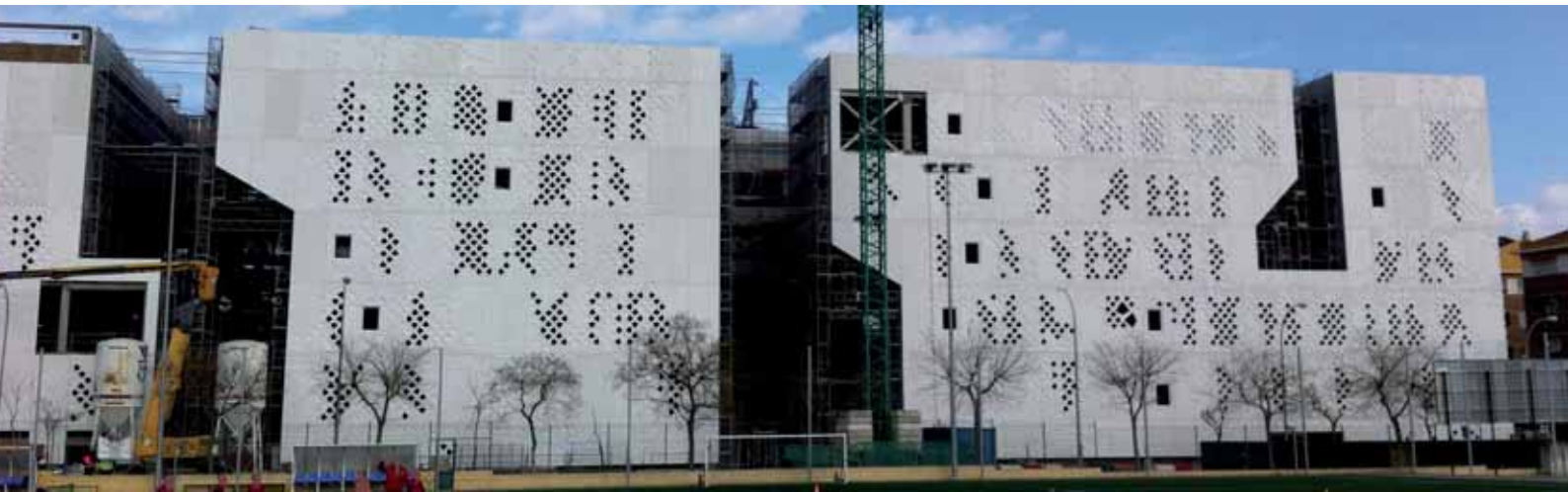
El diseño de fachada principal se construye con una doble capa: una interior de cartón yeso y otra exterior de GRC (hormigón armado con fibra de vidrio). El GRC se presenta como uno de los materiales de construcción pujantes en la construcción de fachadas y con una baja carga ambiental. Ciudad de la Justicia Córdoba. Cortesía de PREHORQUISA.
