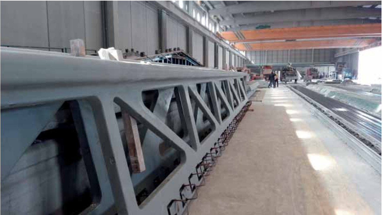
Cercha para cierre lateral de pasarela. Resistencia del hormigón de 160 MPa. Revela los avances tecnológicos experimentados por la industria del prefabricado. Cortesía de LUFORT.
