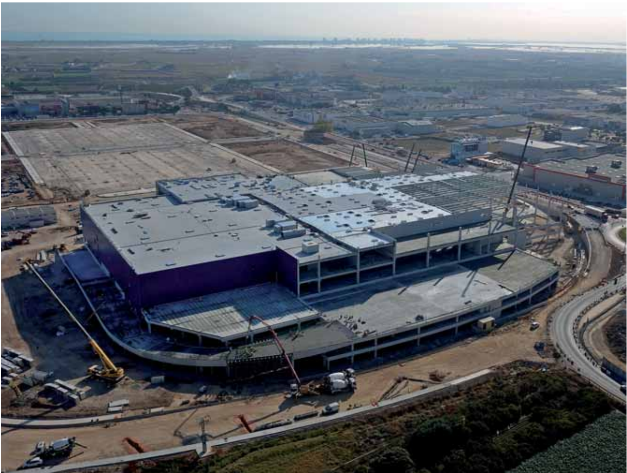
Complejo IKEA en Alfara (Valencia). Los centros logísticos y comerciales se han convertido en edificaciones cuya construcción es fundamentalmente industrializada en hormigón, al tiempo que priorizan el cumplimiento de criterios sostenibles. Cortesía de PRECON.
