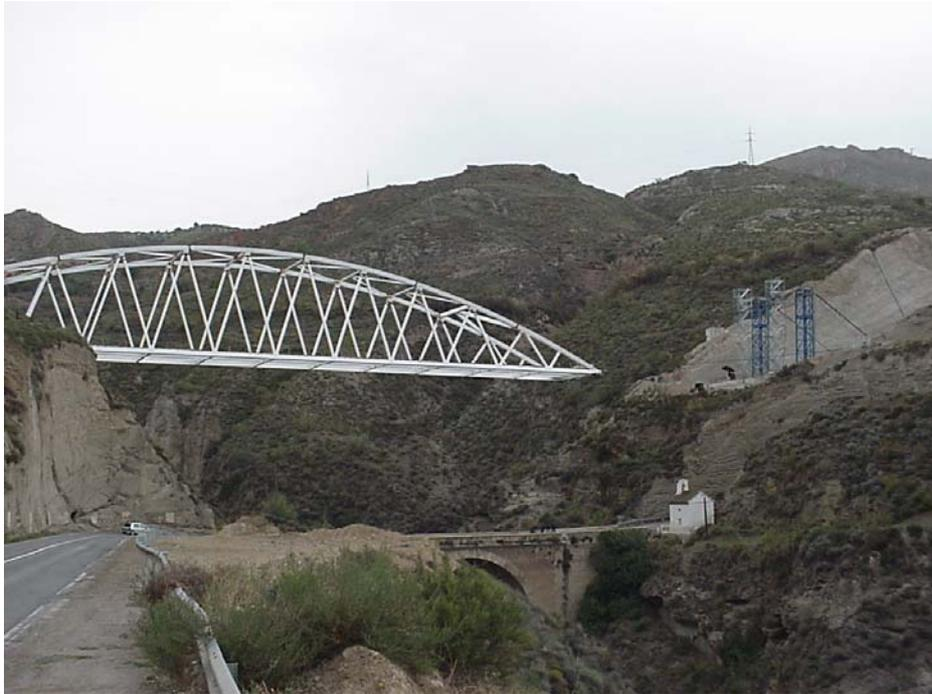
*Figura 8. Lanzamiento. Vista lateral*
