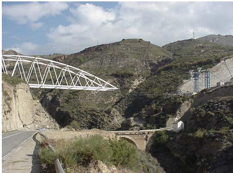
*Figura 4. Empuje de la primera mitad del puente*
