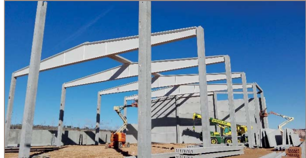
■ Figura 3. Estructura íntegramente prefabricada de hormigón para nave industrial. Ejemplo de construcción industrializada donde la generación de residuos de construcción es prácticamente inexistente.
