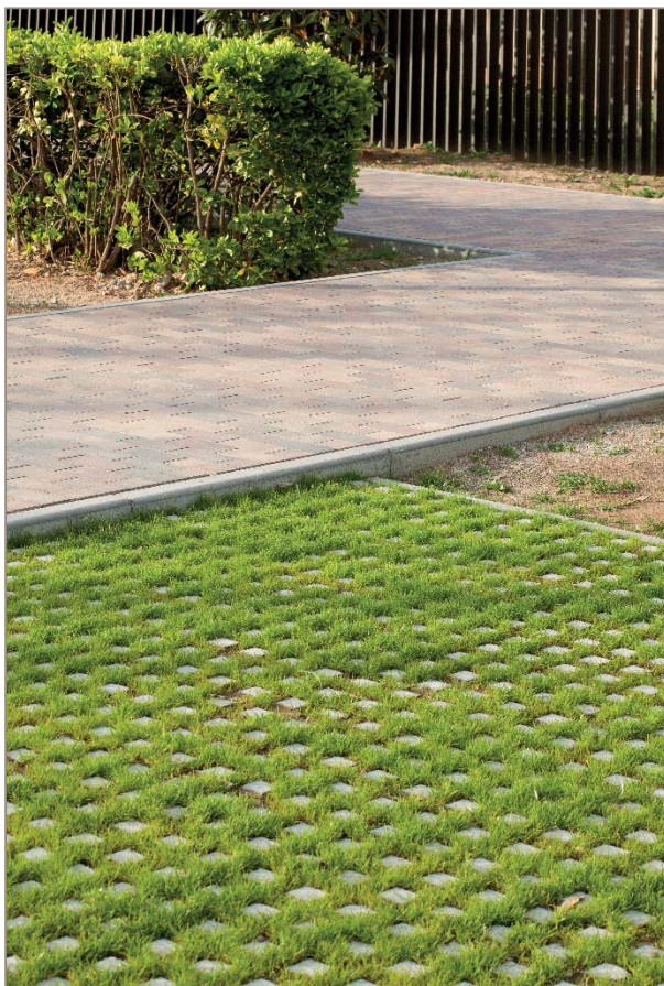
■ Figura 4. Pavimento drenante mediante el modelo losa IIIa. (Foto: cortesía de BREINCO).
