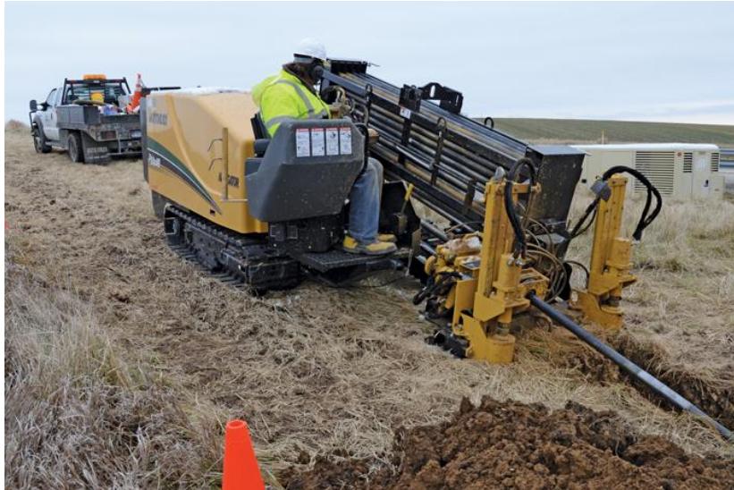
Figura 10. Sistema de carga de tramos de tubería. Imagen de Zemin Arastrima Merkezi, Corp.
