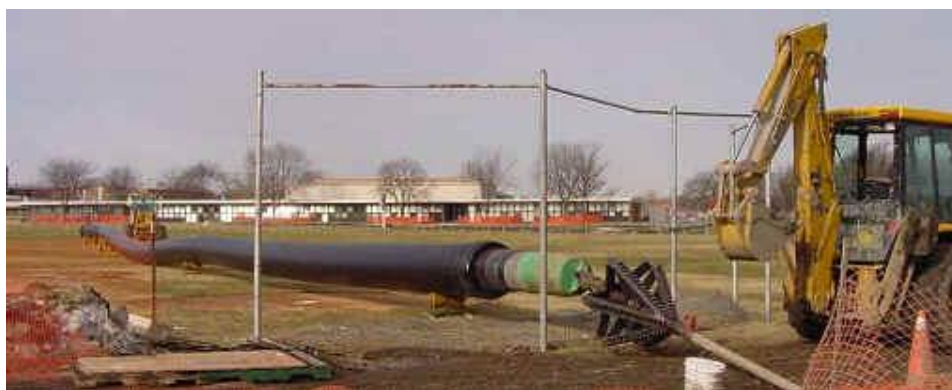
Figura 9. Conexión del escariador a la tubería. Imagen de Apollo Trenchless, Inc.
