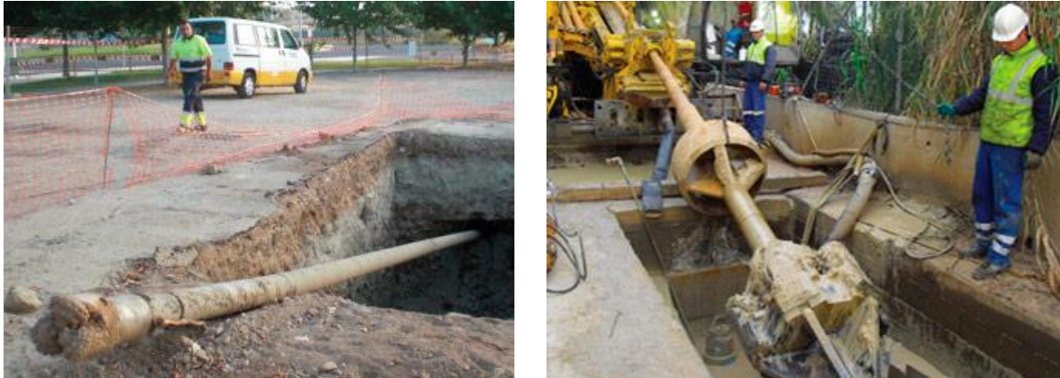
Figura 3. Cabeza de perforación y escariador. Imágenes de Catalana de Perforacions
