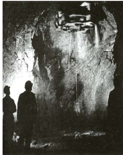
Fig. 3. Inicio de la excavación de una chimenea.
