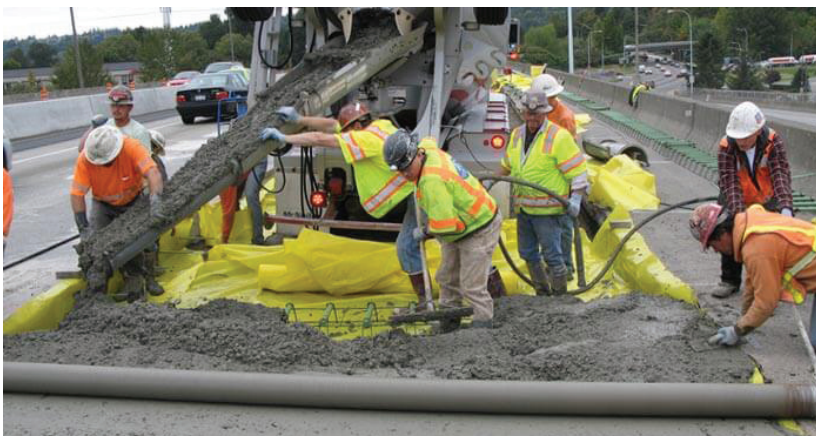
Figura 2. Homogeneidad del hormigón
