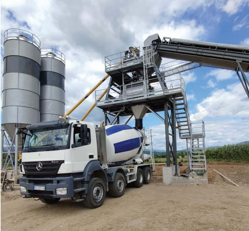
Figura 1. Camión hormigonera en una central
