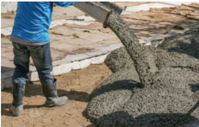
Figura 3. Colocación del hormigón
