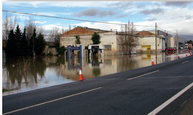
Figura 8. Arriba: edificación construida invadiendo el encauzamiento, Alginet (Valencia). Fuente: Inclam. Abajo: drenaje insuficiente en la carretera NA-115, Peralta (Navarra). Fuente: Gobierno de Navarra.
