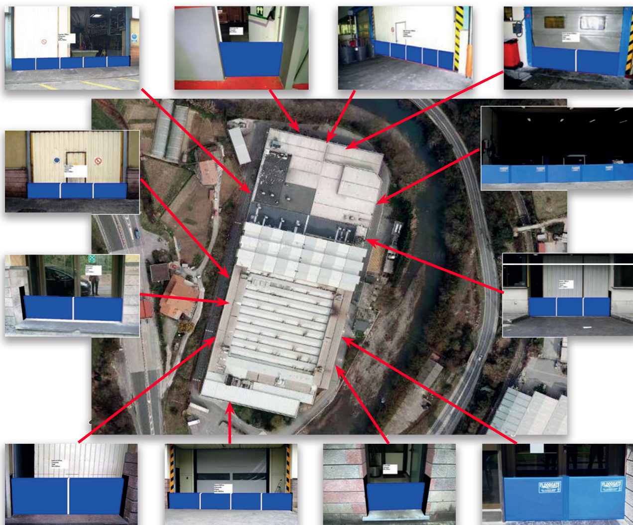
Figura 50. Industria protegida con compuertas anti-inundación, Elgóibar (Gipuzkoa). Fuente: CAG Canalizaciones.
