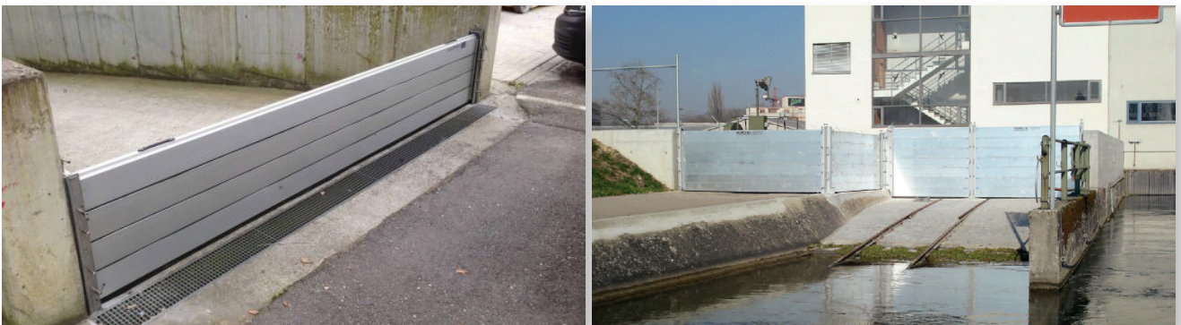
Figura 40. Puertas de cierre estancas modulares que ofrecen solución de continuidad al muro de cierre, montadas dentro de dos perfiles en U ancladas en una pared. Es posible instalar postes intermedios en áreas más grandes. Fuente: izq.: Aggères. Dcha.: Ryst.
