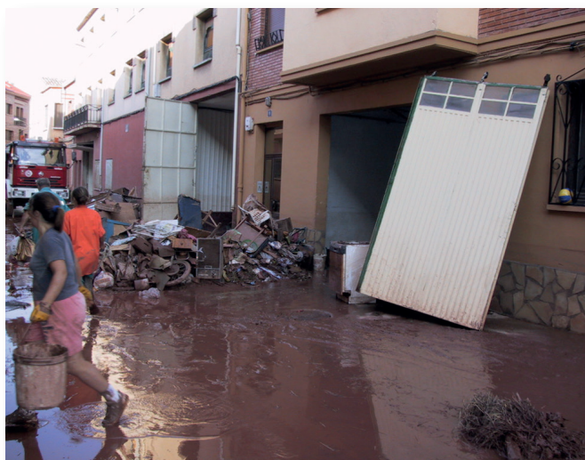
Figura 11. Daños en edificaciones debidas a las inundaciones en Huércanos (La Rioja). Fuente: SOS Rioja.
