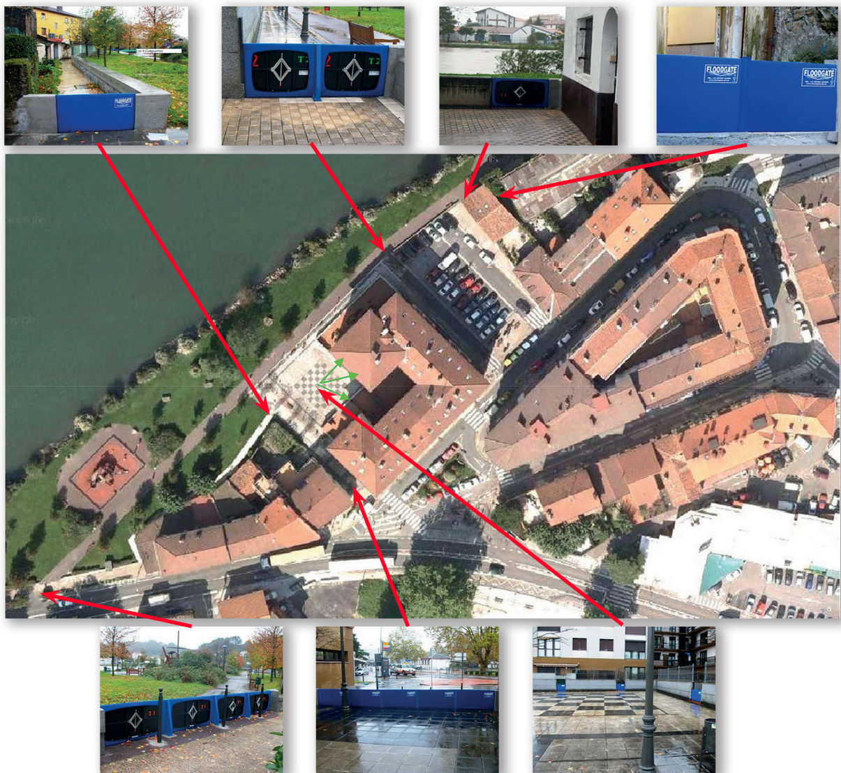
Figura 44. Urbanización protegida con barreras anti-inundación, Behobia (Gipuzkoa). Fuente: CAG Canalizaciones.
