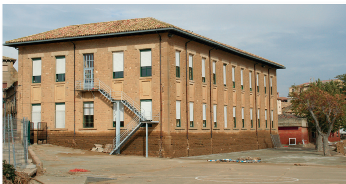
Figura 54. Sádaba (Zaragoza), un día después de la inundación de octubre de 2012. Salida de emergencia a escalera. Fuente: CHE.
