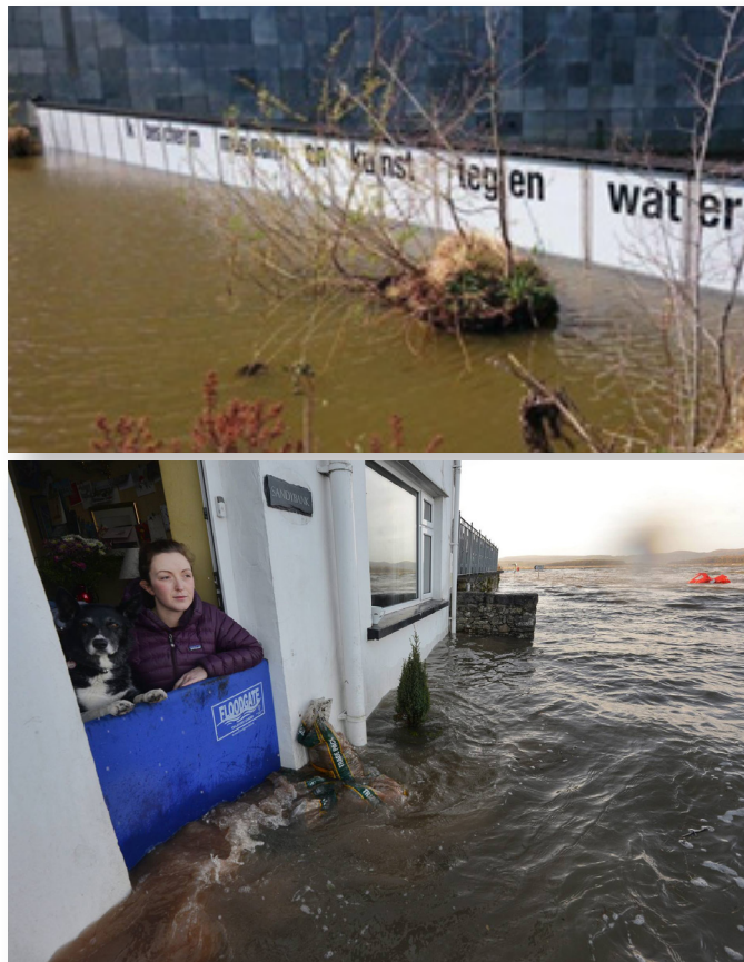
Figura 2. Arriba: barreras anti-inundaciones instaladas en el Museo Van Abbe de Eindhoven (Países Bajos). Fuente: Aggères. Abajo: compuertas FloodGate, Fuente: FloodGate.
