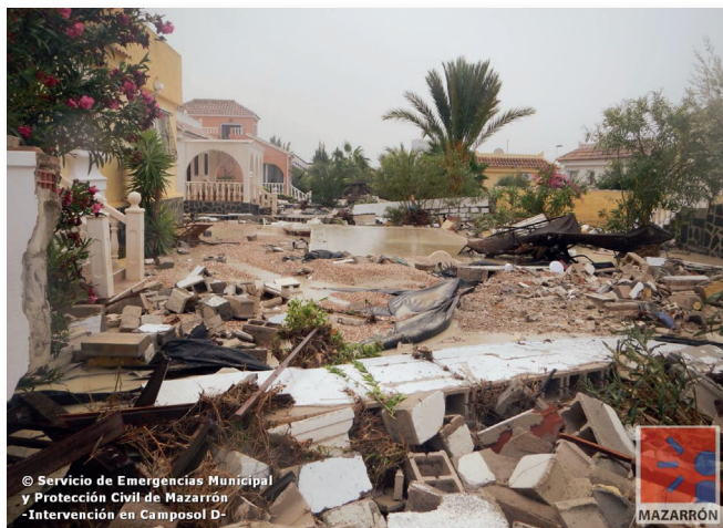
Figura 34. Efecto combinado de empuje y erosión. Muro derruido en Mazarrón (Murcia), inundaciones de 2014. Fuente: Servicio de Emergencias Municipal y Protección Civil de Mazarrón.
