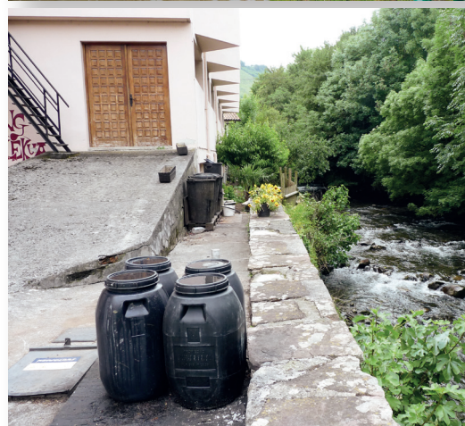
Figura 53. Adaptación de accesos al edificio y cambio de usos de planta baja. Fuente: arriba: CCS y abajo: Inclam.
