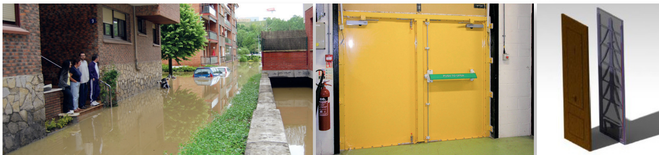
Figura 48. Izq.: edificio con escalones a la entrada. Fuente: DGPCyE. Centro: puerta estanca permanente. Fuente: Flood control internacional. Dcha.: módulo anti-inundaciones adaptable a puertas. Fuente: Ingeliur.
