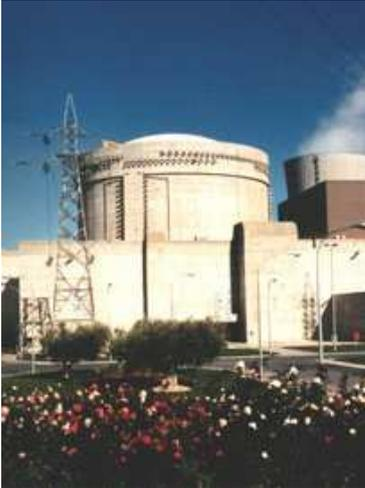
**Figura 2.7 Imagen de la cúpula de hormigón de alta densidad de la central nuclear de Ascó (elaboración propia)**
