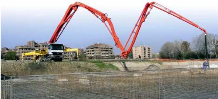
En la figura 2.5 podemos apreciar un camión bomba típico de este tipo de sistema de colocación.
