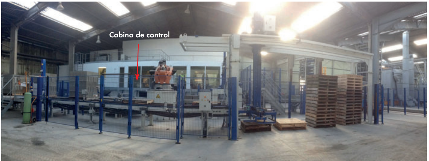
En el centro de la línea de producción se encuentra una cabina de control con aislamiento acústico
