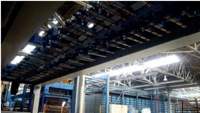
Colocación automática del marco de acero
