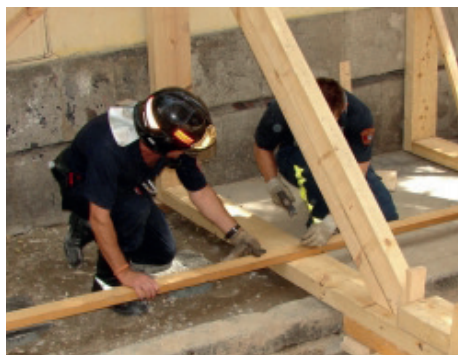
Figura 2.2. Apuntalamiento de emergencia.
