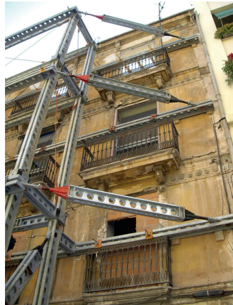
Figura 2.8. Apeo de fachada (Valencia).
