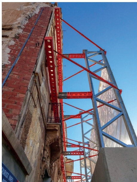
Figura 2.13. Apeo en fachada (Ayora). Fuente: V. Yepes.
