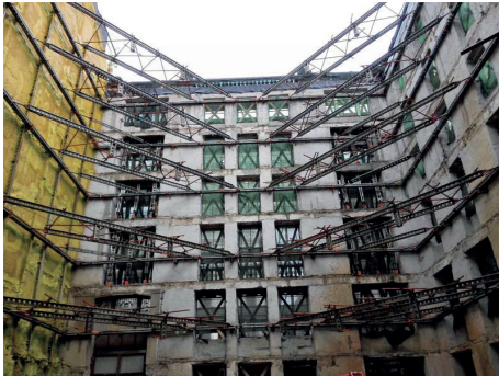
Figura 2.9. Sistema de estabilización de fachada interior.
