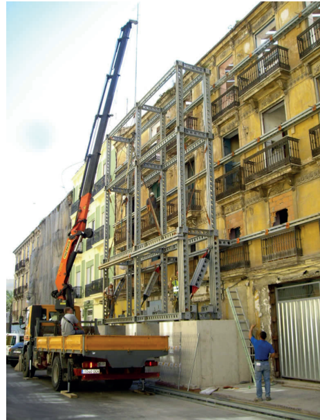
Figura 2.3. Apeo de un edificio en Valencia.
