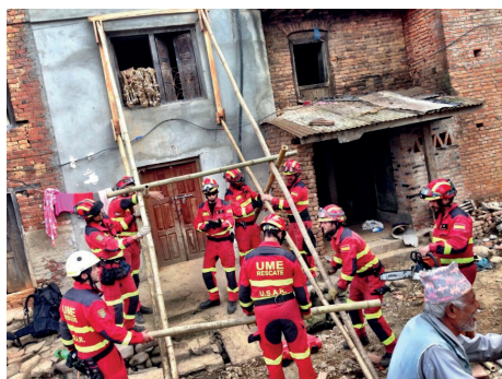
Figura 2.14. Rescate urbano. Fuente: UME Ministerio de Defensa España. https://rescateurbanousar.wordpress.com/category/apuntalamiento/
