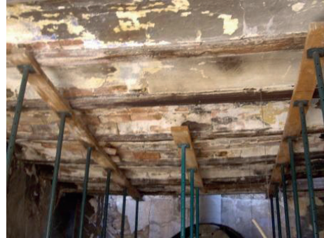
Figura 2.1. Detalle del apuntalamiento de un forjado de madera.
