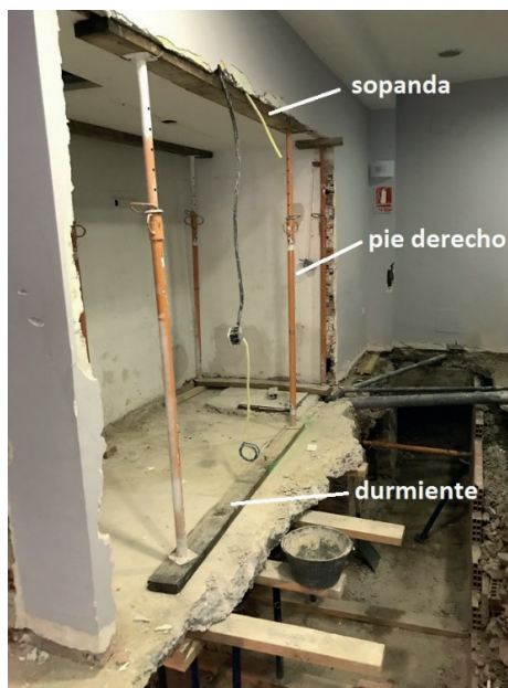
Figura 2.7. Componentes de un apeo/apuntalamiento.
