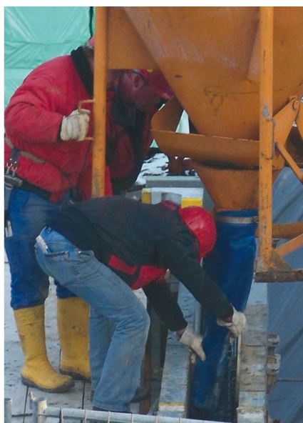
Imagen 5. Vertido de elementos verticales con cubilote con manga.
