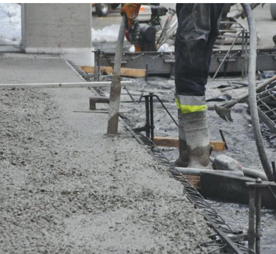
Imagen 9. Proceso de vibrado de un elemento horizontal donde se aprecia el correcto compactado.
