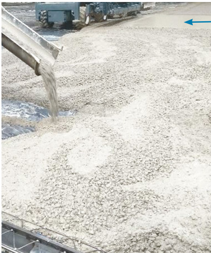
Imagen 3. En esta foto apreciamos que el vertido se realiza contra la masa ya colocada y al fondo se puede ver el acabado brillante de la superficie compactada.
