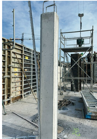
Imagen 6. Aspecto del acabado de la superficie en pilares con hormigón fluido.
