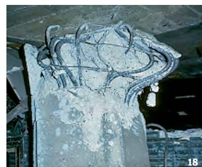
Fig. 18: rotura por aplastamiento, pandeo de las armaduras.
