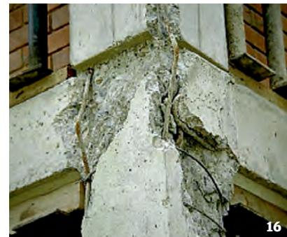
Fig. 16: rotura con pandeo de las armaduras.
