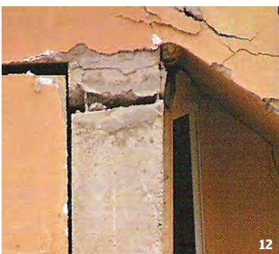
Las fisuras de retracción plástica se producen en las primeras horas del fraguado del hormigón (1 a 6 horas), pudiendo prolongarse hasta varias semanas. Las de retracción de secado o hidráulicas se producen durante la fase final de su proceso de endurecimiento; suelen aparecer a las dos o tres semanas del vertido, llegando en condiciones normales al año, retardándose a veces hasta los dos o tres años.
