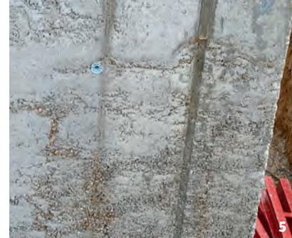
Fig. 3: deficiente replanteo y grifado de armaduras.
