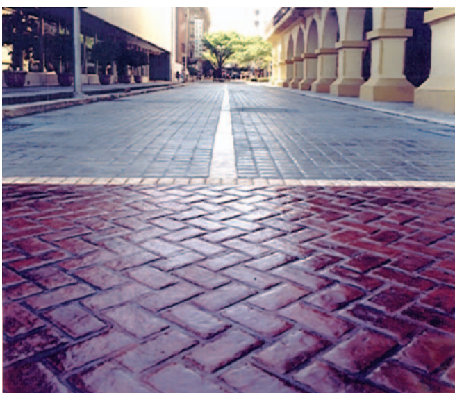
Foto No.7: Estampado del concreto de una vía para mejorar su apariencia.
