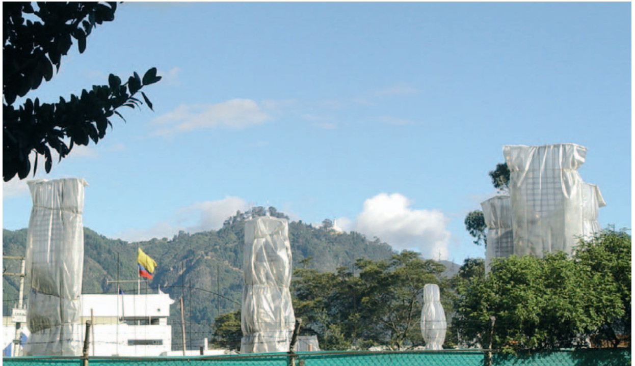
Foto No.1: Curado de columnas de concreto envolviéndolas con plásticos.
