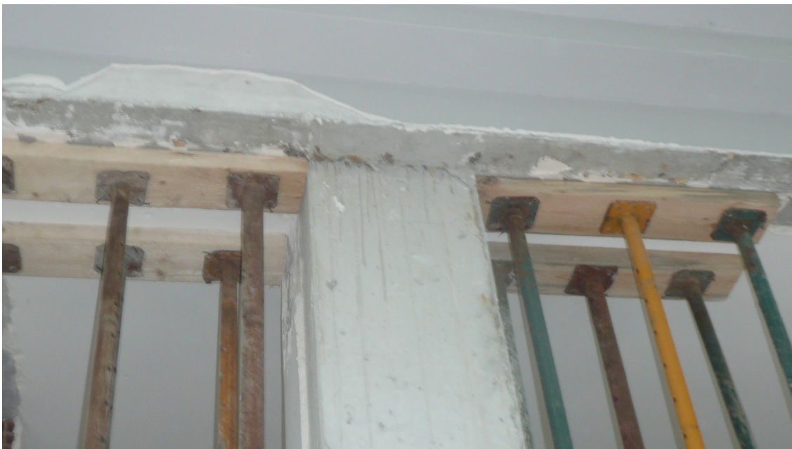
Apeo complementario. Puntales metálicos para soportar el forjado o viga semi-empotrada y así descargar el pilar de hormigón. Se observa que el apeo es equivalente a ambos lados del pilar, esto favorece a disminuir su momento negativo en el nudo de viga o forjado y pilar.
