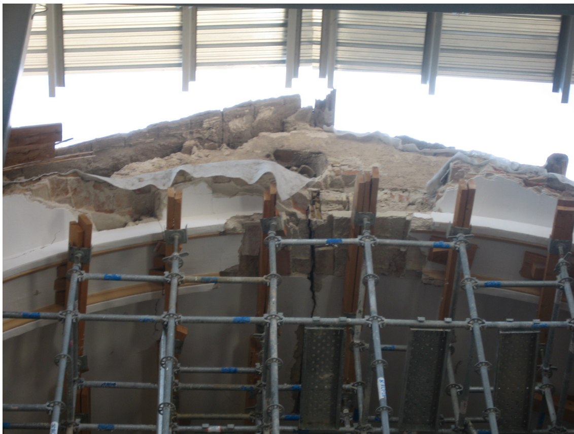
FIGURA. Colapso del crucero de la iglesia de Santiago. Apeo supletorio , mediante puntales telescopios de acero y bridas fijas y giratorias de dos tipos de diámetros. La opción de ejecutar un apeo de supletorio como el que se muestra en la foto permite realizar operaciones de reparación globales o parciales por razones técnicas.
