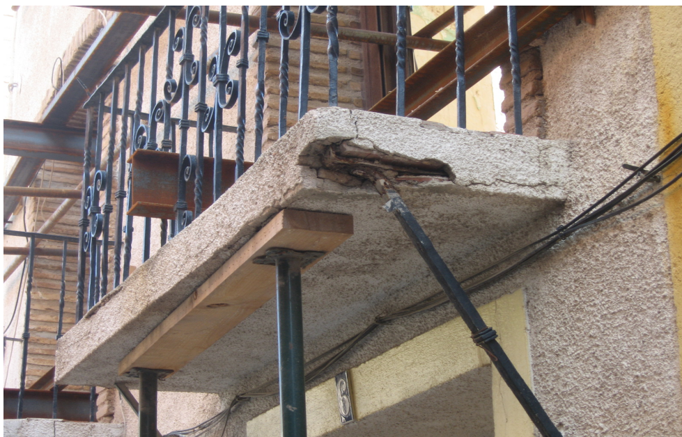
En la fotografía se aprecia un apeo supletorio del voladizo y un apeo de refuerzo alternativo para mantener la fachada una vez demolido el interior del edificio.
