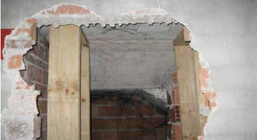
Figura 8.36 Apeo de urgencia sencillo.
