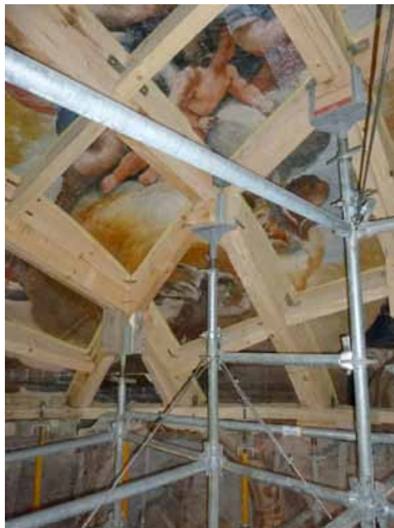
Figura 8.56. Apoyo supletorio de bóveda formado con un andamio estructural tipo Sistema Peri Up Rosett, mediante puntales telescópicos o tubos de acero a los que se sueldan cada 50 cm. rosetas del tipo Peri Up Rosett.
