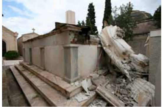
Figura 9.62. Panteón Cementerio San Clemente. Vuelvo de elementos arquitectónicos.
