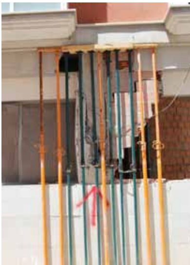
Apuntalamiento de urgencia. Lorca Mayo 2011
