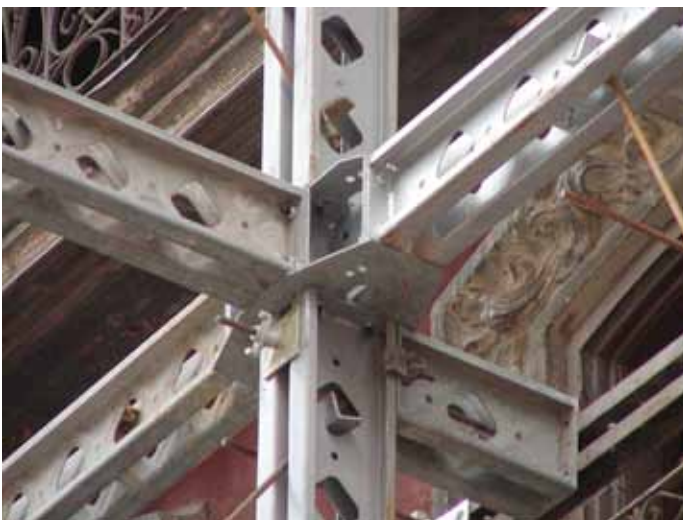
Figura 8.53. Estructura externa de sustentación de Fachada.
