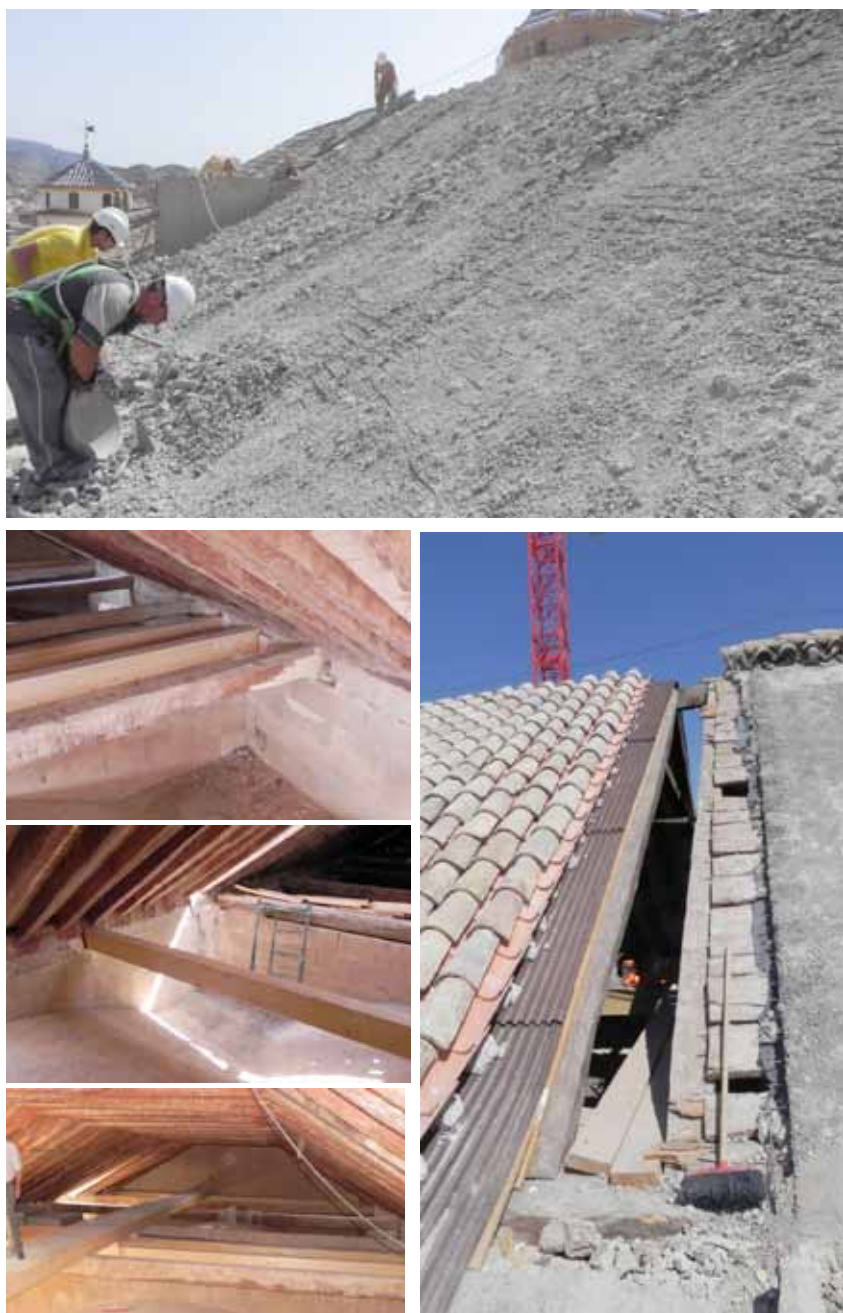
Figura 9.53. Diversas fotografías de la reparación de la cubierta de la nave central en la Ex Colegiata de San Patricio.
