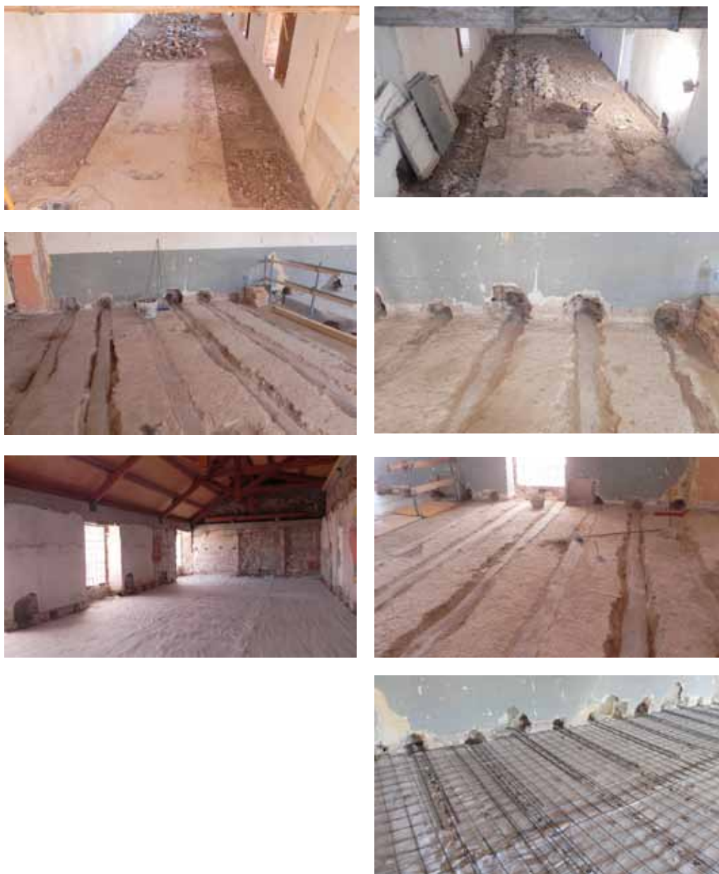
Figura 9.51. Diversos momentos de los trabajos de saneado de viguetas mediante prótesis de láminas encoladas con resorcina y la recuperación de la capacidad portante de los forjados del Monasterio de San Francisco.
