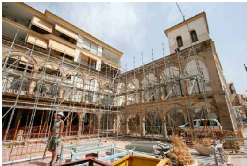
Figura 9.64. Claustro de Santo Domingo. Desmontaje de sillares.
