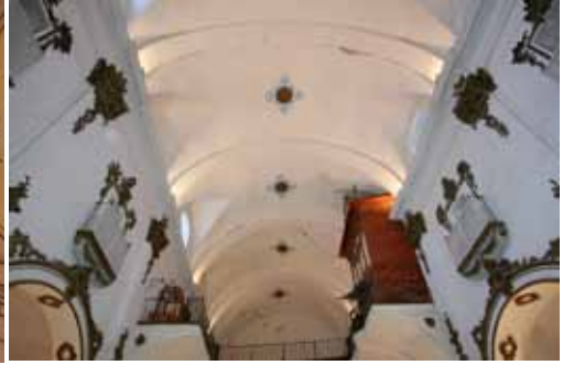
Figura 4.158. Iglesia de San Francisco. Bóveda nave central.
