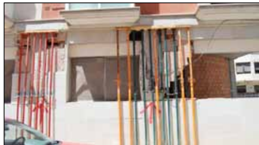
Figura 10.39. Apuntalamiento de emergencia.
