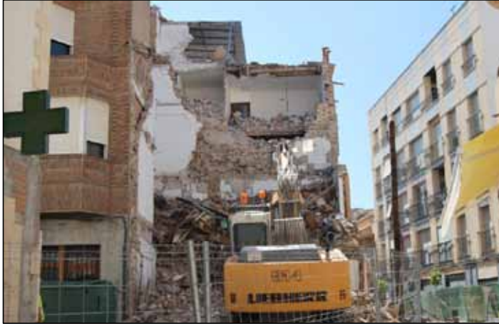
Figura 10.42. Demolicion de edificación mecanicamente. Cerramiento perimetral.
