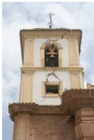
Figuras 4.88, 4.89 y 4.90: Esquema de fractura cruzada en torre campanario, e imagen de la torre de la iglesia de Santiago. Lorca.
