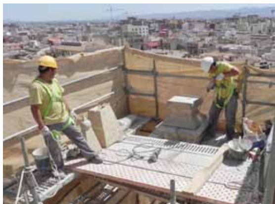
Figura 9.3. Intervenciones de emergencia para retirar las imágenes, pináculos u otros elementos inestables o peligrosos, tras los terremotos de mayo de 2011. Arriba, Nuestra Señora del Carmen; Centro: Ex Colegiata de San Patricio; Debajo: Iglesia de Santiago.
