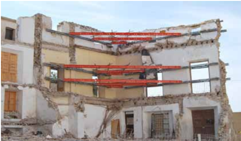
Figura 8.47 Arriostramiento de muros con sistemas industrializados
