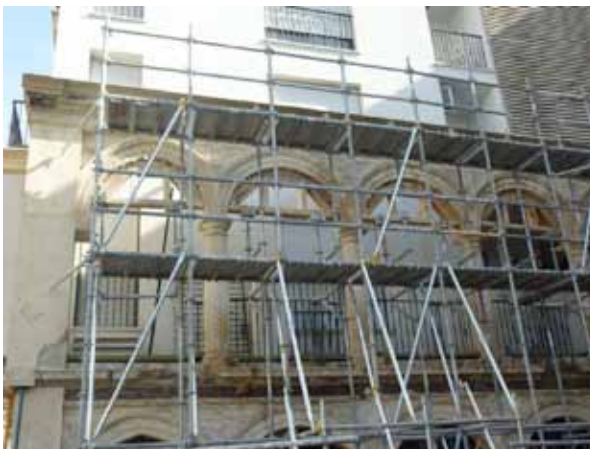
Figura 8.54. Sistema de andamio estructural, realizado a base de tubos de acero con rosetas soldadas al mismo cada 50 cm. para facilitar el anclaje de piezas transversales o inclinadas. En este caso usado como sistema de apeo, con montaje rápido que garantiza el arriostramiento eficaz.
