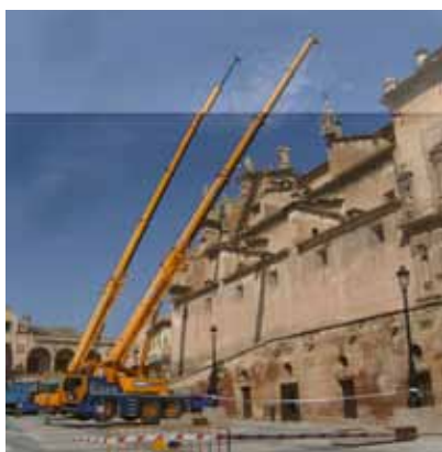
Figura 9.3. Intervenciones de emergencia para retirar las imágenes, pináculos u otros elementos inestables o peligrosos, tras los terremotos de mayo de 2011. Arriba, Nuestra Señora del Carmen; Centro: Ex Colegiata de San Patricio; Debajo: Iglesia de Santiago.
