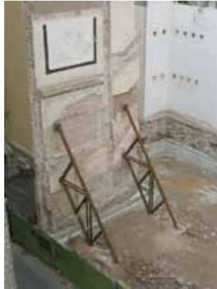
Figura 8.31. Apeos de muro.
