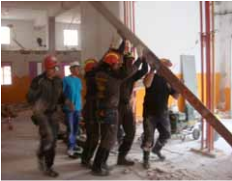
Figura 8.11 Montaje de un apuntalamiento de urgencia con perfiles metálicos.
