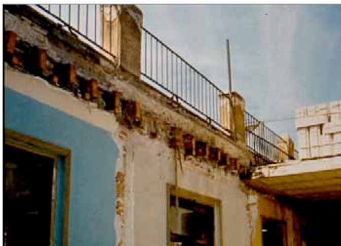
Figura 10.13. Rehabilitación de edificio en Murcia, con vigería de madera.
