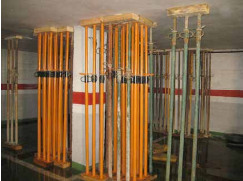
Figura 8.18. Apeo supletorio: Tornapuntas metálicas verticales con durmientes y sopandas de madera
