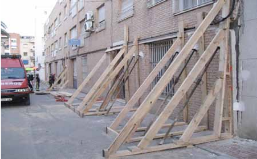
Figura 8.26 Apeo provisional, cerramiento planta baja. Lorca. Mayo 2011.
