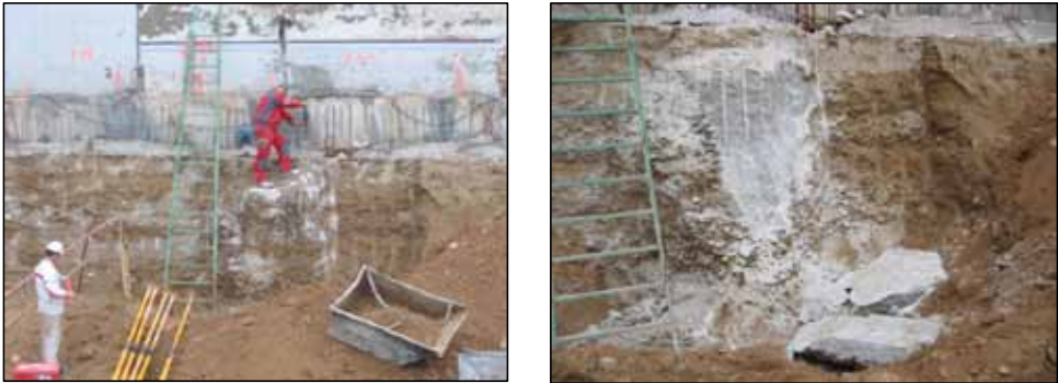
Figura 10.29. Rotura de Zapata hormigón con Morteros expansivos.
