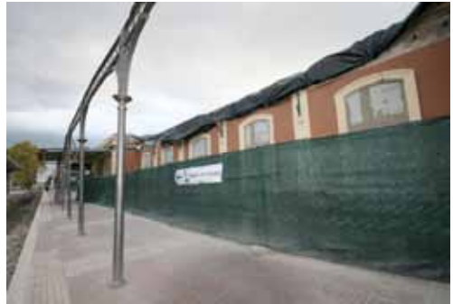
Figura 4.119: Estación de ferrocarril Lorca-Sutullena.
