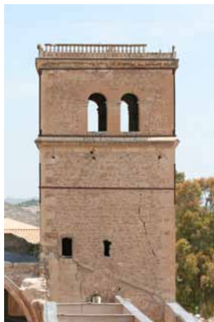
Figura 4.178. Torre de la Iglesia de Santa María.
