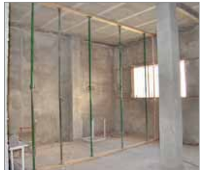
Figura 8.67. Forjado Unidireccional. Sopandas y Durmientes.
