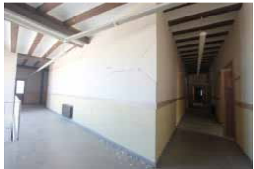
Figuras 4.140 y 4.141. Conservatorio. Grietas verticales e inclinadas en particiones interiores.
