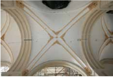
Figura 4.164. Iglesia Santiago. Bóveda nave lateral.
