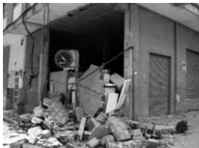
Figura 3.13. Fractura de elementos constructivos no estructurales durante el terremoto de Lorca 2011.
