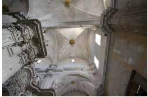
Figura 4.113: Bóvedas arista nave central y laterales.
