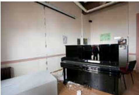
Figuras 4.140 y 4.141. Conservatorio. Grietas verticales e inclinadas en particiones interiores.
