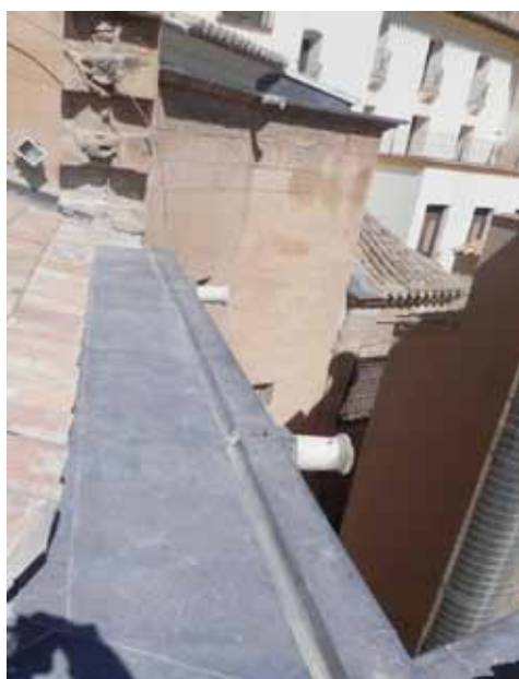
Figura 9.57. Diversas fotografías con la recuperación de cubiertas, aleros y emplomados en la Ex Colegiata de San Patricio.
