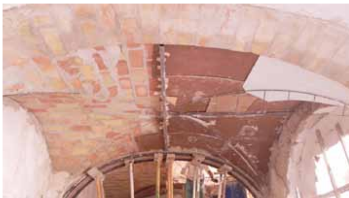
Figuras 4.5 y 4.6: Detalles de la restauración de bóvedas partidas o desplomadas, mediante la ejecución de una o dos rosas de ladrillos, tomados con cal y yeso.
