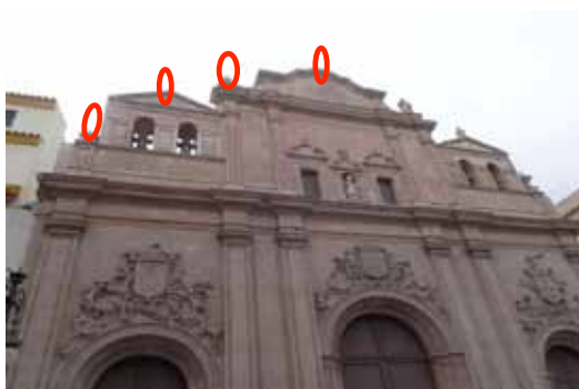
Figura 9.3. Intervenciones de emergencia para retirar las imágenes, pináculos u otros elementos inestables o peligrosos, tras los terremotos de mayo de 2011. Arriba, Nuestra Señora del Carmen; Centro: Ex Colegiata de San Patricio; Debajo: Iglesia de Santiago.
