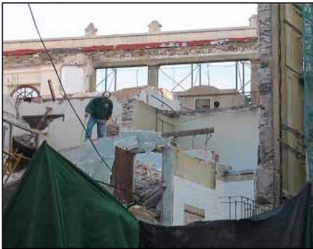
Figura 10.24. Demolición manual en propio centro de trabajo y Martillo neumático manual.
