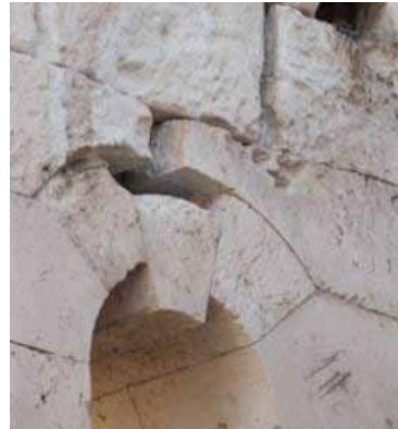
Figura 4.63: Descenso de clave en arco en La Colegiata, Lorca.
