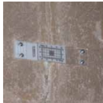
Figuras 4.19 y 4.20: Testigo de yeso y fisurómetro de metacrilato.
