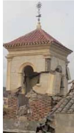
Figuras 4.96 y 4.97: Esquema e imagen de deslizamiento. Torre de la Iglesia del Convento de Clarisas. Lorca.
