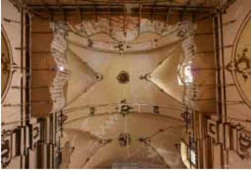
Figura 4.157. Capilla del Rosario. Bóveda nave central.
