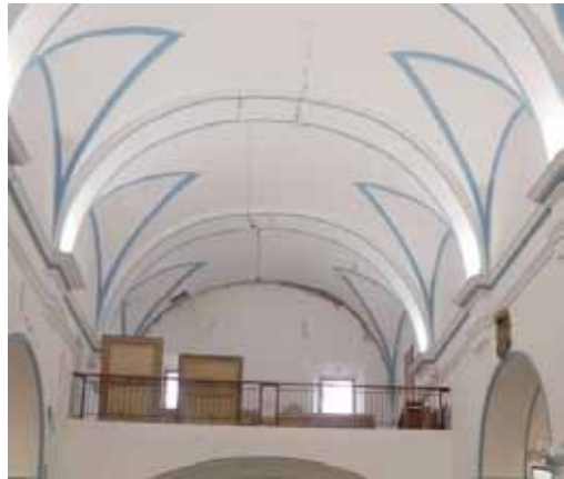
Figuras 4.69 y 4.70: Línea de rotura que recorre espigano de bóvedas y arcos en la Iglesia de Santiago y San Diego. Lorca.
