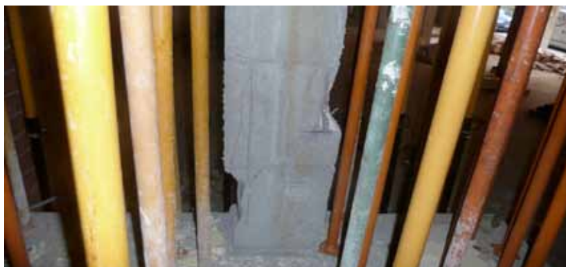
Figura 8.5. Edificio situado en calle Castilla, de Lorca.
