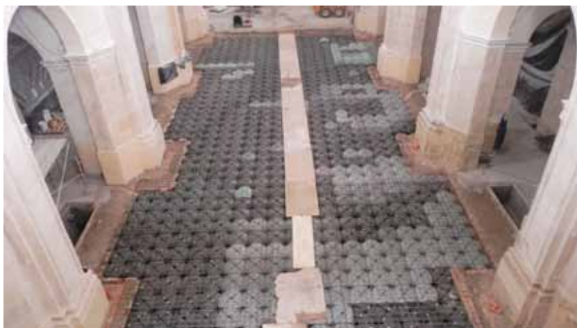
Figura 4.7: Ejecución de la solera ventilada en la Iglesia de San Mateo, a base de casetones de PVC, combinando estos con cámaras perimetrales en torno a las pilastras, a los muros, e incluso para la instalación de los sistemas de climatización
