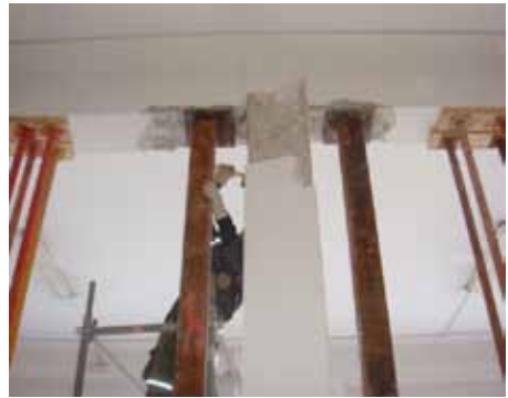
Figura 8.11 Montaje de un apuntalamiento de urgencia con perfiles metálicos.
