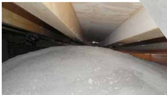
Figura 9.42. La cúpula de la Capilla del Sacramento en la Iglesia de Santiago, durante los trabajos de su reconstrucción, a base de roscas tabicadas, así como la nueva estructura de madera de la cubierta.
