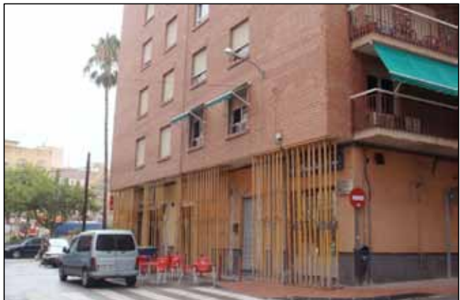
Figura 8.1. Apeo provisional en voladizo de fachada
