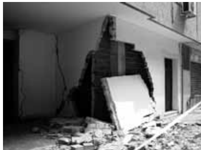
Figura 3.13. Fractura de elementos constructivos no estructurales durante el terremoto de Lorca 2011.
