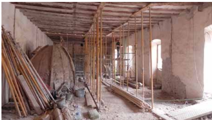
Figura 9.10. Primer ajeo de los forjados de las estancias sobre la sacristía de la Iglesia de Nuestra Señora del Carmen
