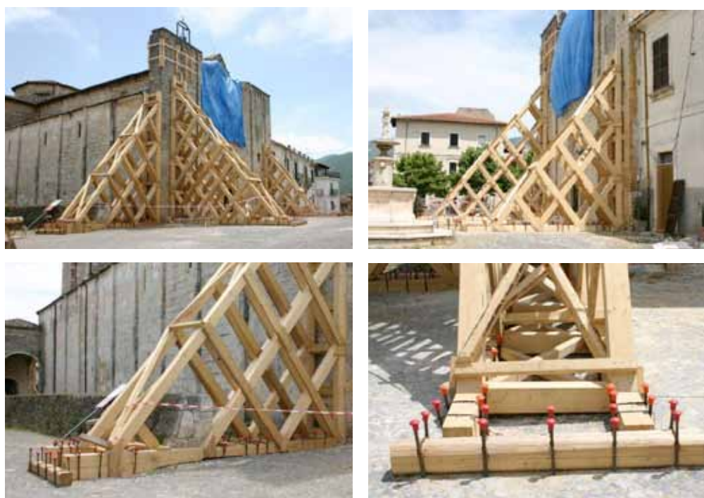
Figura 9.18. Apeos de estabilización de fachadas colocados en la Iglesia de San Eustaquio Forconese (Eusanio) en la localidad de L'Aquila, tras el terremoto de los Abruzzos Italianos en Abril del año 2.009
