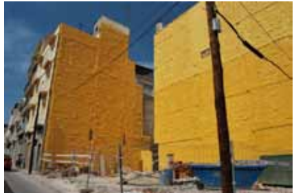
Figura 10.36 Estado de medianeras después de la demolición.
