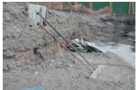
Figura 8.27 Detalle apeo cimentación. Broto, Apeo cimentación.
