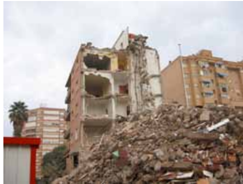
Figura 10.37. Demolición por medios mecánicos. Edificio Trafalgar. Cartagena.
