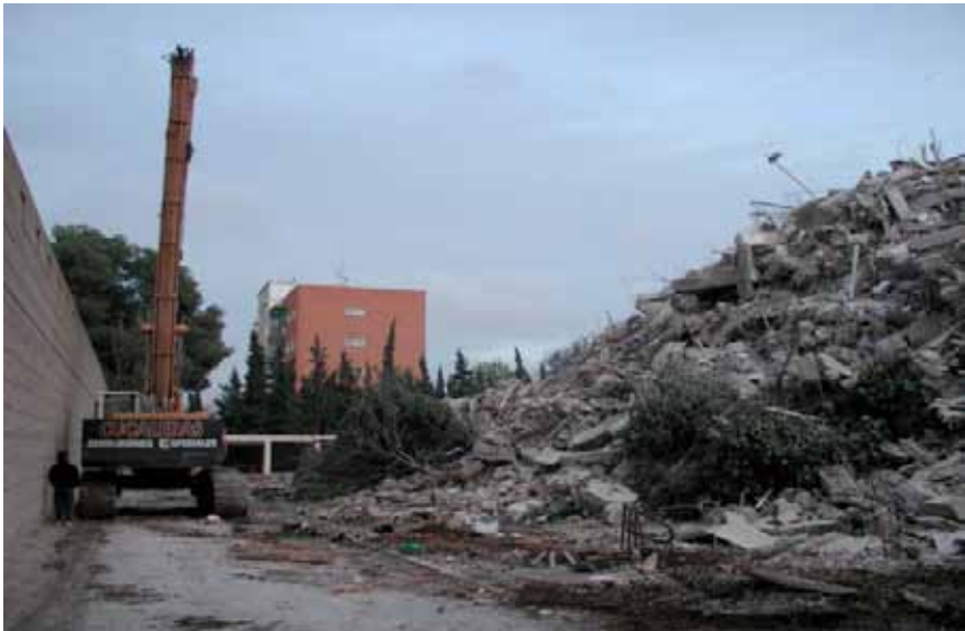
Figura 10.6 Eliminación de escombros.
