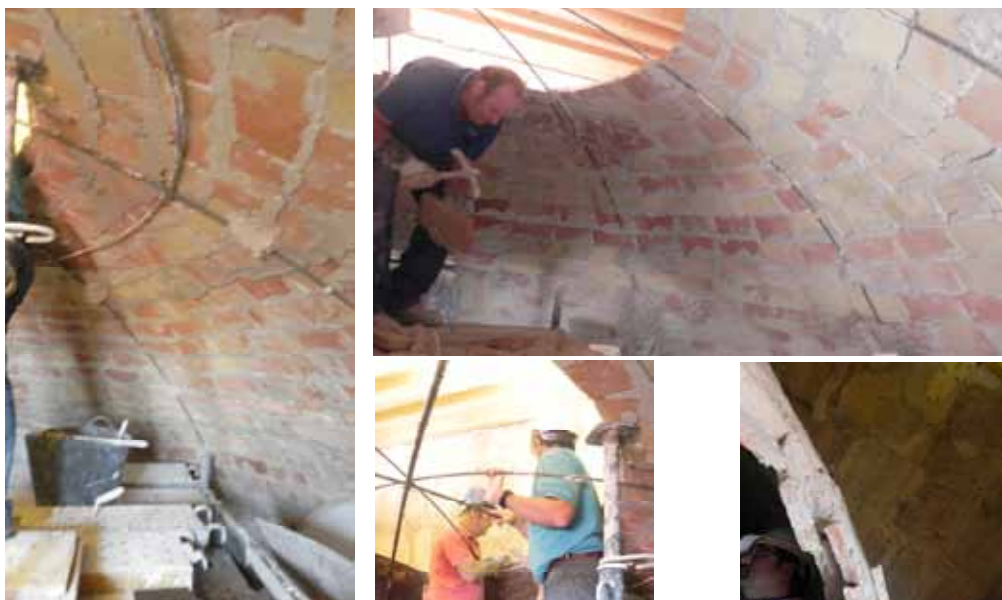
Figura 9.41. La cúpula de la Capilla de la Epístola en la Iglesia de Santiago, durante los trabajos de su reconstrucción, a base de roscas tabicadas.
