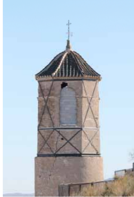
Figura 4.180. Torre de la Iglesia de San Juan.
