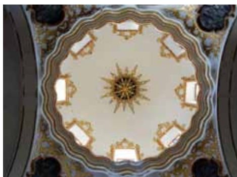
Figura 4.117: Cúpula de la Iglesia del Carmen.
