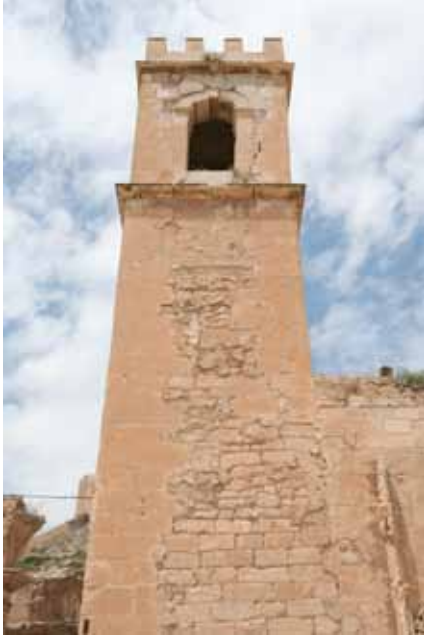
Figura 4.179. Torre de la Iglesia de San Pedro.
