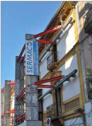
Figura 8.12 Montaje de estabilizadores de urgencia de perfilaría metálica industrializada.
