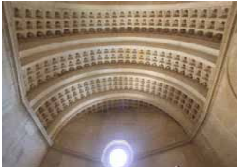
Figura 4.110: Bóveda de la sacristía. Colegiata.
