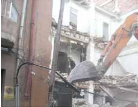
Figura 10.21. Maquinaria con cuchara y Pulpo recogedor.
