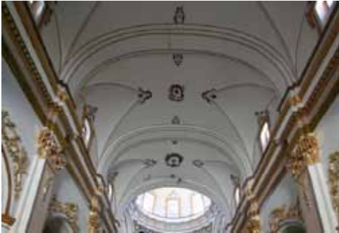
Figura 4.159. Iglesia del Carmen. Bóveda nave central.
