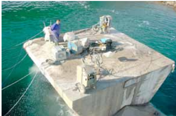
Figura 10.33. Puente del Estacio (La Manga), Cortado por hilo diamantado.
