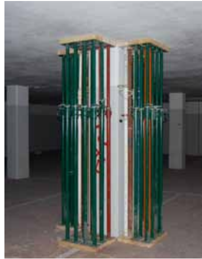
Figura 8.29 Apos de Urgencia: Daños en cabeza pilar y refuerzo en pilar inferior.
