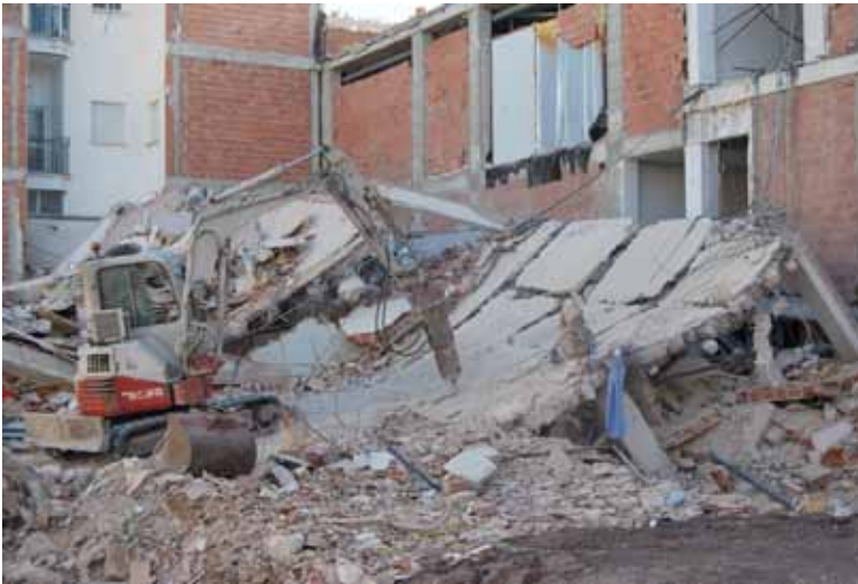
Figura 10.11 Demolición de un forjado reticular. Lorca Mayo 2011.
