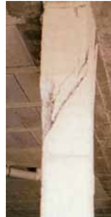
Figura 3.18. Agrietamiento inclinado de pilar. (Fuente: (a) Calavera, 2005. (b) Fernández, 1994)
