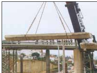
Figura 10.30. Corte de puente con sierra adiamantada.
