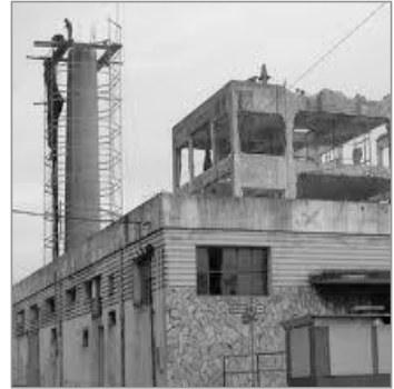
Figura 10.15. Demolición de chimenea.
