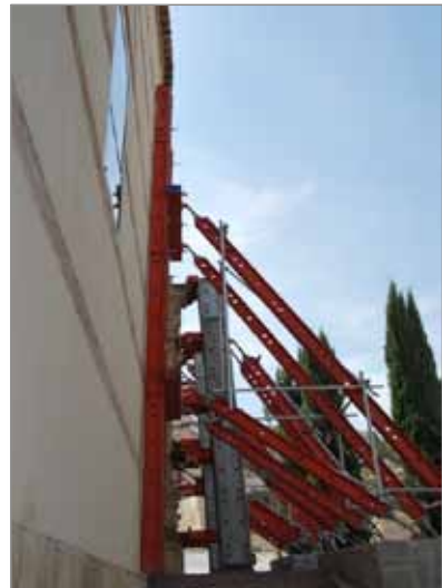
Figura 8.12 Montaje de estabilizadores de urgencia de perfilaría metálica industrializada.
