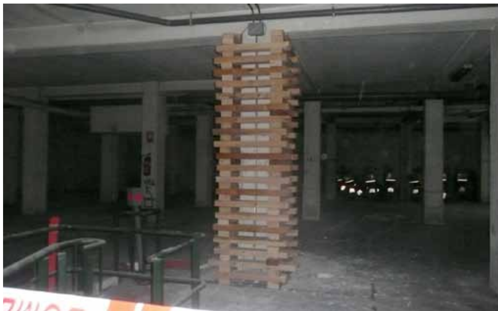
Figura 8.10. Diseño de apeo complementario de pilar y su protección. Edificio Residencial San Mateo, de Lorca.
