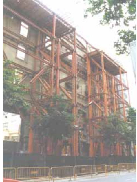
Figura 10.14. Estabilizadores de fachada. Madrid.
