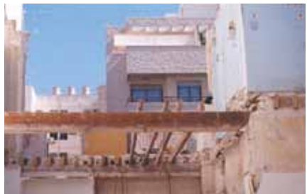
Figura 10.3. Demolición de edificio medianero.
