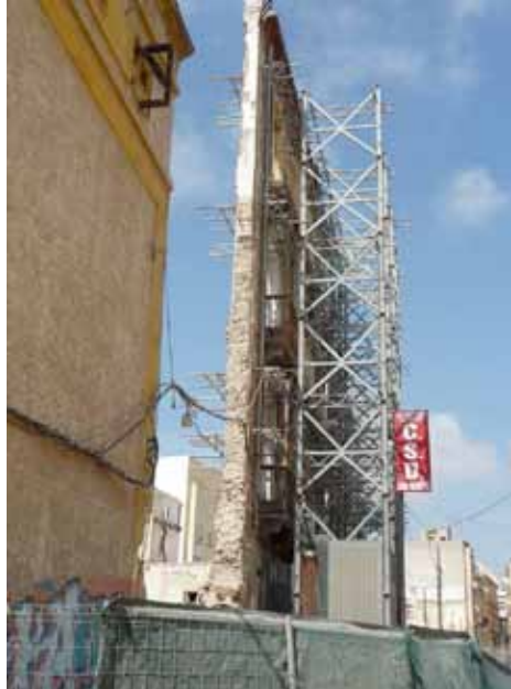
Figura 8.51 a. Fachada en Lorca.
