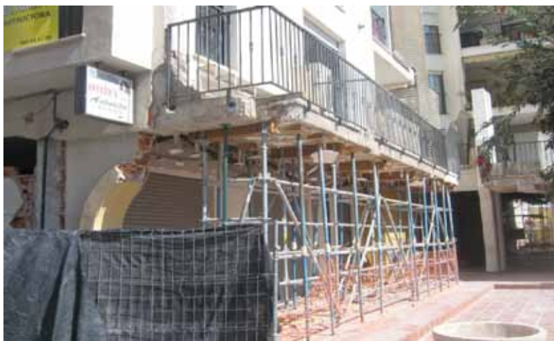
Figura 8.48 Apeo supletorio de un forjado en voladizo o balcón, en Lorca.
