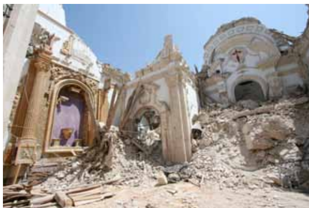
Figura 9.59. Iglesia de Santiago. Retirada de material desplomado.
