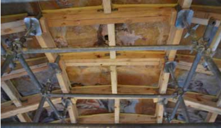
Figura 8.3 Iglesia de Santo Domingo. Lorca. CIMBRADO DE BOVEDA.
