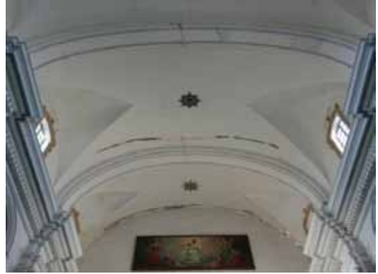
Figuras 4.57 y 4.58: Esquema de mecanismo de daño por deformación simétrica. Deformación con descenso de flecha, grieta en la clave, o cercana a ella. También se observan grietas de separación con la bóveda, Iglesia de San Mateo. Lorca.
