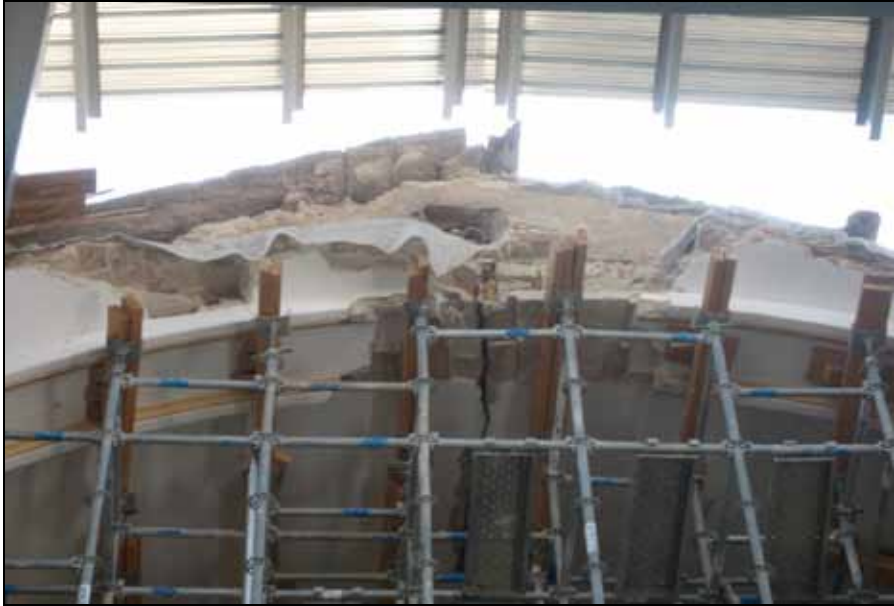
Figura 8.45. Cimbra soportando el Colapso del crucero de la iglesia de Santiago de Lorca.
