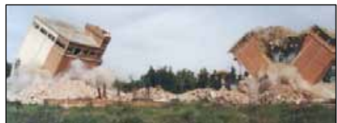
Figura 10.16. Demolición de Silos en Albacete.
