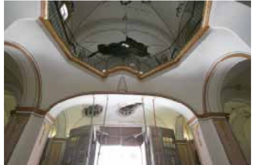
Figura 4.160. Iglesia del Carmen. Bóveda nave central y coro.
