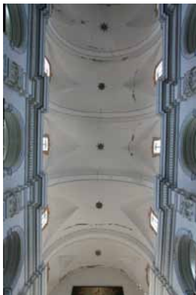
Figura 4.162. Iglesia de San Mateo. Bóveda nave.
