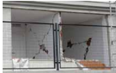
Figuras 4.32 y 4.33: Esquema y fractura cruzada en tabiques tras el sismo en Lorca.
