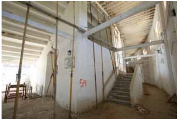
Figura 4.149. Plaza de toros. Muros radiales de ladrillo.
