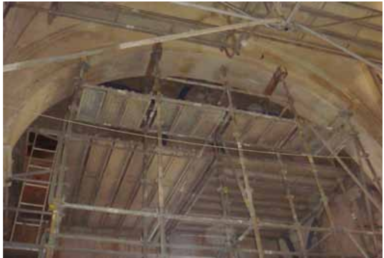
Figura 8.55a. Apeo supletorio para formación de andamio estructural, mediante puntales telescópicos o tubos de acero a los que se sueldan cada 50 cm. rosetas del tipo Peri Up Rosett.
