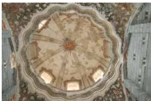
Figura 4.116: Cúpula de la Iglesia de San Juan.
