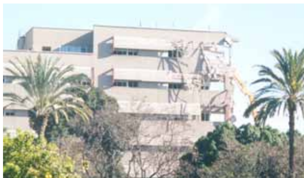
Figura 10.2. Demolición del Hospital Provincial. Murcia.
