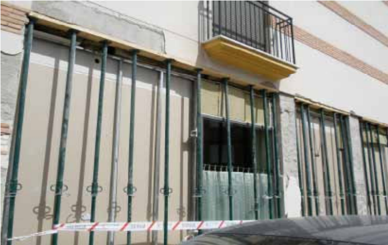
Figura 8.7. Diseño de apeo de pilar.
