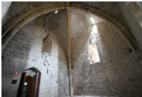
Figura 4.123: Interior primer cuerpo. Torre del Espolón.
