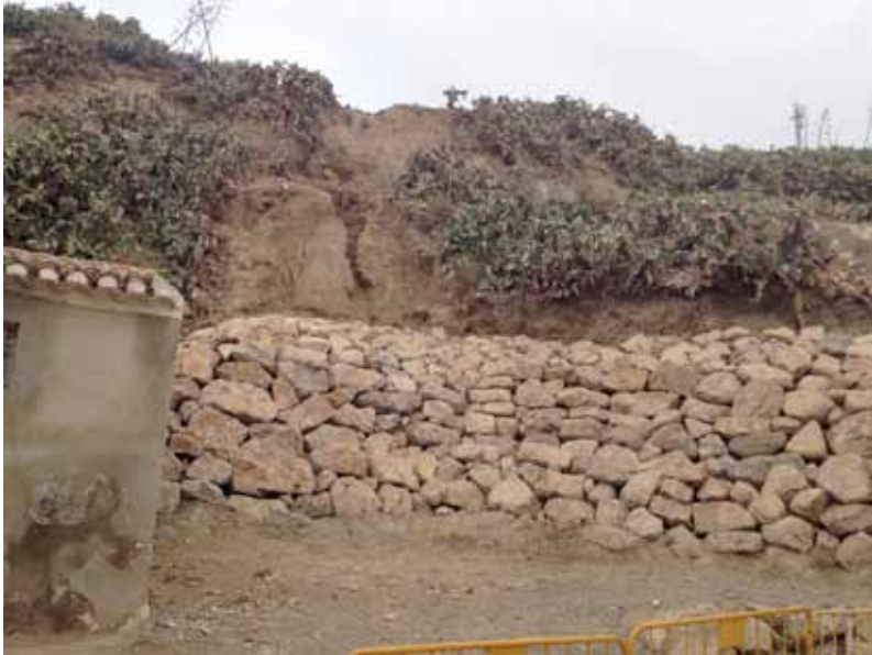
Figura 1.33. Refuerzo de emergencia en base de talud deslizado.
