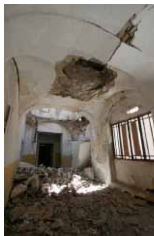
Figuras 4.21 y 4.22 26 : Imagen de colapso de la bóveda de capilla de la iglesia Santiago y claustro de San Francisco en Lorca.
