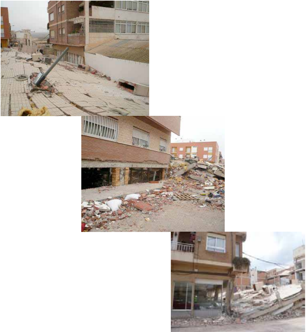
Figura A.1.4. Edificio que colapsó: C/ Infante Juan Manuel esquina C/ de los Talleres
