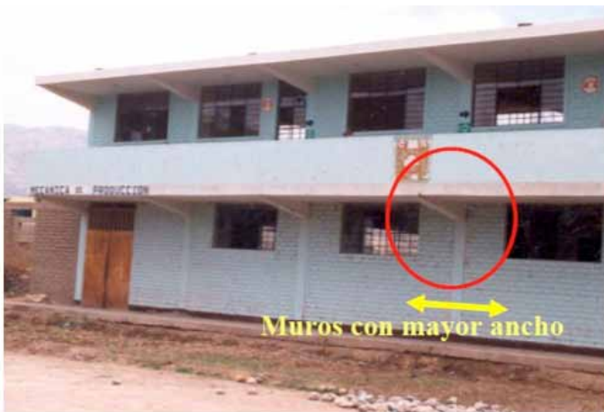
Figura 3.25. Un modo de evitar la formación de columna corta (Fuente: Astorga, 2009)
