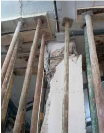
Figura 8.29 Apos de Urgencia: Daños en cabeza pilar y refuerzo en pilar inferior.
