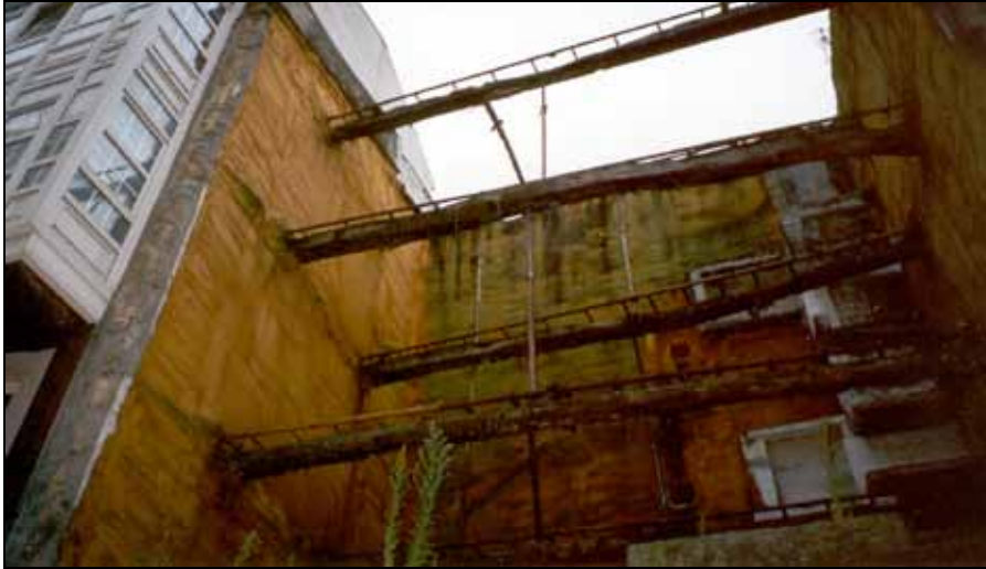
Figura 8.21. Arriostramiento entre dos edificios.
