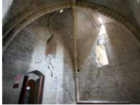
Figuras 4.30 y 4.31 29 : Esquema e imagen de expulsión de esquina con arrastre de bóveda. Torre del Espolón. Lorca.
