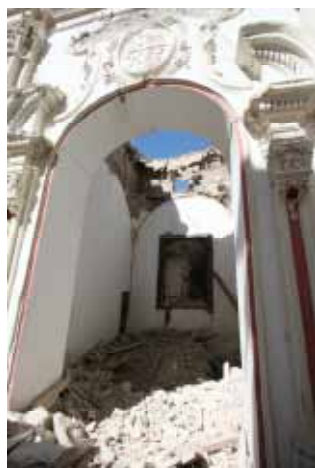
Figuras 4.21 y 4.22 26 : Imagen de colapso de la bóveda de capilla de la iglesia Santiago y claustro de San Francisco en Lorca.
