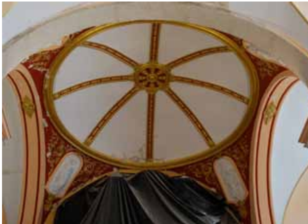
Figura 4.171. Iglesia de San Cristóbal. Cúpula.
