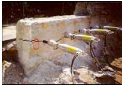
Figura 10.28. Rotura con gatos hidráulicos.
