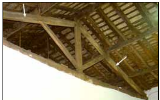
Figura 10.12. Viguetas apoyadas en jácena y soportes en madera y Cerchas de madera.
