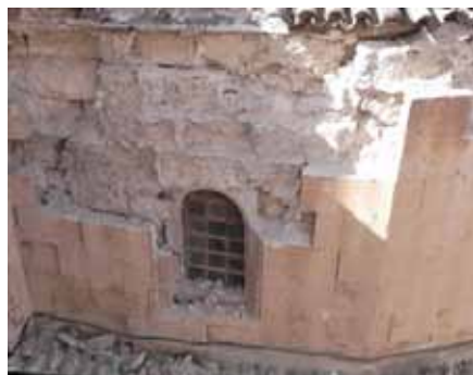
Figuras 4.39 y 4.40 33 : Esquema de posibles daños por separación entre hojas, e imagen de daños, Lorca.
