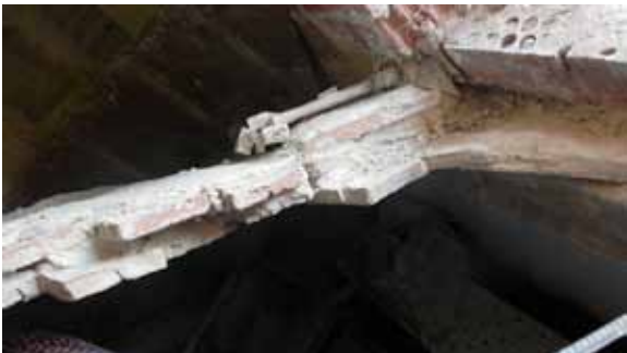
Figura 9.40. La cúpula de la Capilla del Sagrario en la Iglesia de Santiago, en el estado en el que quedó tras el sismo y posterior desescombro
