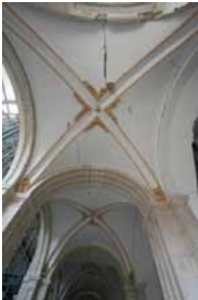
Figuras 4.69 y 4.70: Línea de rotura que recorre espigano de bóvedas y arcos en la Iglesia de Santiago y San Diego. Lorca.
