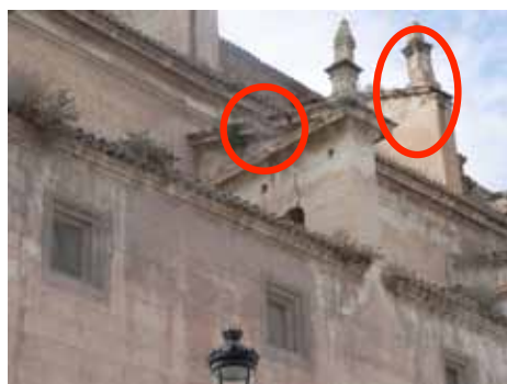
Figura 9.3. Intervenciones de emergencia para retirar las imágenes, pináculos u otros elementos inestables o peligrosos, tras los terremotos de mayo de 2011. Arriba, Nuestra Señora del Carmen; Centro: Ex Colegiata de San Patricio; Debajo: Iglesia de Santiago.
