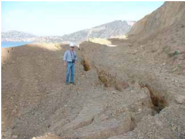
Figura 1.19. Cabecera de una rotura circular incipiente.
