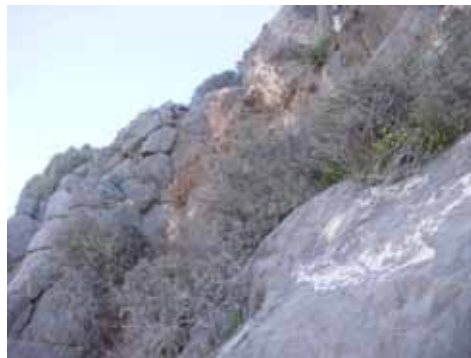
Figura 1.12. Afloramiento rocoso, fuente de desprendimientos.
