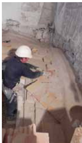
Figuras 4.5 y 4.6: Detalles de la restauración de bóvedas partidas o desplomadas, mediante la ejecución de una o dos rosas de ladrillos, tomados con cal y yeso.
