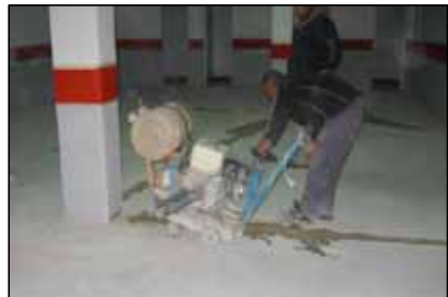
Figura 10.31. Disco de corte en Solera de hormigón.
