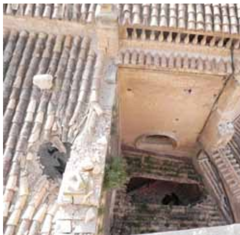
Figuras 4.103 y 4.104 48 : Esquema e imagen derrumbe parcial de cubierta de la Colegiata por impacto en Lorca.
