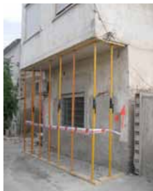
Figura 8.15. Apuntalamiento en voladizo de edificación.
