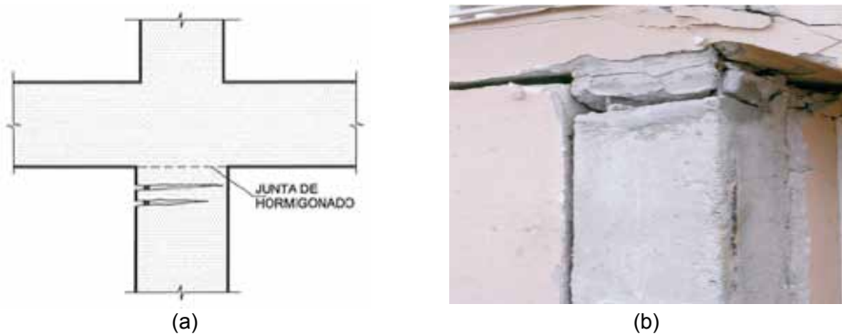
Figura 3.20. (a) Fisura horizontal en cabeza de pilar (Fuente: Calavera, 2005). (b) Pilar agotado por agrietamiento horizontal (Fuente: Muñoz, 2009)
