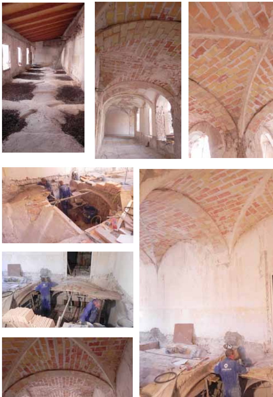
Figura 9.38. Diversas fotografías de la reparación de las bóvedas del claustro de San Francisco (por el trasdós e intradós)
