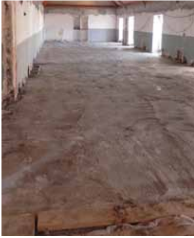
Figura 9.52. Diversos momentos de los trabajos de recuperación de la capacidad portante de los forjados del Monasterio de San Francisco, mediante tornillos berraqueros y capa de compresión con arlita.
