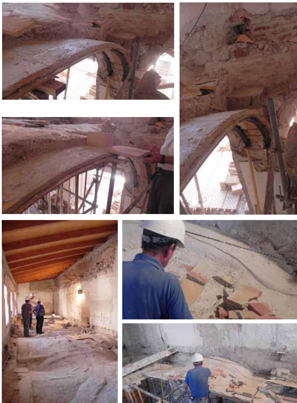
Figura 9.37. Diversas fotografías de la reparación de las bóvedas del claustro de San Francisco (por el trasdós e intradós)
