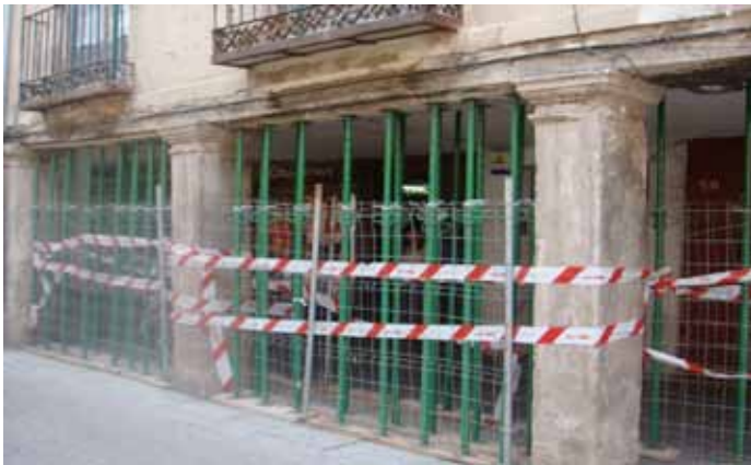
Figura 8.22. Apeo de una edificación en el centro de Guadalajara.
