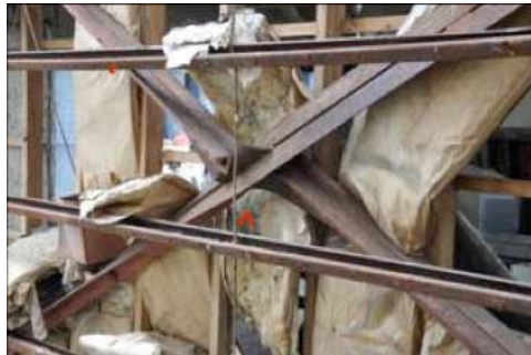
Figura 2.12. Pandeo lateral de las diagonales (Fuente: Ávila, 2011)
