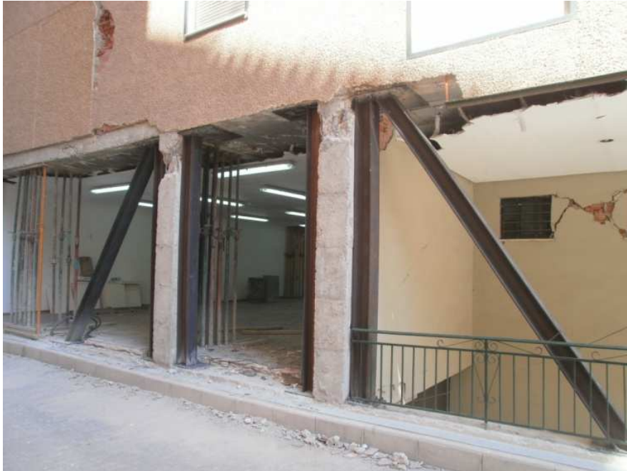
Figura 3.76. Apeo a base de perfiles metálicos. Fuente. Autor (terremoto de Lorca)
