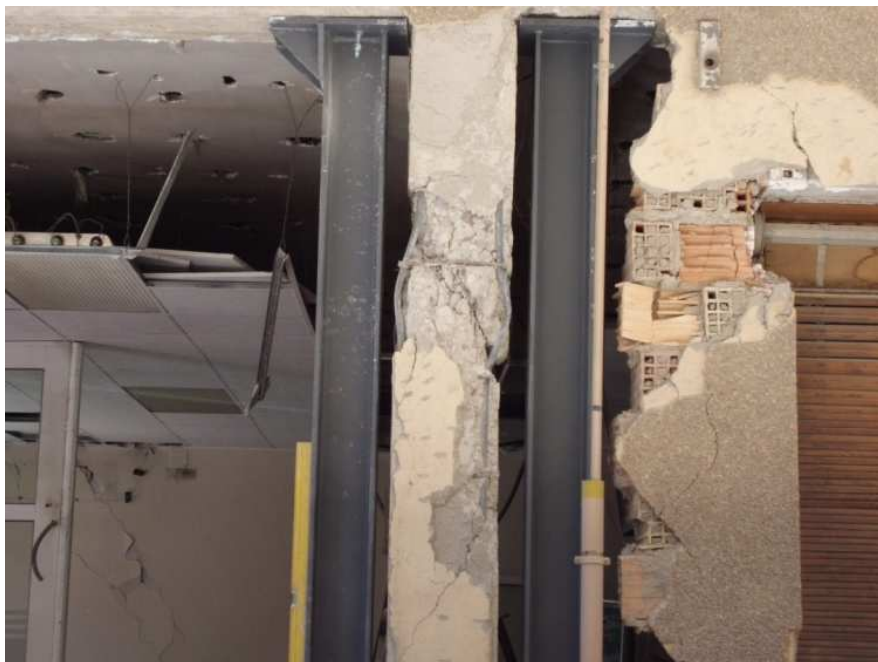
Figura 3.77. Apeo a base de perfiles metálicos. Fuente. Autor (terremoto de Lorca)
