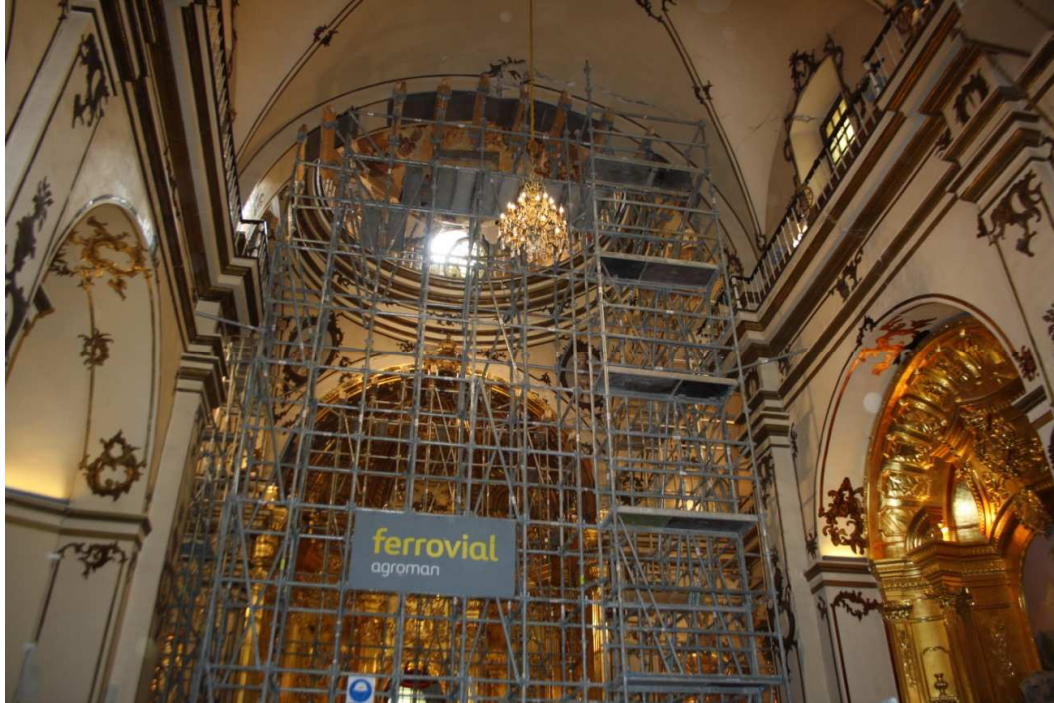
Figura 4.40. Apeo de arco mediante estructura modular Fuente: Autor (Lorca 2011)
