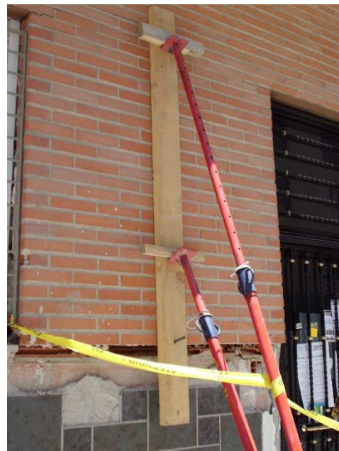
Figura 3.28. Apeo de fachada (Lorca 2011) Fuente. Autor.
