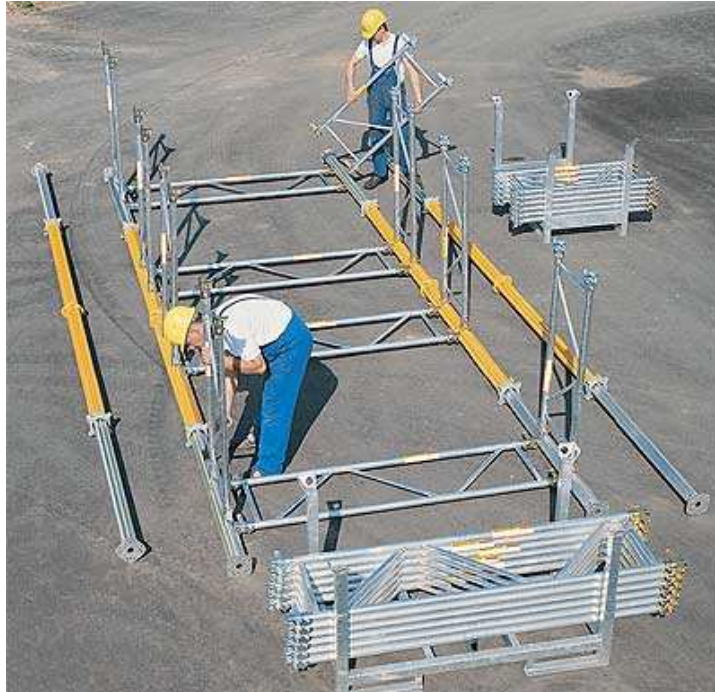
Figura 3.72. Ejecución de torres de carga con sistema Multiprop Fuente. www.Peri.es
