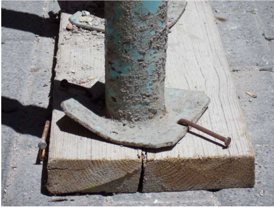
Figura 3.13. Fotografía de Apuntalamiento (Lorca 2011) Fuente. Autor
