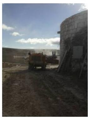
Se ha realizado la obra durante el mes de octubre de 2012. En total se realizaron 91 anclajes de 9,5 m de profundidad (11 de diámetro 40 mm y 80 de diámetro 32 mm). El rendimiento medio acumulado a origen se situó en 42 ml/día.
