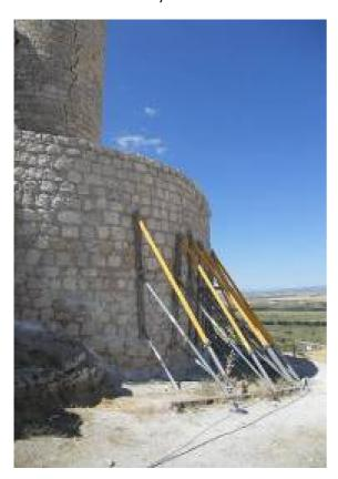
Desde el punto de vista de la producción de la obra, el mayor condicionante de la misma ha sido que los cubos 3 y 4 se encontraban apuntalados y para la instalación del equipo de perforación era necesario desapuntalar parte del mismo, pero retirando el menor número de puntales y tras ejecutado el anclaje volver a apuntalar.
