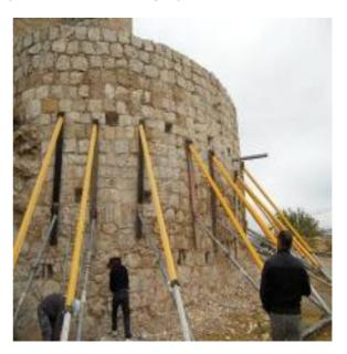
Se han realizado ensayos de tesado en todas las filas de los cubos, a la finalización de los trabajos de tesado, se comprobó que dichos anclajes cumplían lo relativo al ensayo de puesta en carga de un anclaje mediante fases incrementales para la determinación del desplazamiento por fluencia de la cabeza del anclaje. Siendo las cargas de prueba de 30 Tn para los anclajes de las filas inferiores y de 20 Tn para el resto de filas.
