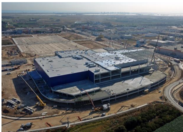
Figura 3.- Complejo IKEA en Alfara (Valencia). Los centros logísticos se han convertido en edificaciones cuya construcción es fundamentalmente industrializada en hormigón, por lo que requieren una mayor implementación de elementos BIM
